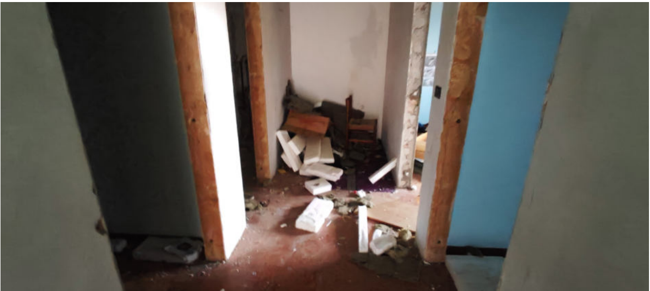
FOTO N.27 FOGLIO 5, MAPPALE 248, SUB.8 COMUNE DI CONCORDIA SAGITTARIA (VE)
