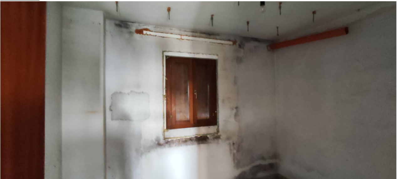
FOTO N.24 FOGLIO 5, MAPPALE 248, SUB.8 COMUNE DI CONCORDIA SAGITTARIA (VE)
