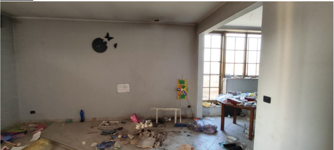
FOTO N.18 FOGLIO 5, MAPPALE 248, SUB.8 COMUNE DI CONCORDIA SAGITTARIA (VE)
