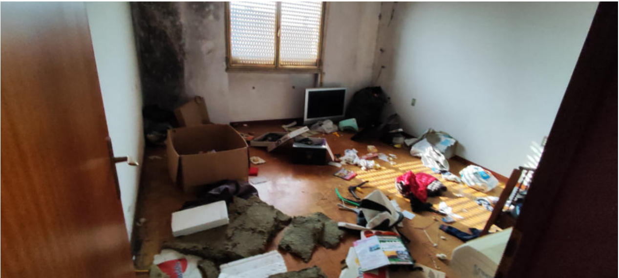
FOTO N.26 FOGLIO 5, MAPPALE 248, SUB.8 COMUNE DI CONCORDIA SAGITTARIA (VE)
