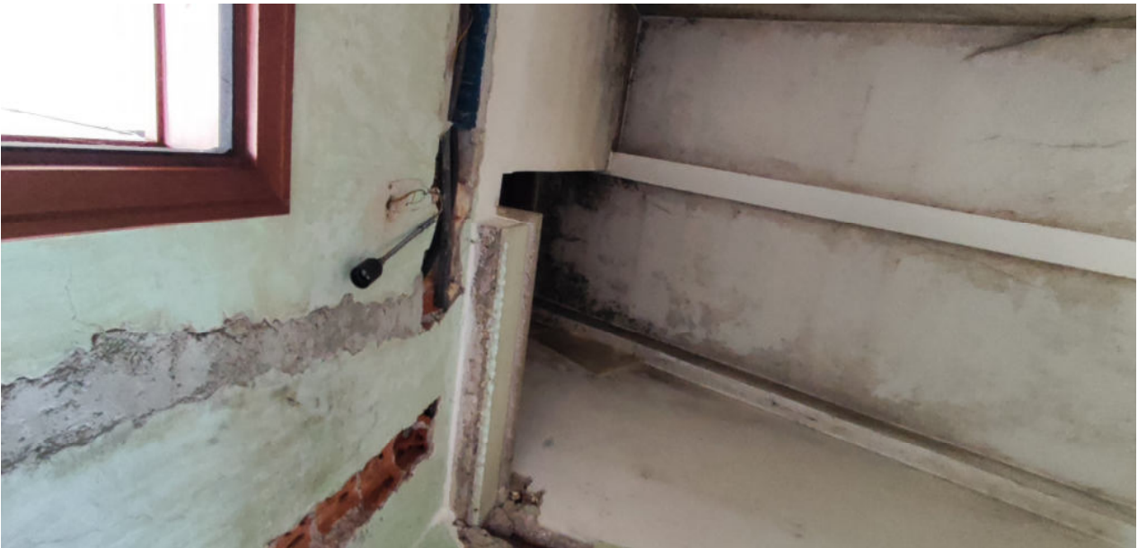
FOTO N.36 FOGLIO 5, MAPPALE 248, SUB.8 COMUNE DI CONCORDIA SAGITTARIA (VE)
