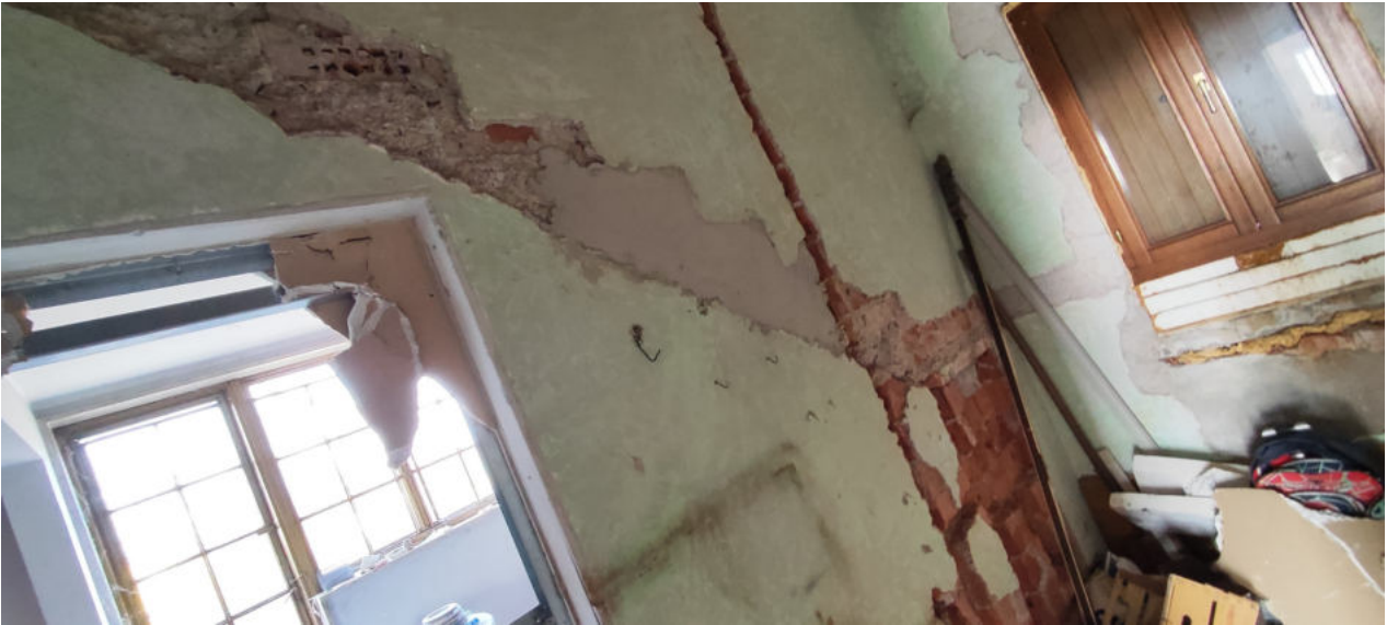
FOTO N.34 FOGLIO 5, MAPPALE 248, SUB.8 COMUNE DI CONCORDIA SAGITTARIA (VE)
