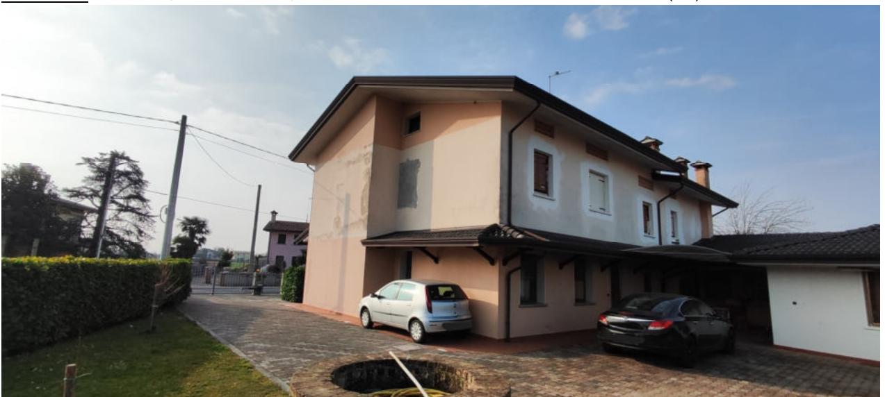
FOTO N.12 FOGLIO 5, MAPPALE 248, SUB.8 COMUNE DI CONCORDIA SAGITTARIA (VE)
