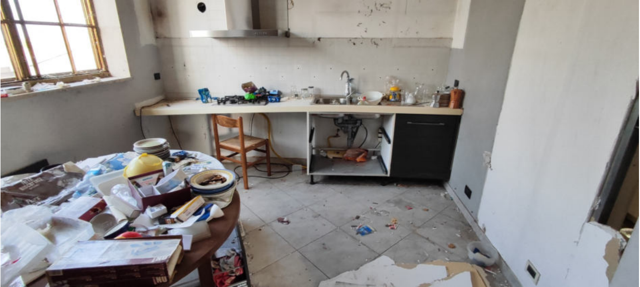
FOTO N.22 FOGLIO 5, MAPPALE 248, SUB.8 COMUNE DI CONCORDIA SAGITTARIA (VE)
