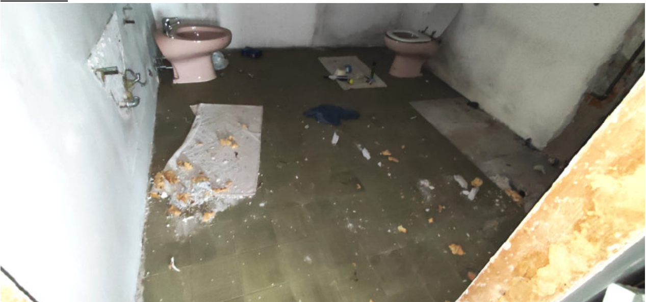
FOTO N.39 FOGLIO 5, MAPPALE 248, SUB.8 COMUNE DI CONCORDIA SAGITTARIA (VE)
