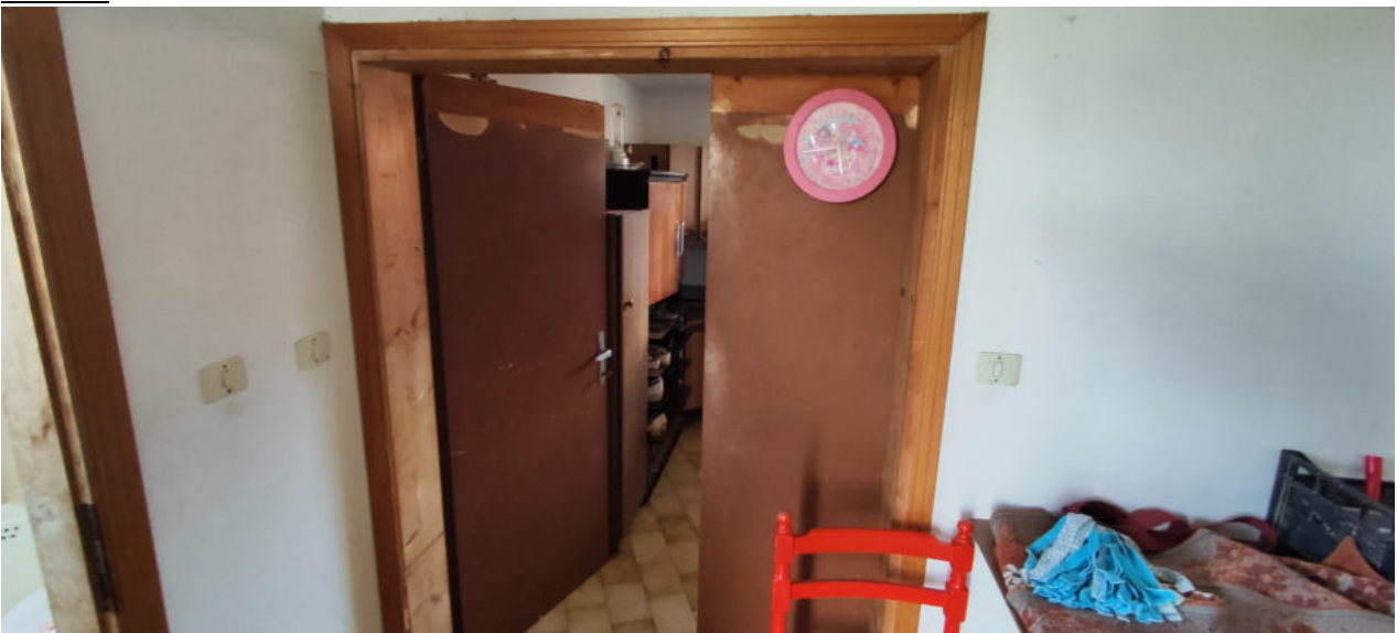
FOTO N.45 FOGLIO 5, MAPPALE 248, SUB.8 COMUNE DI CONCORDIA SAGITTARIA (VE)
