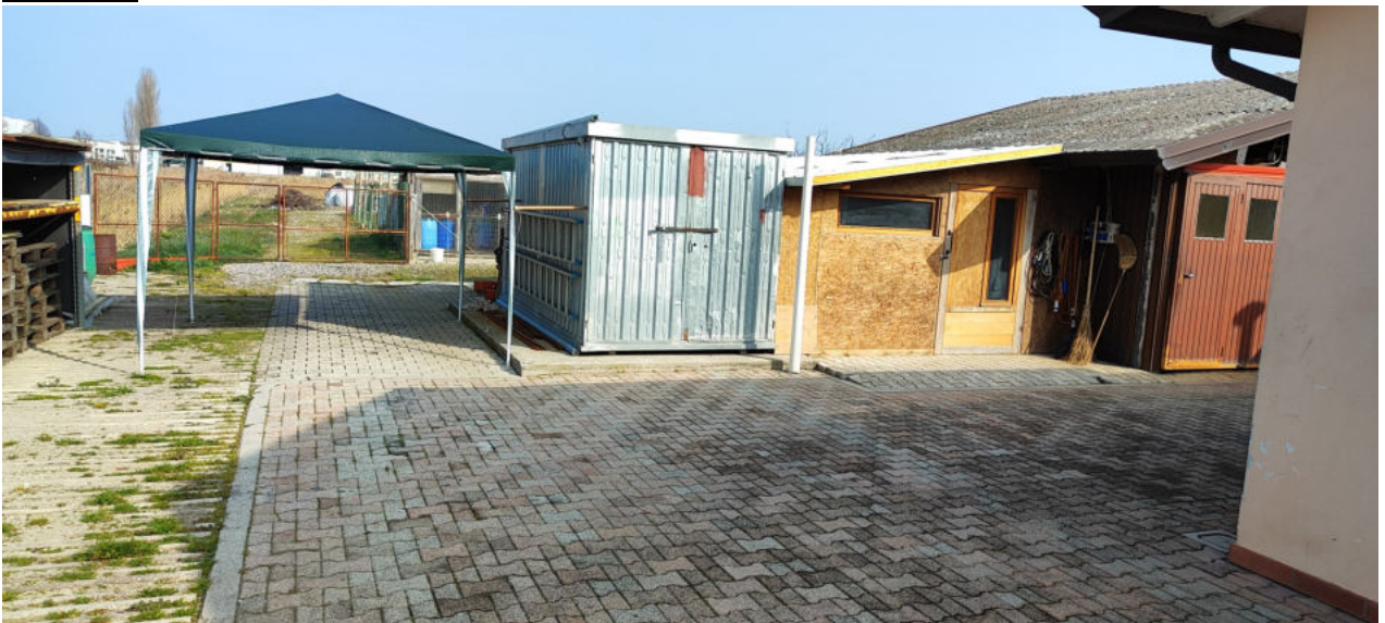
FOTO N.11 FOGLIO 5, MAPPALE 248, SUB.8 COMUNE DI CONCORDIA SAGITTARIA (VE)
