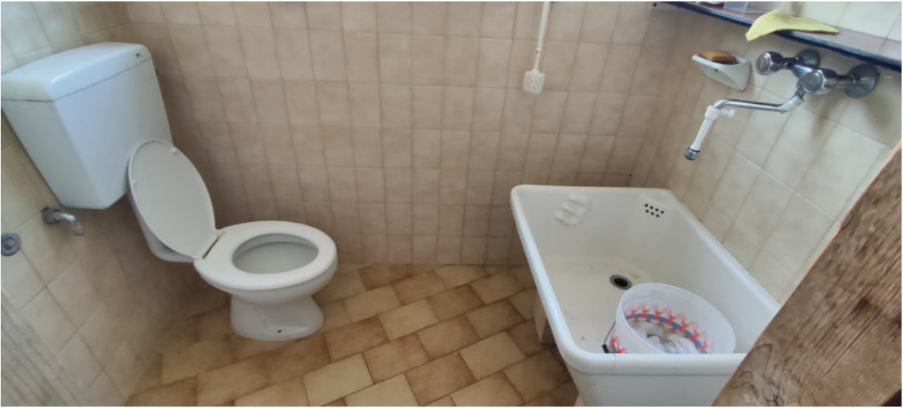
FOTO N.43 FOGLIO 5, MAPPALE 248, SUB.8 COMUNE DI CONCORDIA SAGITTARIA (VE)
