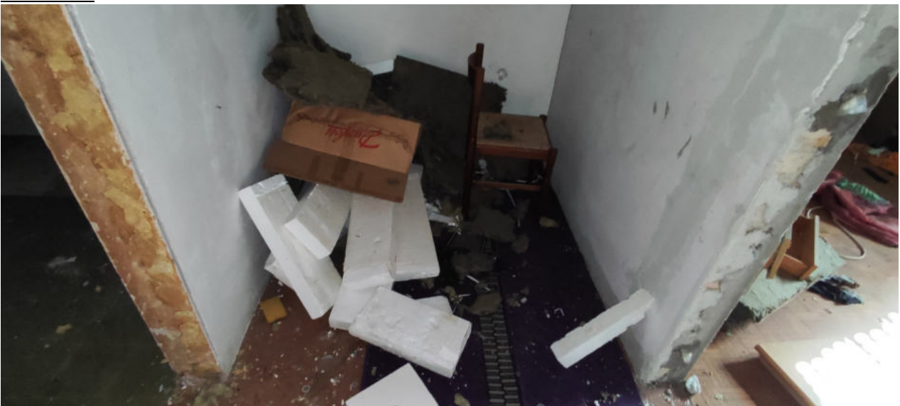
FOTO N.30 FOGLIO 5, MAPPALE 248, SUB.8 COMUNE DI CONCORDIA SAGITTARIA (VE)
