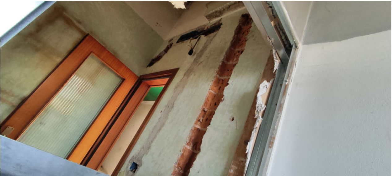
FOTO N.35 FOGLIO 5, MAPPALE 248, SUB.8 COMUNE DI CONCORDIA SAGITTARIA (VE)
