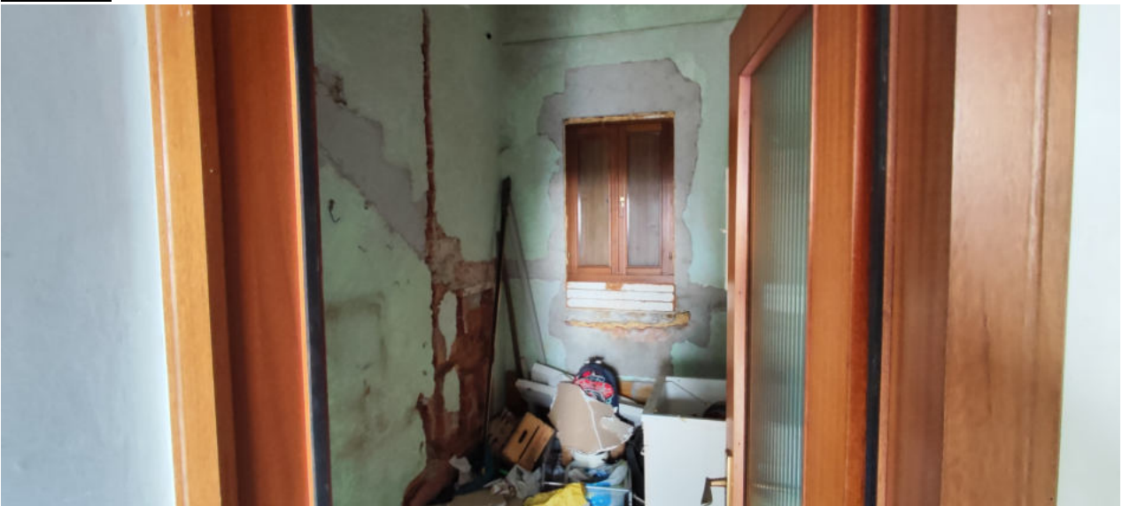
FOTO N.20 FOGLIO 5, MAPPALE 248, SUB.8 COMUNE DI CONCORDIA SAGITTARIA (VE)
