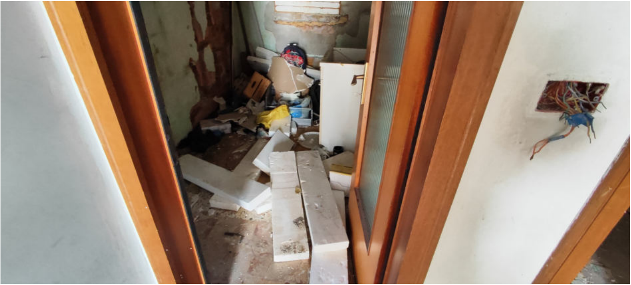
FOTO N.19 FOGLIO 5, MAPPALE 248, SUB.8 COMUNE DI CONCORDIA SAGITTARIA (VE)
