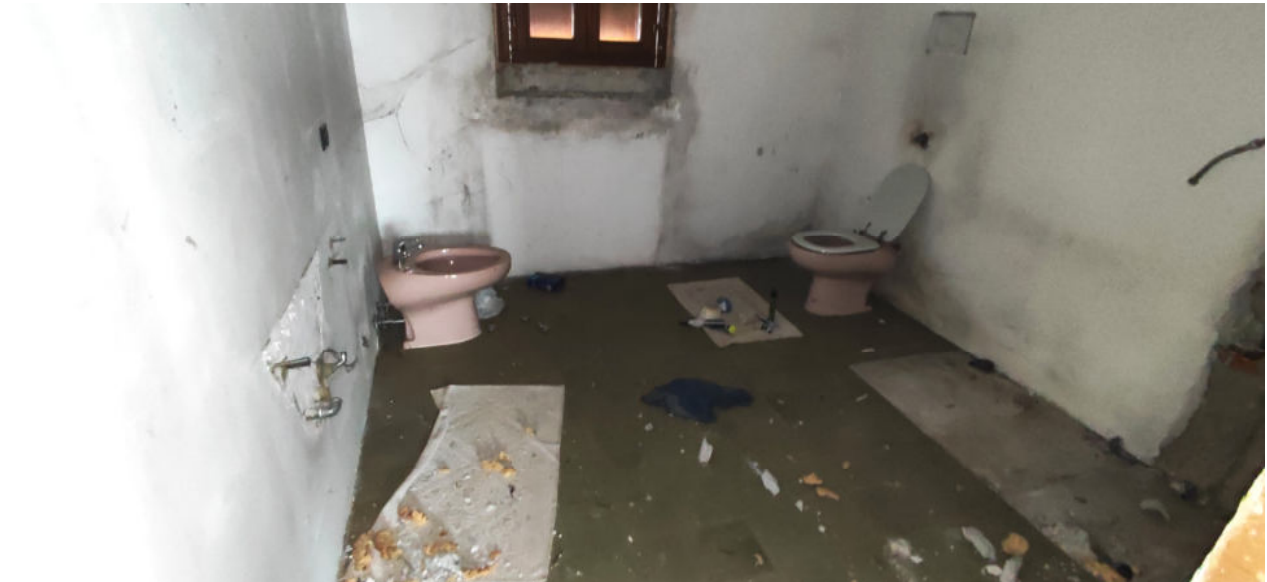
FOTO N.38 FOGLIO 5, MAPPALE 248, SUB.8 COMUNE DI CONCORDIA SAGITTARIA (VE)
