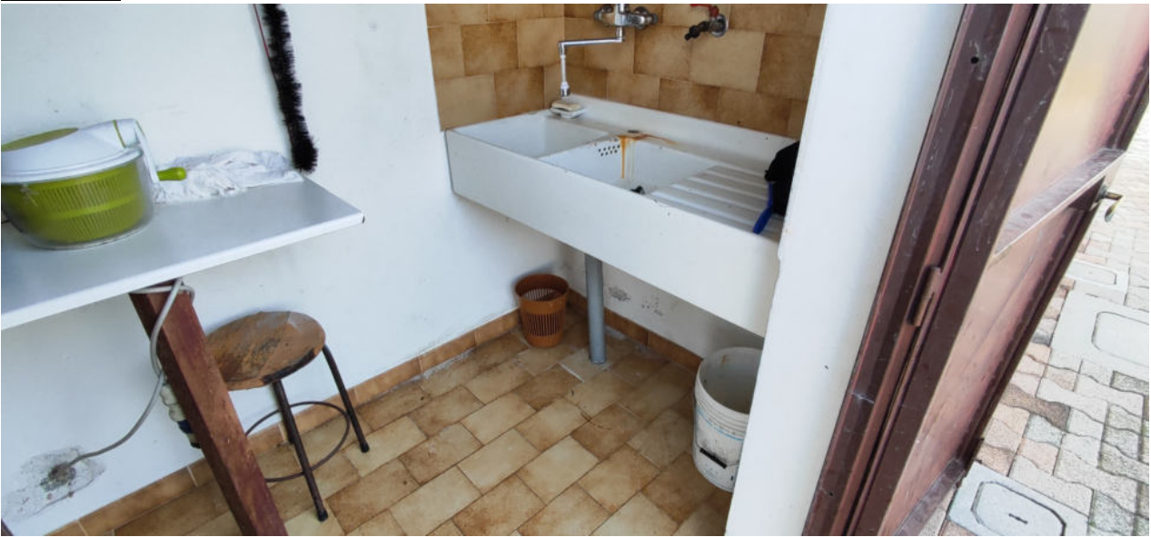
FOTO N.42 FOGLIO 5, MAPPALE 248, SUB.8 COMUNE DI CONCORDIA SAGITTARIA (VE)
