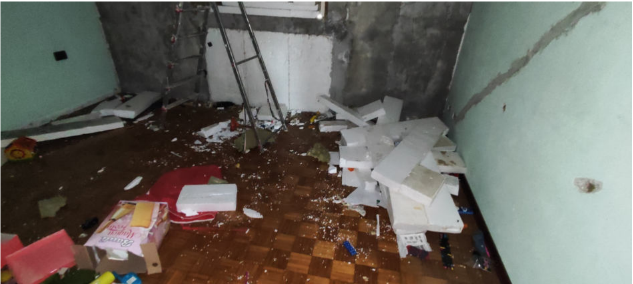
FOTO N.32 FOGLIO 5, MAPPALE 248, SUB.8 COMUNE DI CONCORDIA SAGITTARIA (VE)
