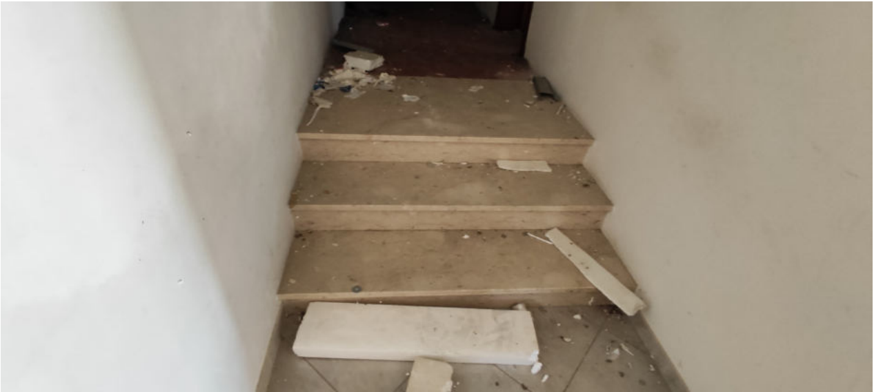
FOTO N.25 FOGLIO 5, MAPPALE 248, SUB.8 COMUNE DI CONCORDIA SAGITTARIA (VE)
