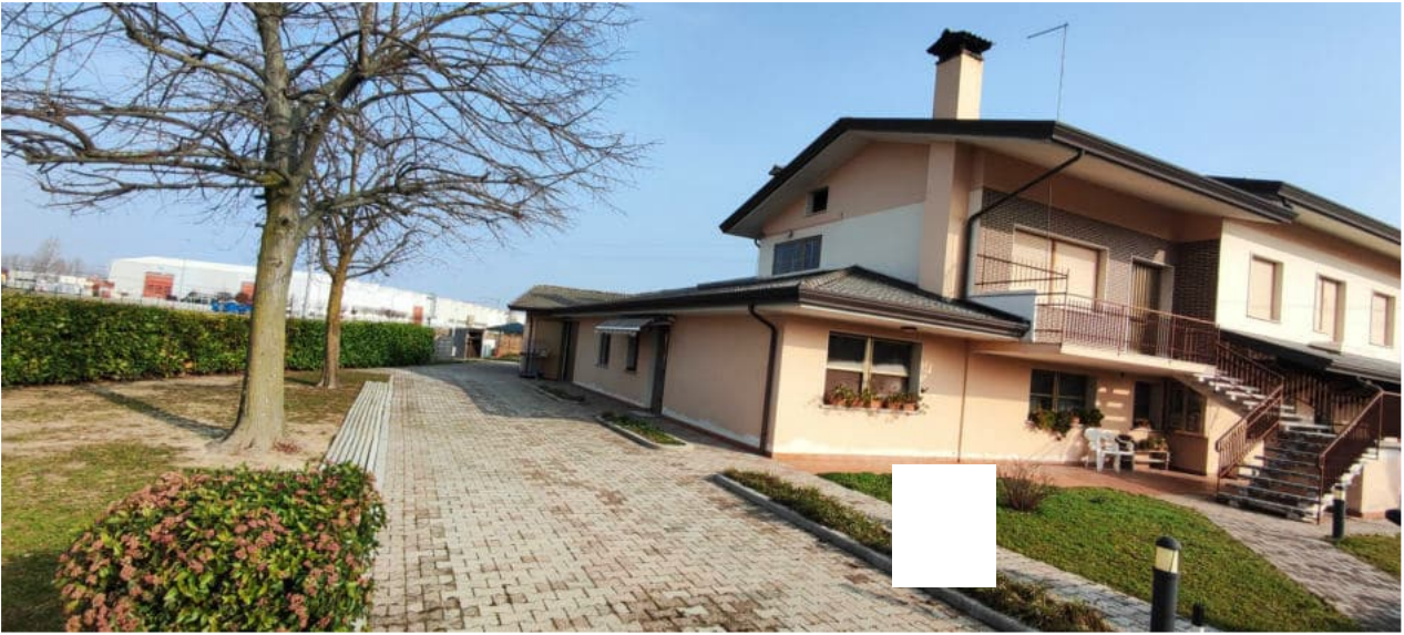
FOTO N.04 FOGLIO 5, MAPPALE 248, SUB.8 COMUNE DI CONCORDIA SAGITTARIA (VE)
