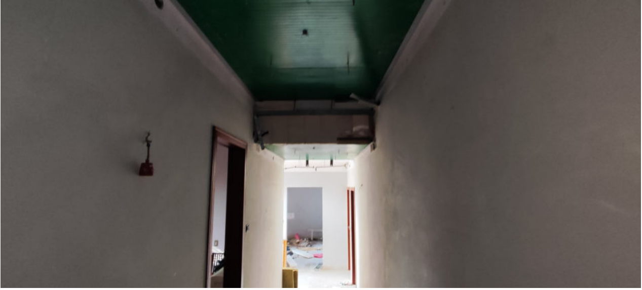
FOTO N.31 FOGLIO 5, MAPPALE 248, SUB.8 COMUNE DI CONCORDIA SAGITTARIA (VE)
