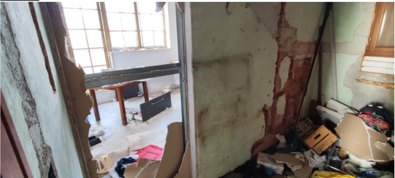
FOTO N.21 FOGLIO 5, MAPPALE 248, SUB.8 COMUNE DI CONCORDIA SAGITTARIA (VE)
