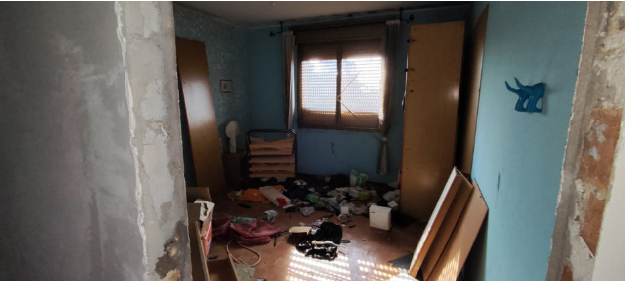
FOTO N.29 FOGLIO 5, MAPPALE 248, SUB.8 COMUNE DI CONCORDIA SAGITTARIA (VE)
