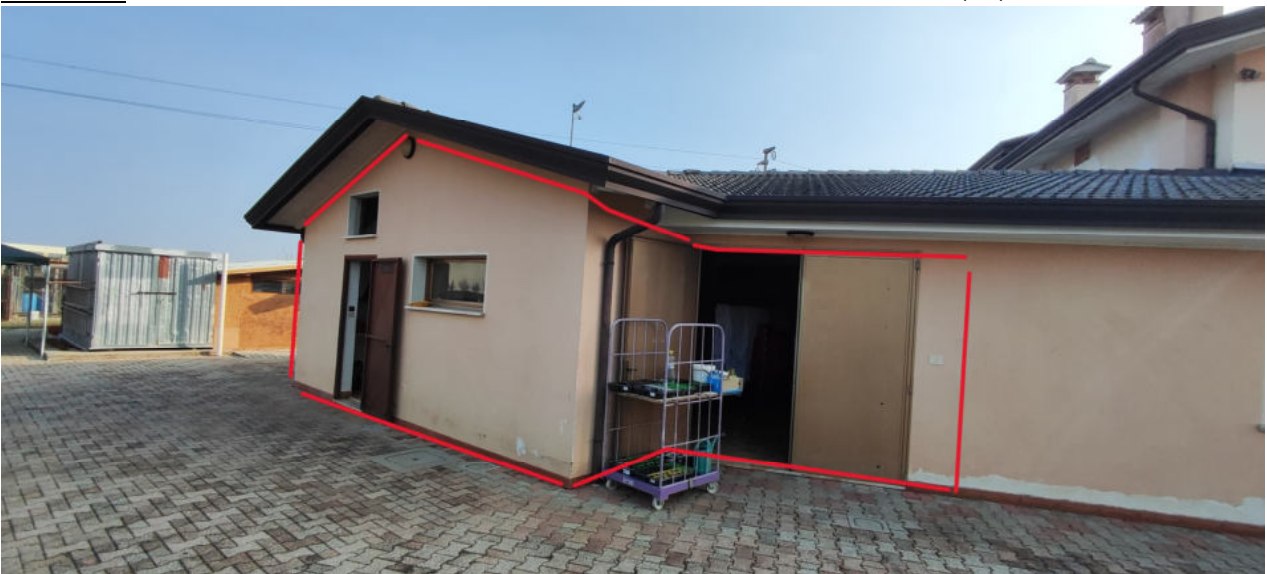
FOTO N.06 FOGLIO 5, MAPPALE 248, SUB.8 COMUNE DI CONCORDIA SAGITTARIA (VE)
