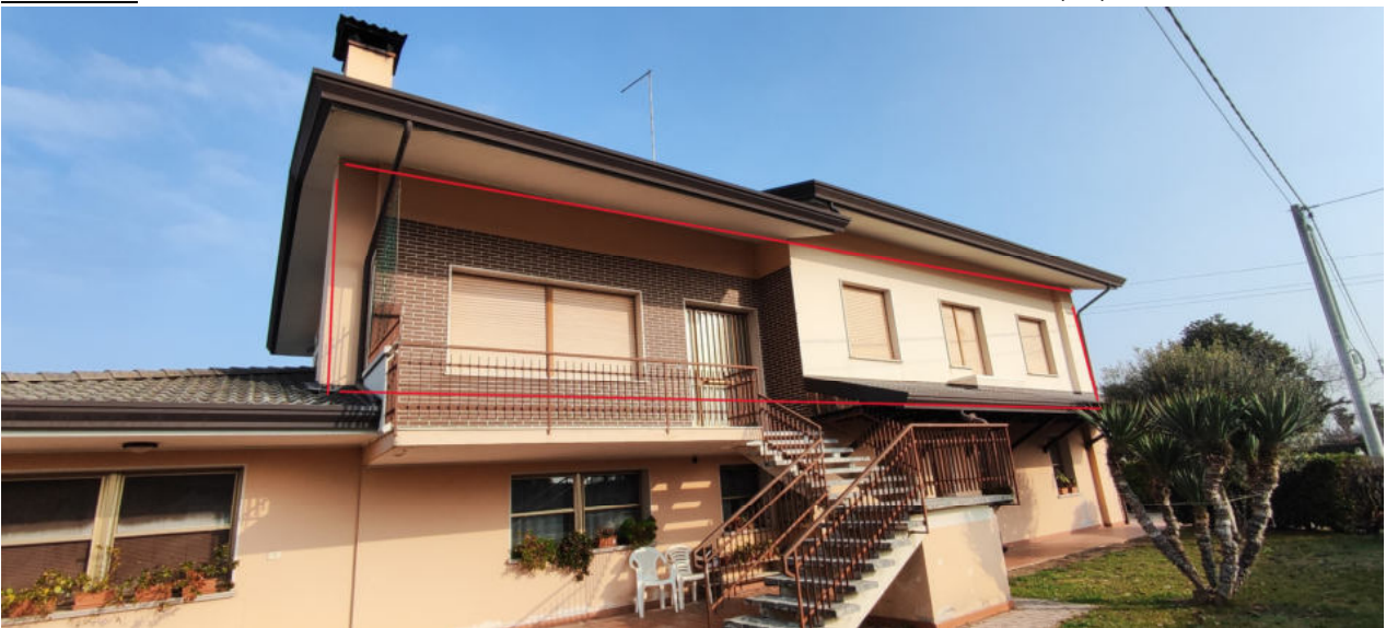
FOTO N.03 FOGLIO 5, MAPPALE 248, SUB.8 COMUNE DI CONCORDIA SAGITTARIA (VE)
