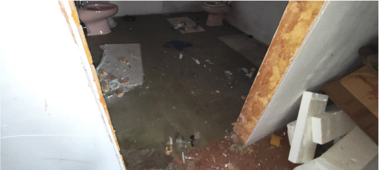
FOTO N.37 FOGLIO 5, MAPPALE 248, SUB.8 COMUNE DI CONCORDIA SAGITTARIA (VE)
