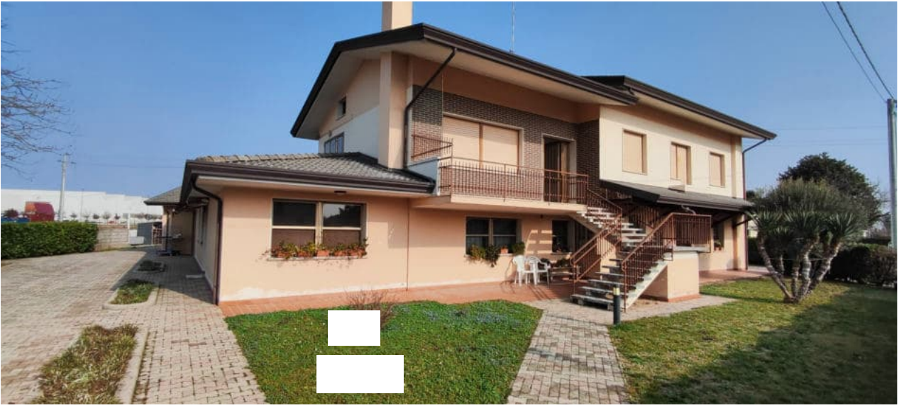
FOTO N.01 FOGLIO 5, MAPPALE 248, SUB.8 COMUNE DI CONCORDIA SAGITTARIA (VE)
