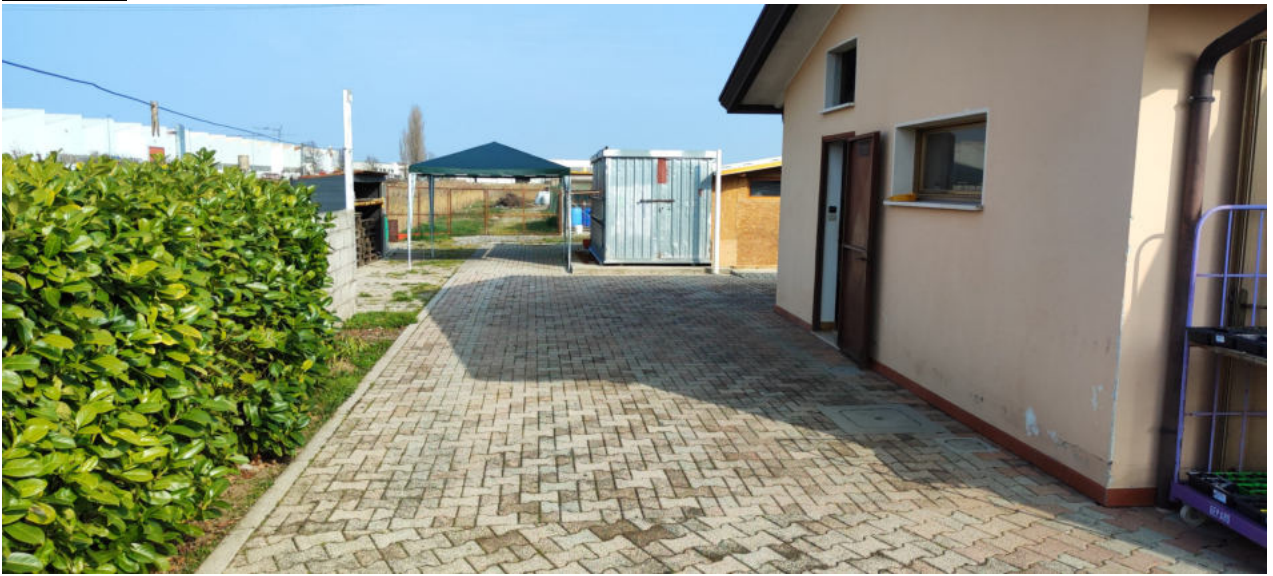
FOTO N.10 FOGLIO 5, MAPPALE 248, SUB.8 COMUNE DI CONCORDIA SAGITTARIA (VE)
