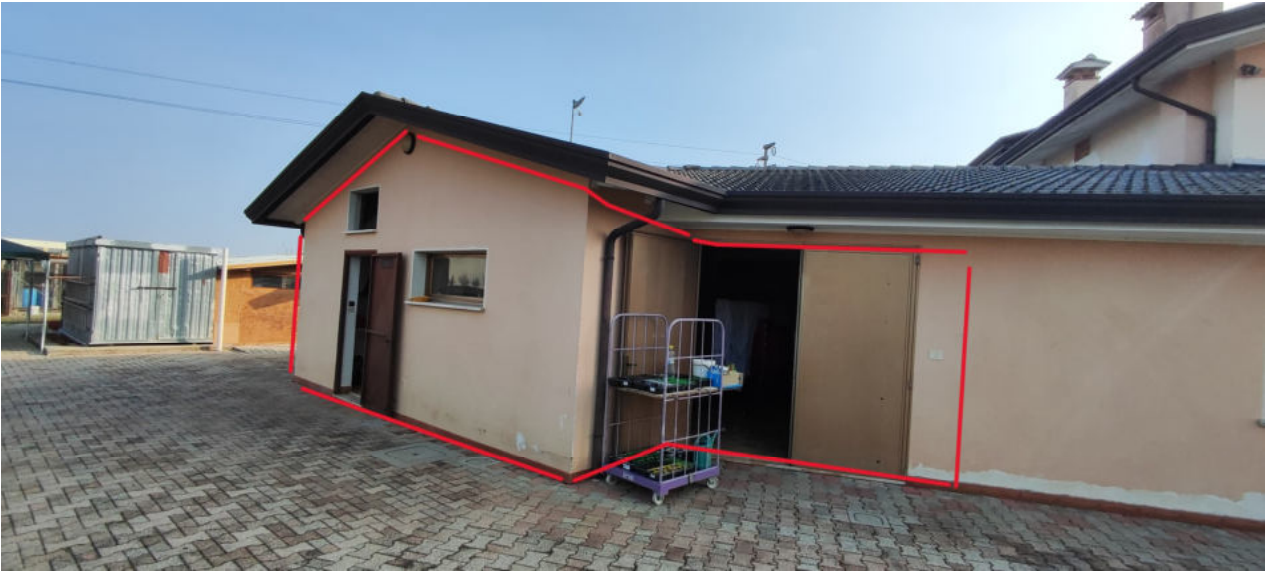
FOTO N.40 FOGLIO 5, MAPPALE 248, SUB.8 COMUNE DI CONCORDIA SAGITTARIA (VE)
