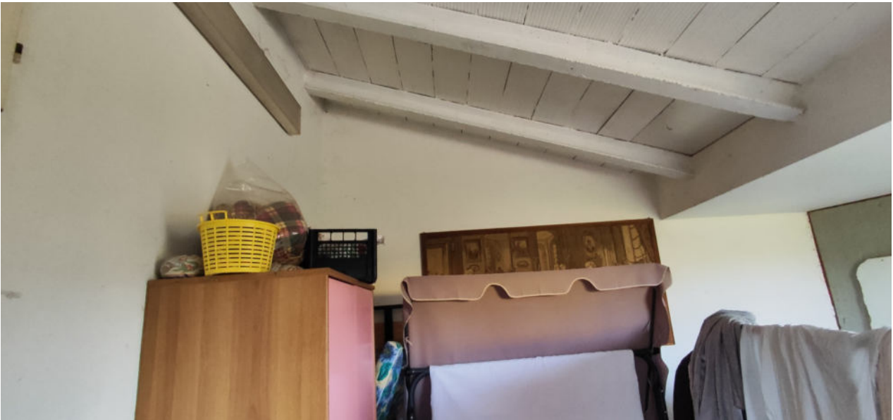
FOTO N.47 FOGLIO 5, MAPPALE 248, SUB.6 COMUNE DI CONCORDIA SAGITTARIA (VE)
