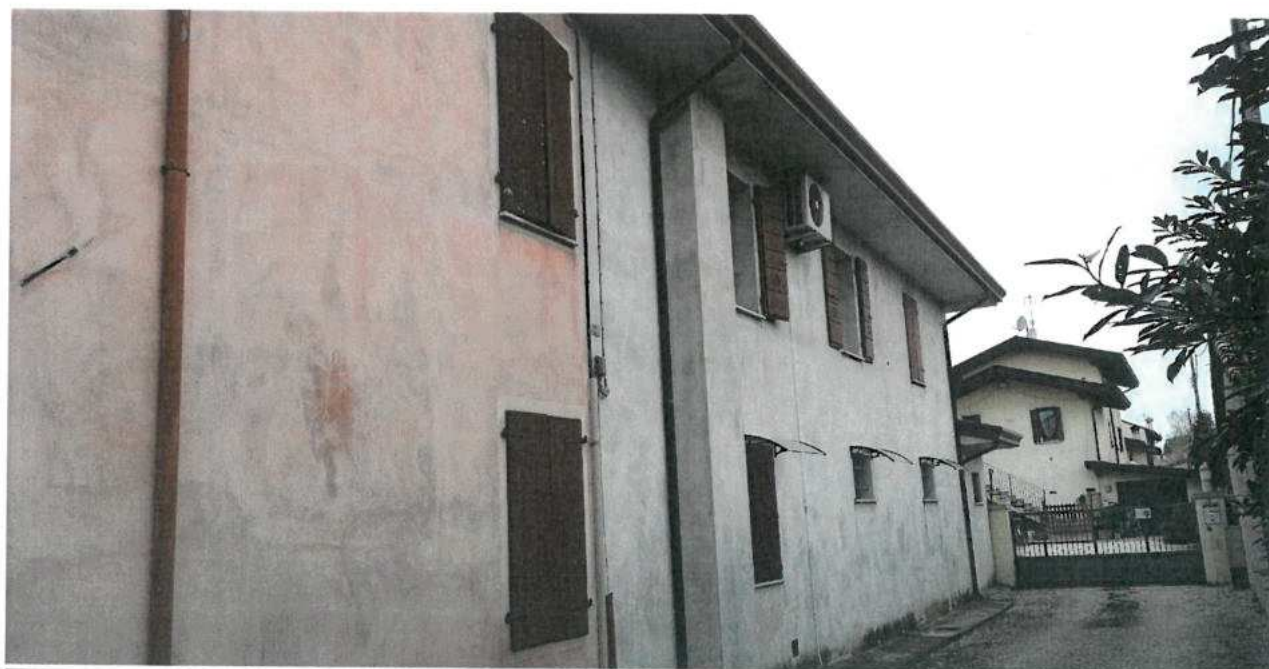
FOTO N.04 FOGLIO 29, MAPPALE 308 SUB.2 COMUNE DI VALVASONE ARZENE (PN)
