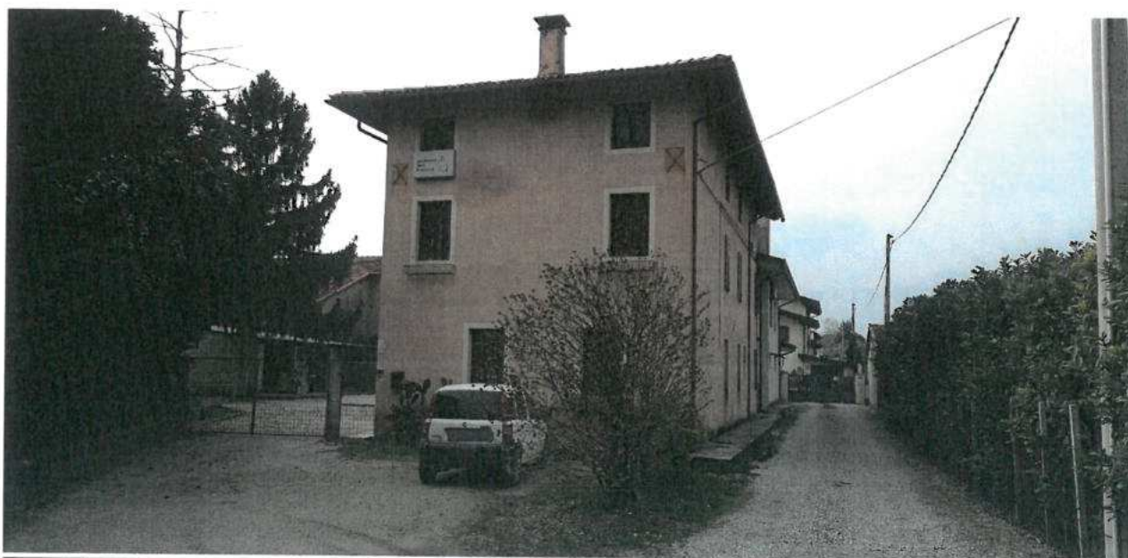
FOTO N.02 FOGLIO 29, MAPPALE 308 SUB.2 COMUNE DI VALVASONE ARZENE (PN)
