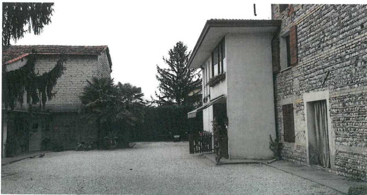
FOTO N.06 FOGLIO 29, MAPPALE 308 SUB.2 COMUNE DI VALVASONE ARZENE (PN)
