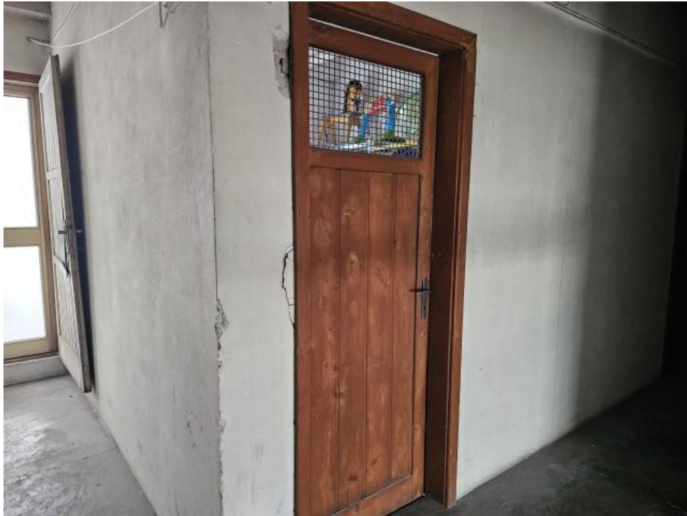
FOTO 21: SOFFITTA (SUB. 32 – 7°P.)
