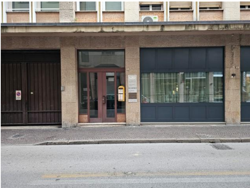
FOTO 4: ACCESSO VANO SCALE CONDOMINIALE SU VIALE COSSETTI
