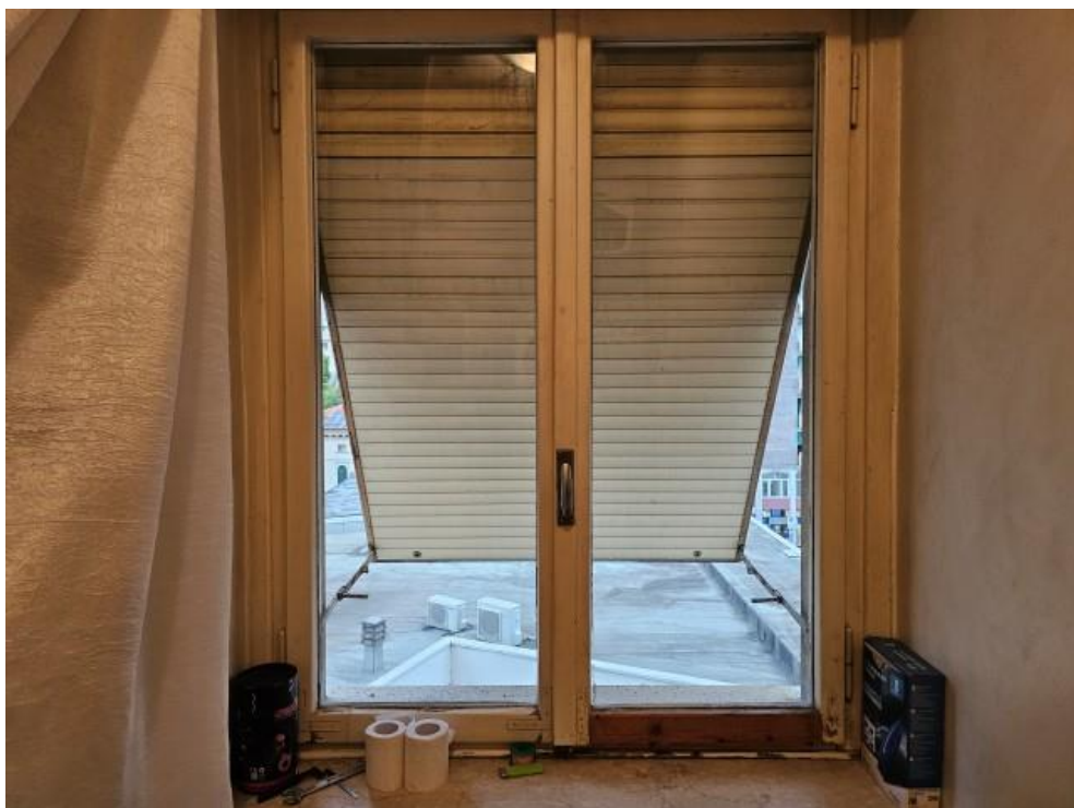
FOTO 18: SERRAMENTO (SUB. 32 – 4°P.)
