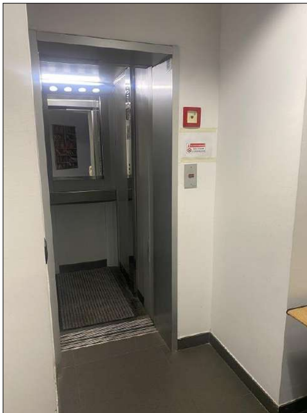
SBARCO ASCENSORE – VISTA FOTOGRAFICA 6)
