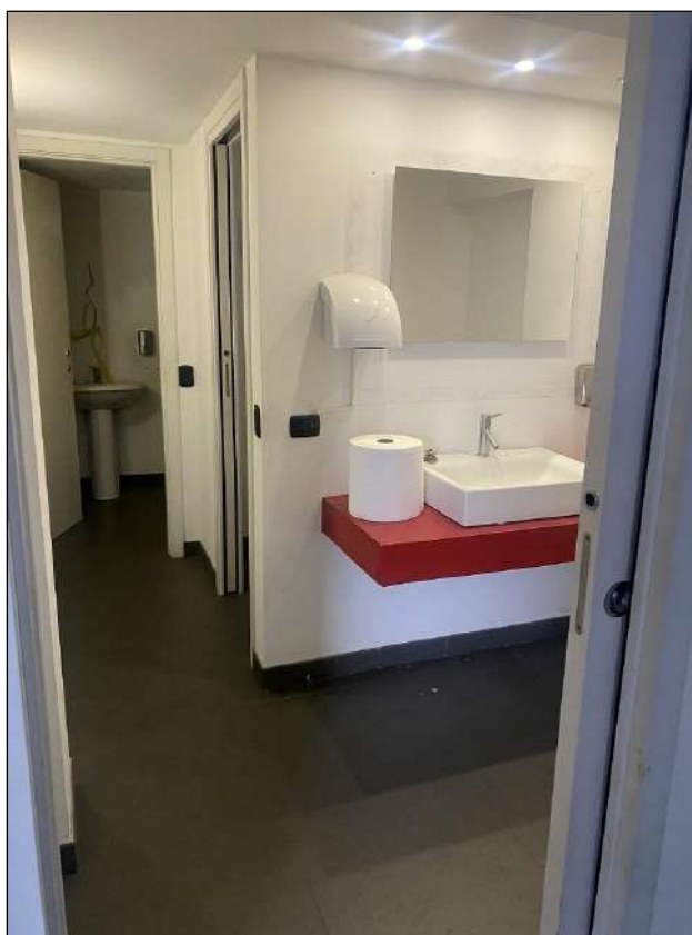
SERVIZI IGIENICI – VISTA FOTOGRAFICA 14)
