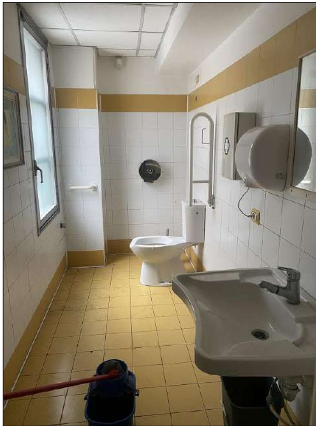
SERVIZIO IGIENICO – VISTA FOTOGRAFICA 18)
