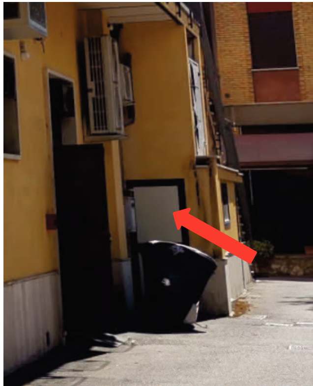
Porta di accesso al bagno esterno
