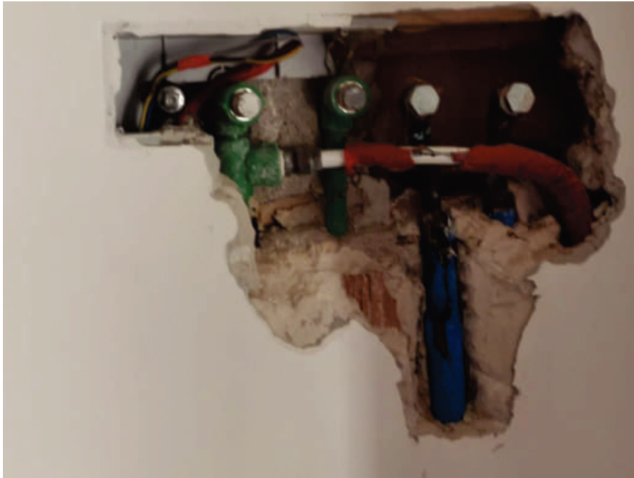
Predisposizione caldaia
