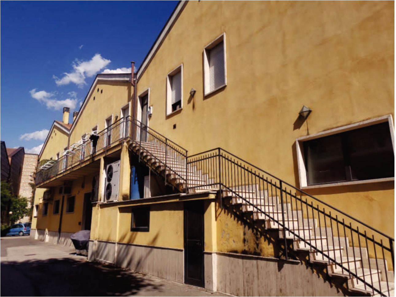
Scala di accesso comune (Sub.12)
