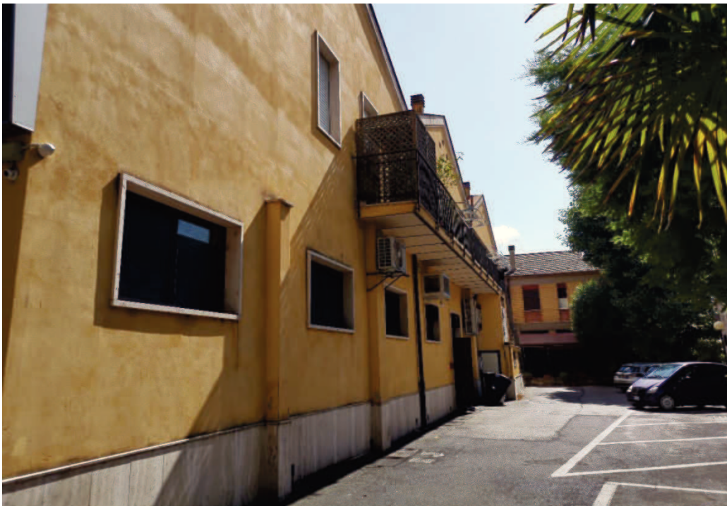
Zona sul retro (Sub.11)
