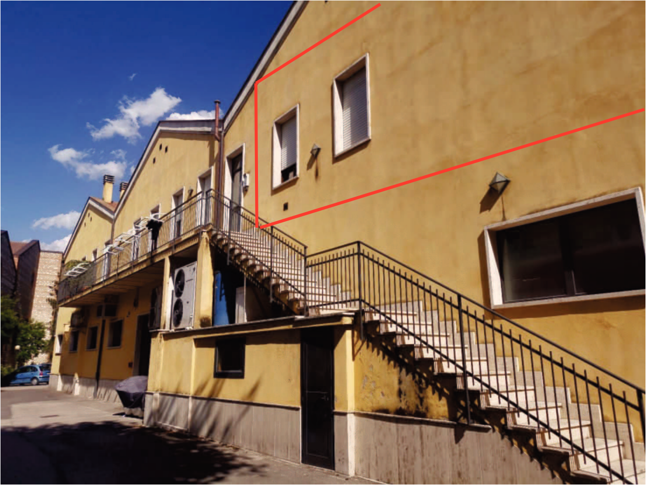
Esterno Appartamento Sub.6 e scala di accesso comune (Sub.12)
