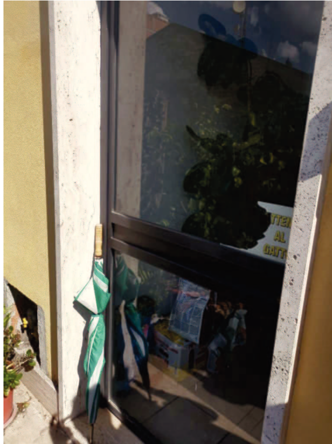
Porta vetrata di accesso al disimpegno comune ai sub.9-10 (Esso stesso sub.14)
