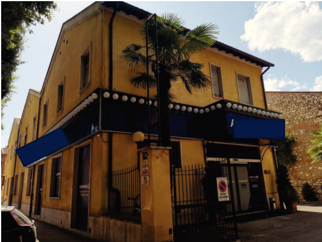
Zona di accesso comune (Sub.11)
