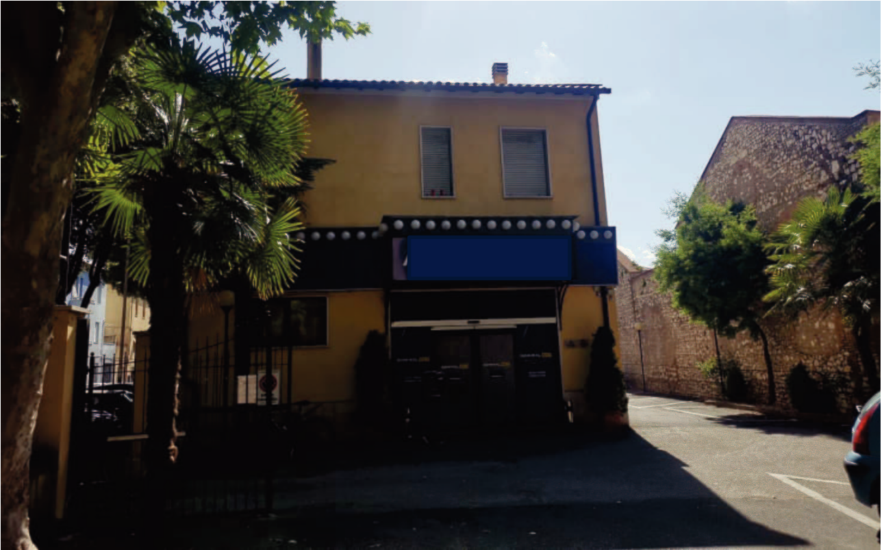
Zona ingresso al locale
