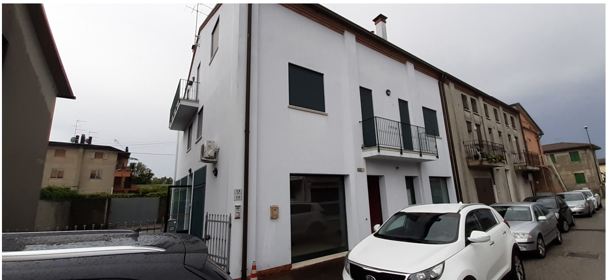
Vista del fabbricato da Via Chiara Rovelli
