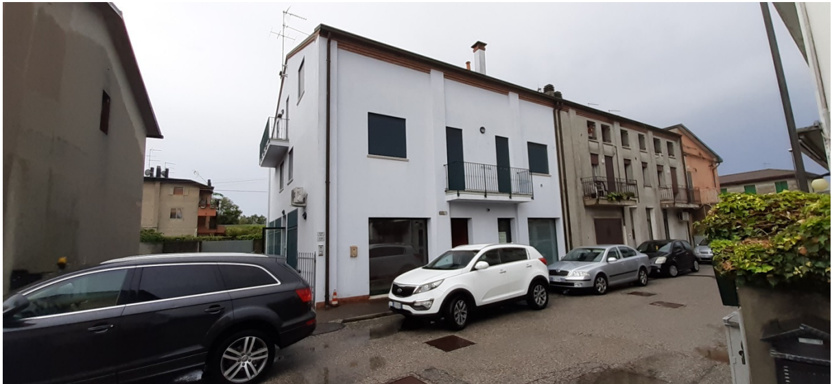
Vista del fabbricato da Via Chiara Rovelli
