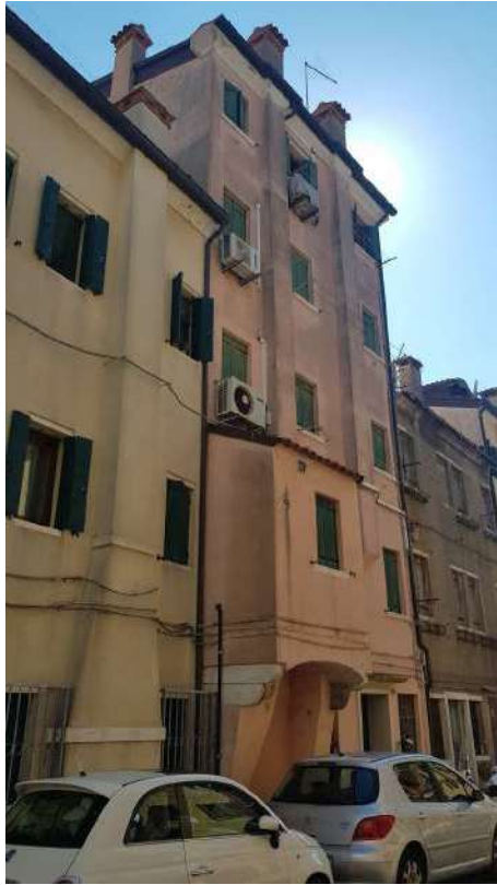
foto n. 1 – vista prospetto da calle Boegani
