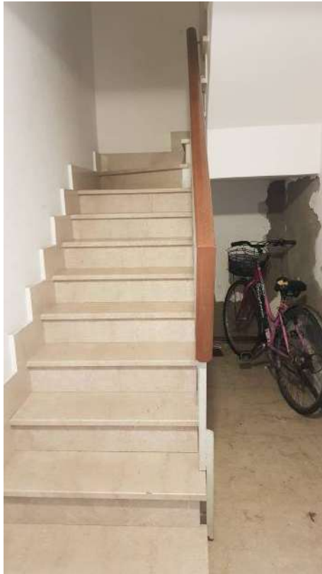
foto n. 5 – vista ingresso abitazione
