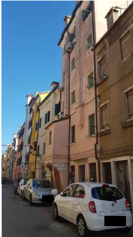
foto n. 3 – vista prospetto da calle Boegani
