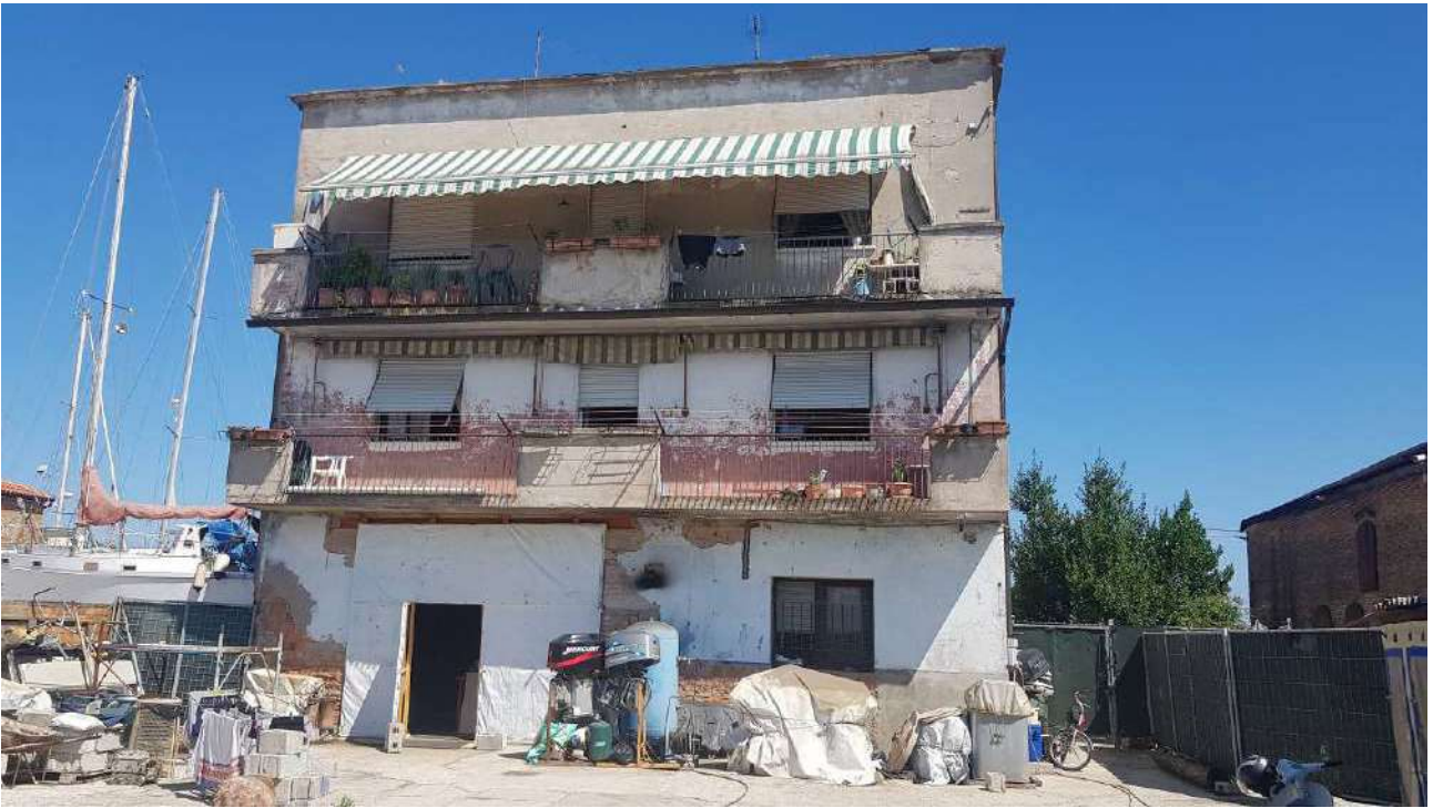
foto n. 1 – vista fronte ovest
