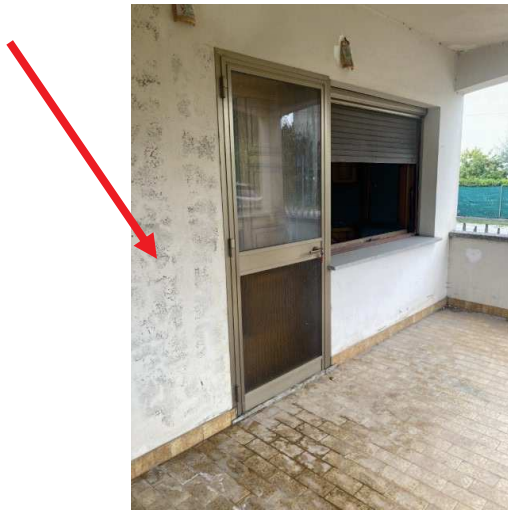
particolare prospetti esterni con degrado delle pitture
