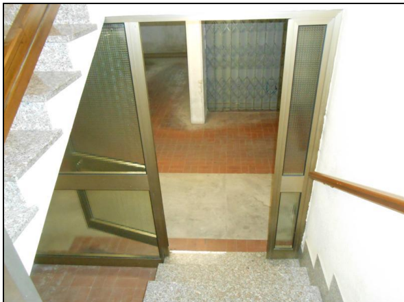
Accesso al piano seminterrato
