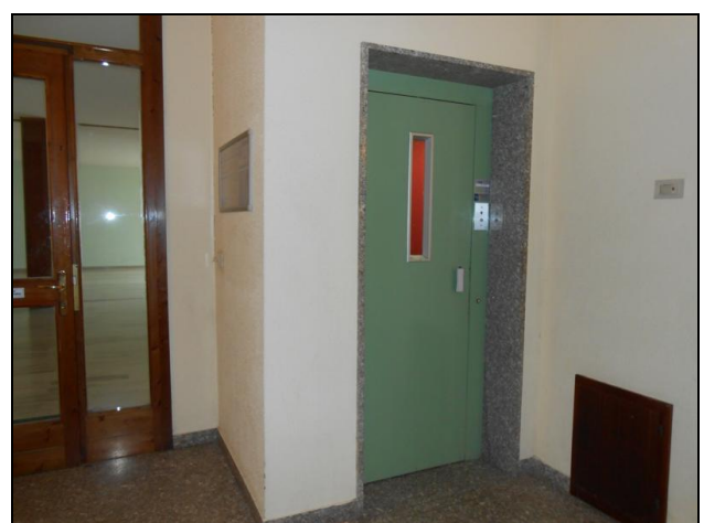
Ascensore vano scala B
