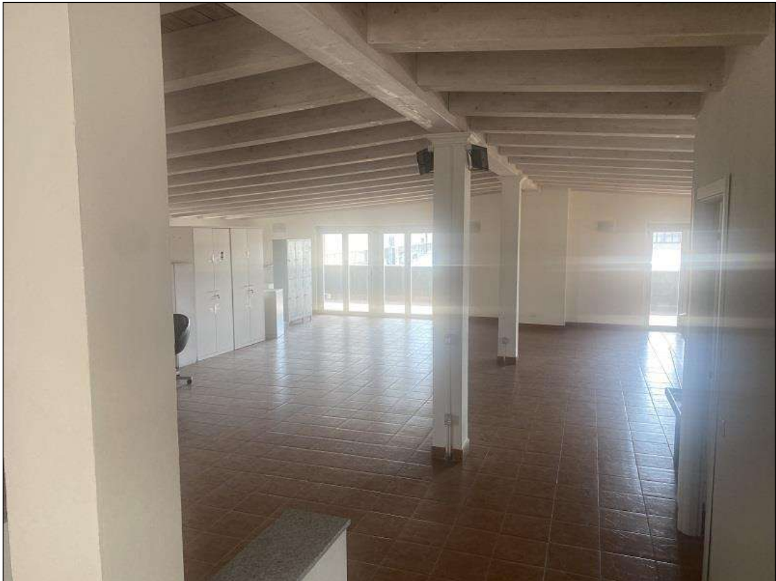
DEPOSITO - VISTA FOTOGRAFICA 58)
