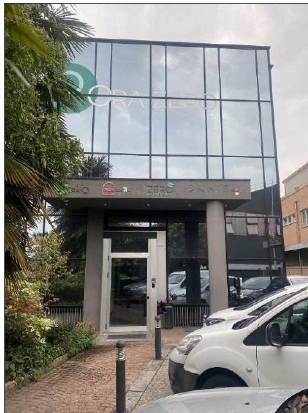
PROSPETTO SUD EST SU AREA CORTILIZIA MAPP. 32 – VISTA FOTOGRAFICA 2)
