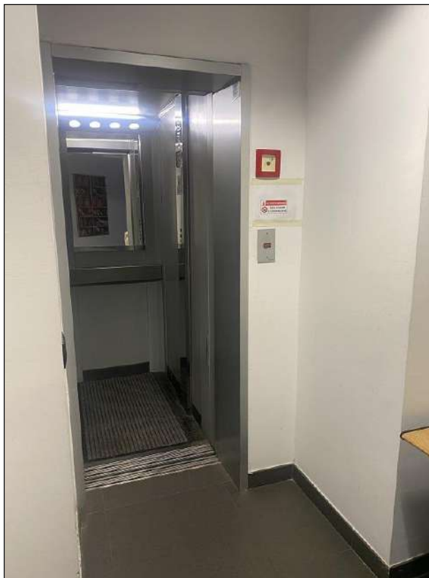
SBARCO ASCENSORE – VISTA FOTOGRAFICA 6)
