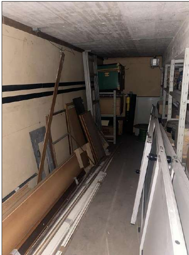
INTERNO SOPPALCO – VISTA FOTOGRAFICA 12)
