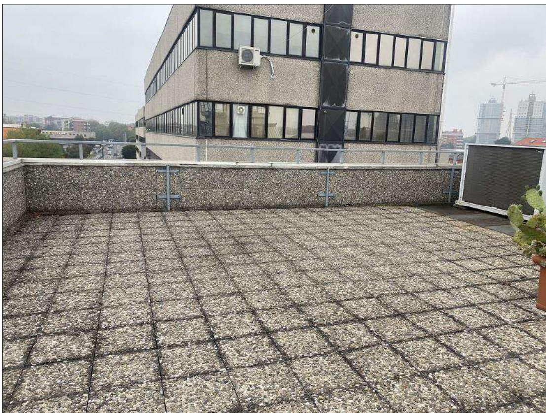
LASTRICO SOLARE – VISTA FOTOGRAFICA 45)
