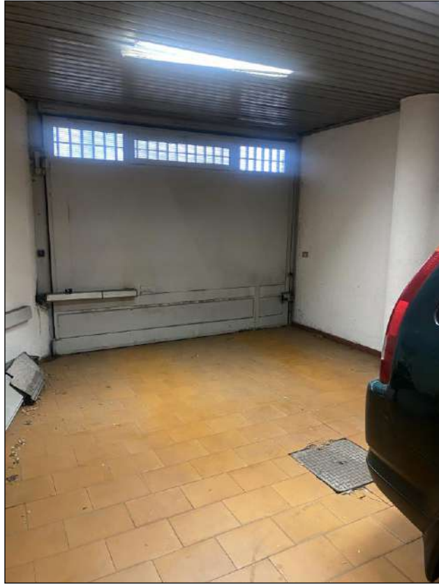
INTERNO NEGOZIO – VISTA FOTOGRAFICA 28)
