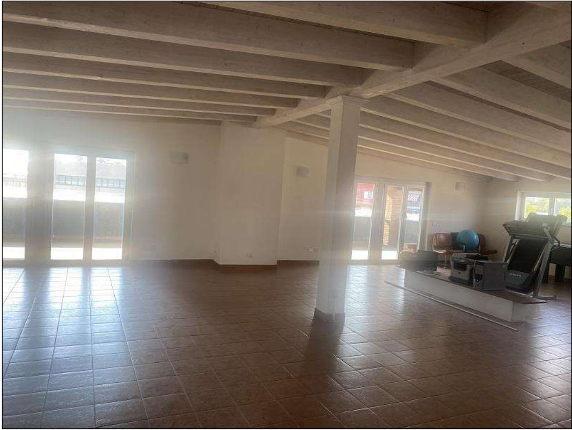
DEPOSITO - VISTA FOTOGRAFICA 59)
