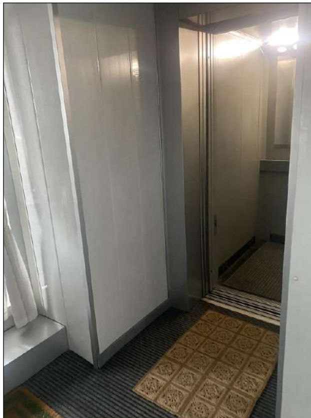
SBARCO ASCENSORE – VISTA FOTOGRAFICA 34)
