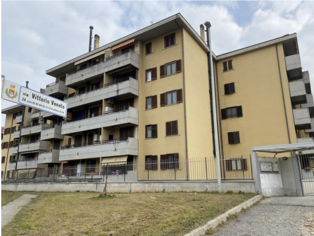
FOTO 1: CORNAREDO, VIA VITTORIO VENETO n. 24, ingresso complesso "Il Borgo"
