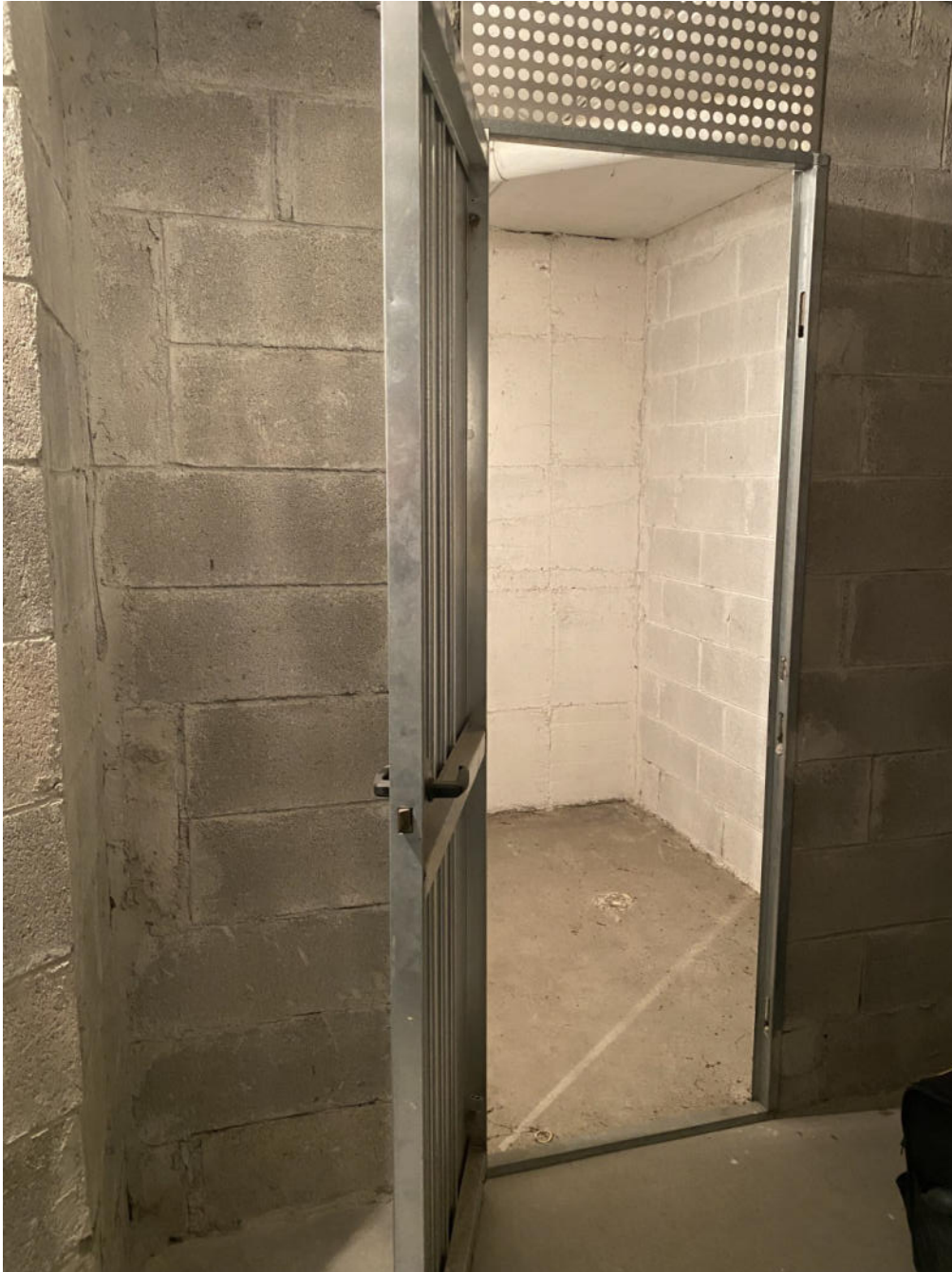
FOTO 12: CORNAREDO, VIA VITTORIO VENETO n. 24, Cantina
