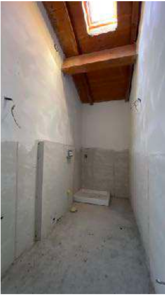
Villino unifamiliare sub 298 _ Bagno
