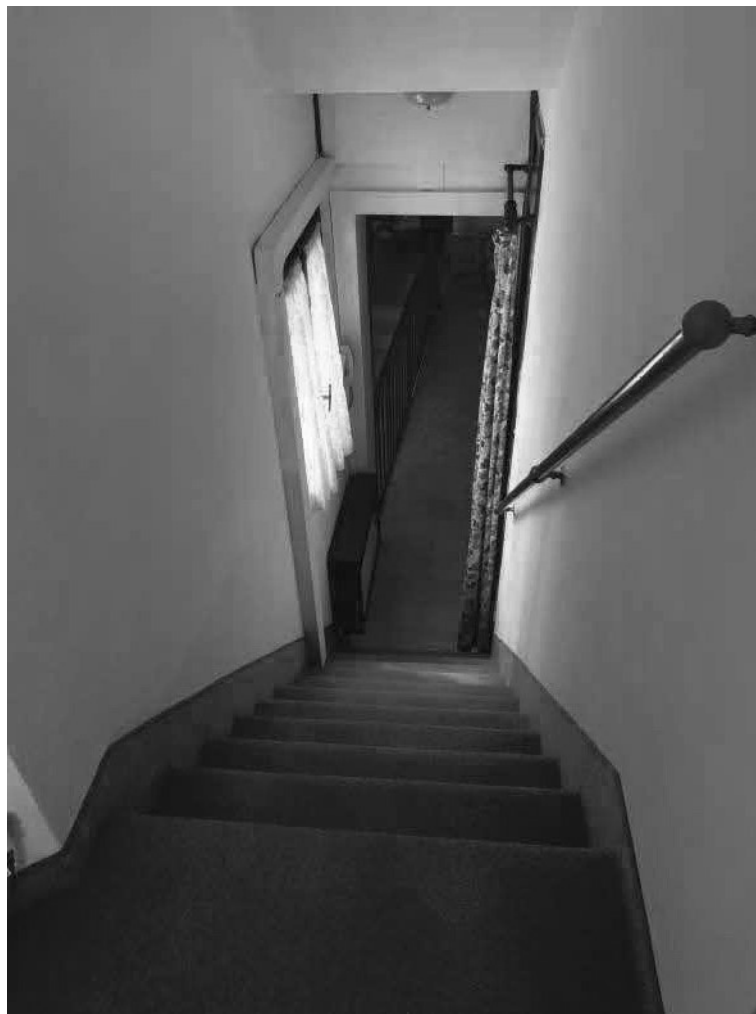
Foto 42: Lotto 2- Scala interna.
