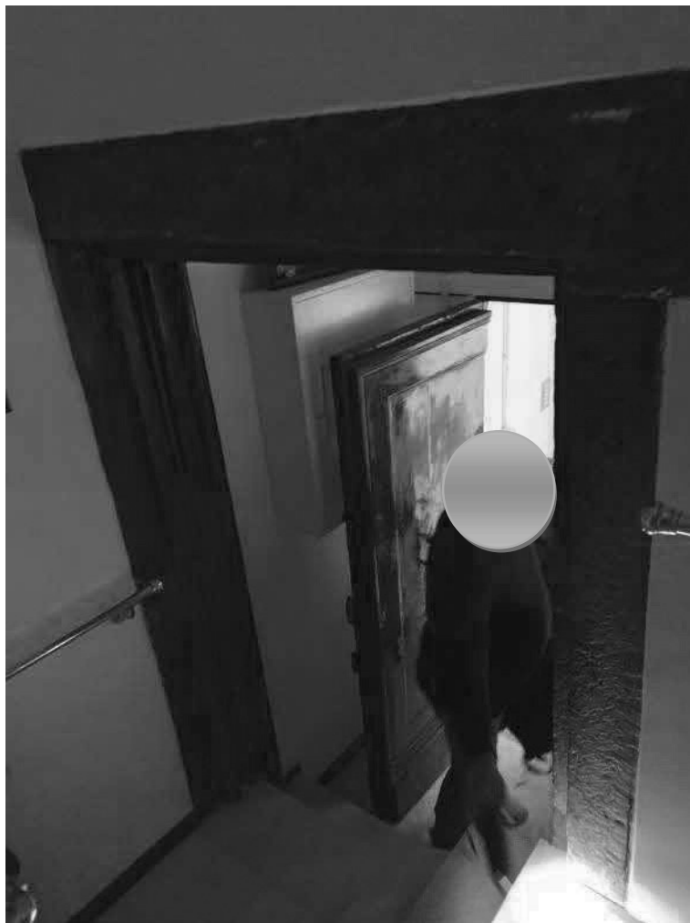
Foto 12: Lotto 1/2 – Ingresso al Lotto 1 e Lotto2
