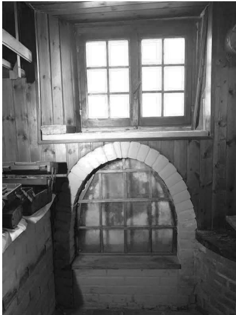
Foto 36: Lotto 1 – Magazzino al piano terra.
