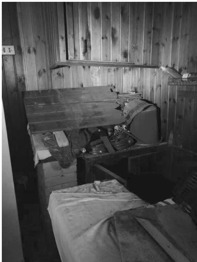
Foto 33: Lotto 1 – Magazzino al piano terra. Lavello.
