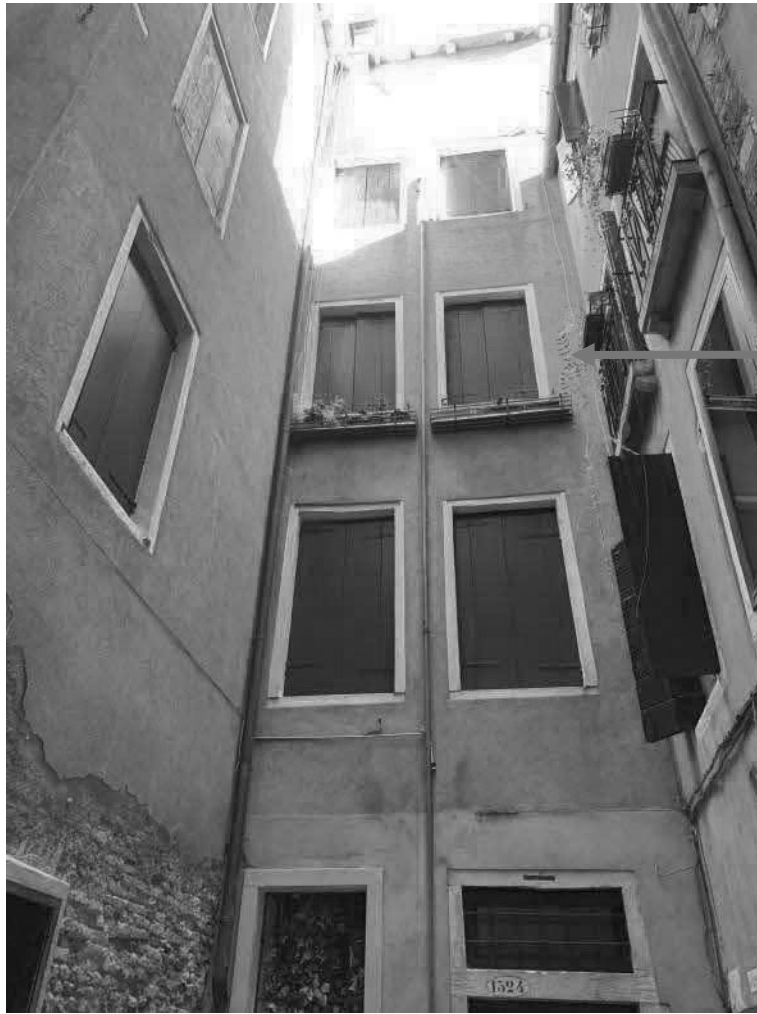
Foto 3: Prospetto Nord sulla Corte Rizzo (finestre Lotto 1)
