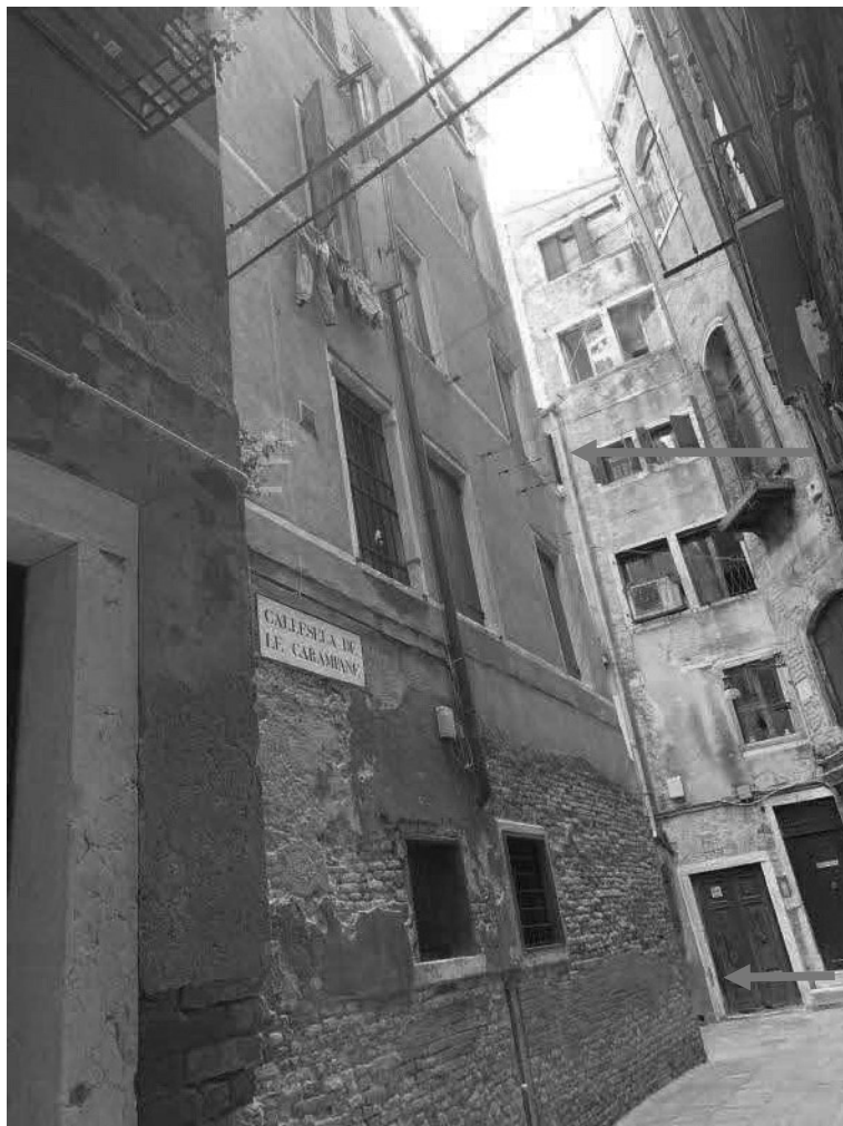
Foto 1: Sestiere San Polo – Callesele Carampane (finestre Lotto 1)
