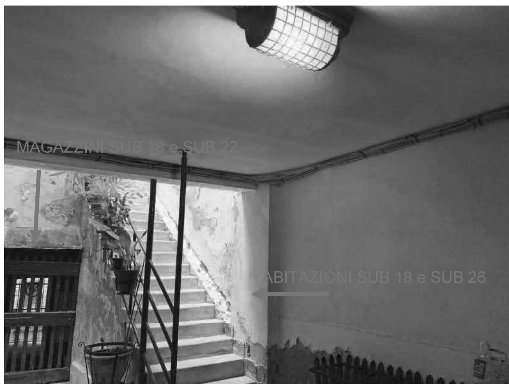
Foto 7: Sottoportico Comune al piano terra. Scala d'accesso agli appartamenti e porta accesso ai magazzini al piano terra.
