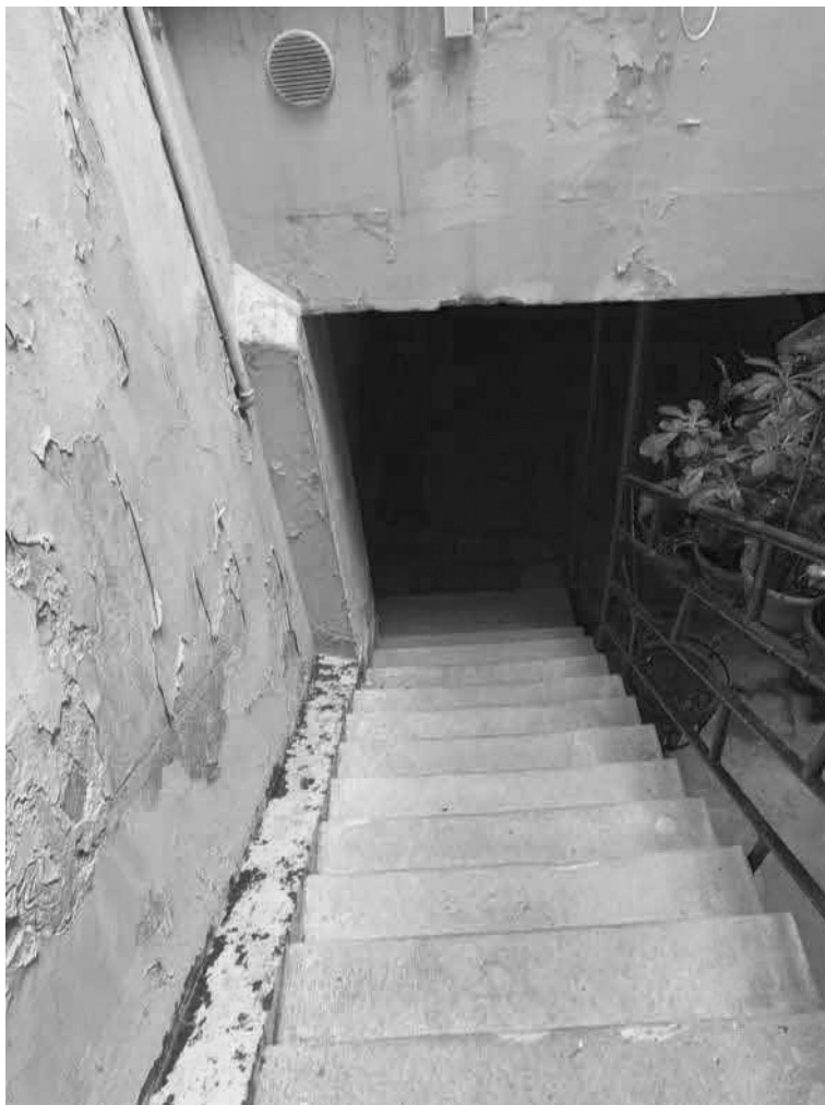
Foto 10: Sottoportico Comune al piano terra. Scala esterna.
