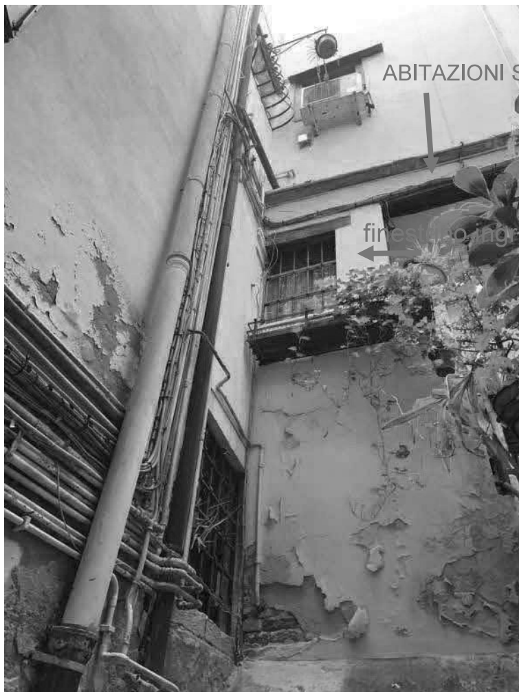
Foto 9: Sottoportico Comune al piano terra. Passaggio impianti. Pianerottolo al piano primo.
