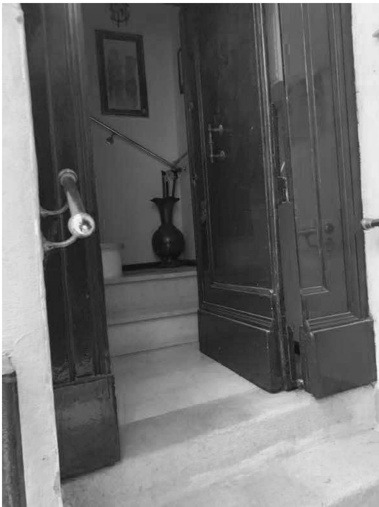
Foto 11: Lotto 1/2 – Portoncino d'ingresso
