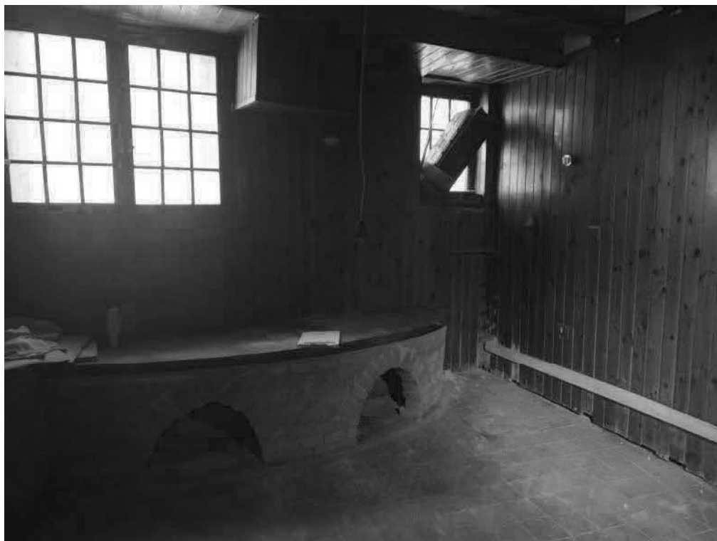
Foto 35: Lotto 1 – Magazzino al piano terra. Panca in muratura.
