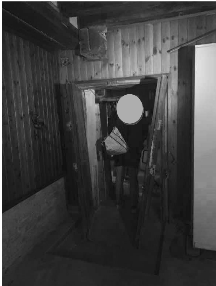
Foto 32: Lotto 1 – Magazzino al piano terra.
