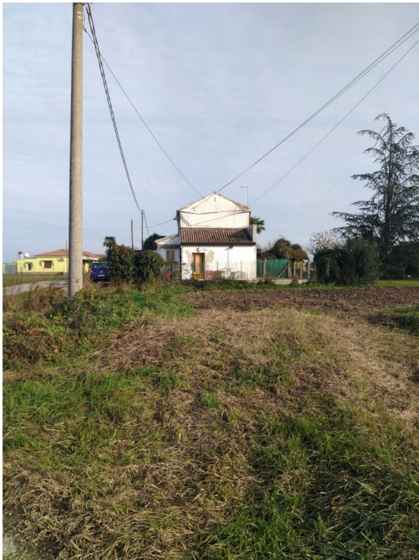
Foto 3 Vista dell'edificio oggetto di stima.
