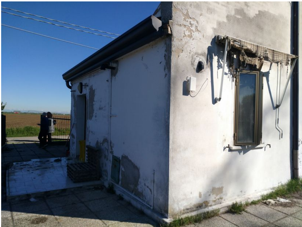
Foto 7 Vista dell'edificio oggetto di stima.
