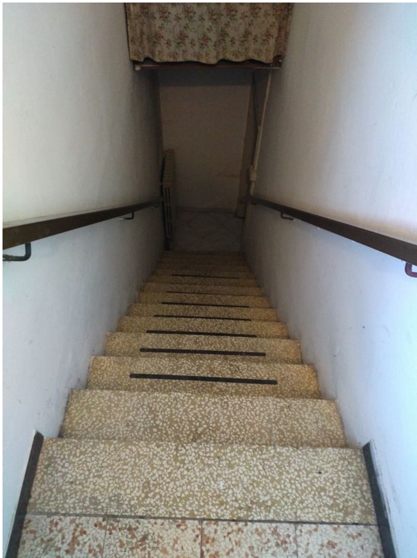
Foto 10 Scala di collegamento interna.
