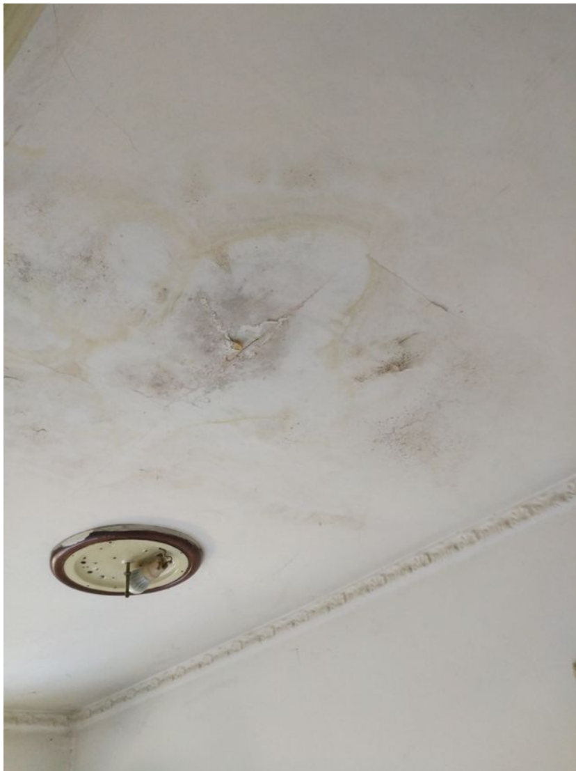
Foto 21 Particolare del soffitto al piano primo.
