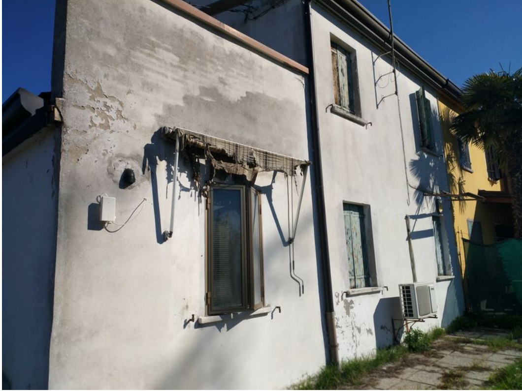
Foto 8 Vista dell'edificio oggetto di stima.
