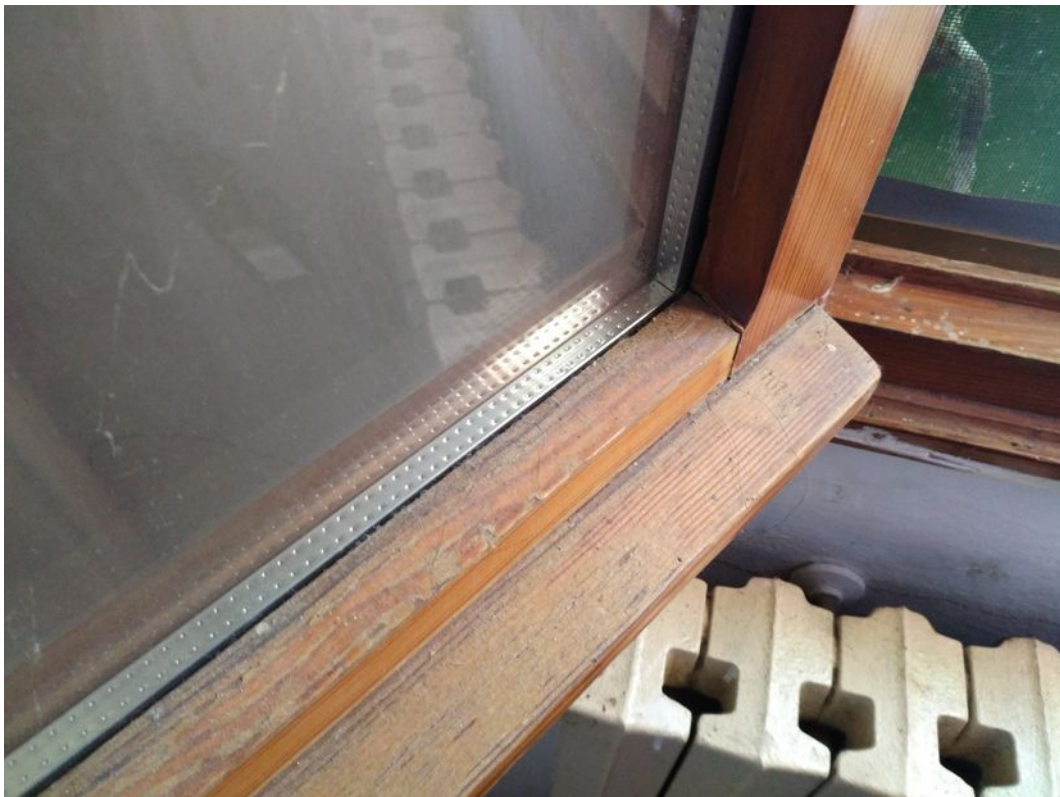
Foto 17 Particolare di un serramento.
