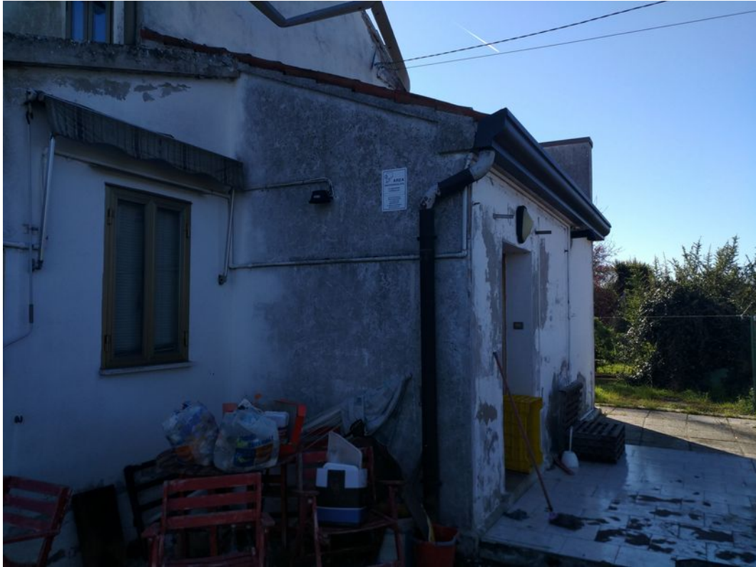
Foto 6 Vista dell'edificio oggetto di stima.
