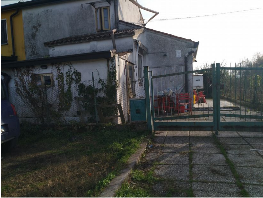
Foto 4 Vista dell'edificio oggetto di stima.
