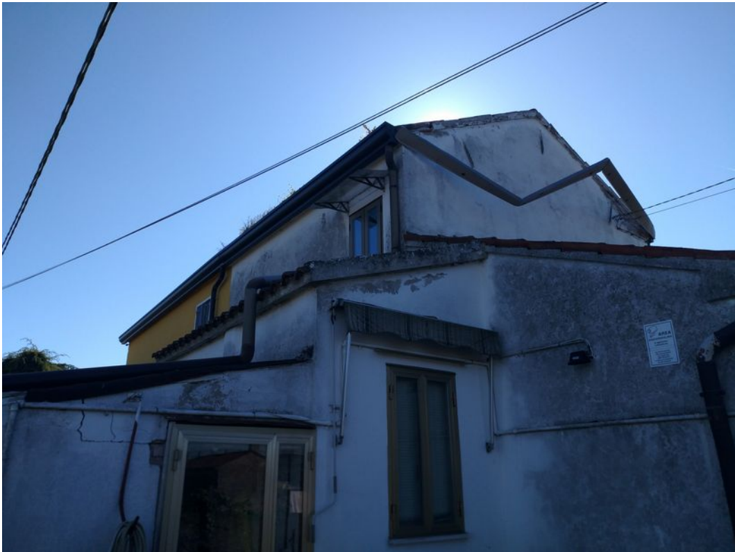
Foto 5 Vista dell'edificio oggetto di stima.
