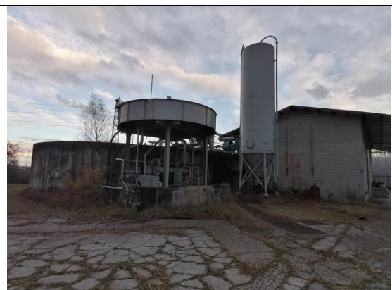
Impianto di depurazione
