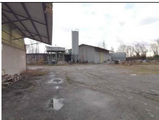
Impianto di depurazione
