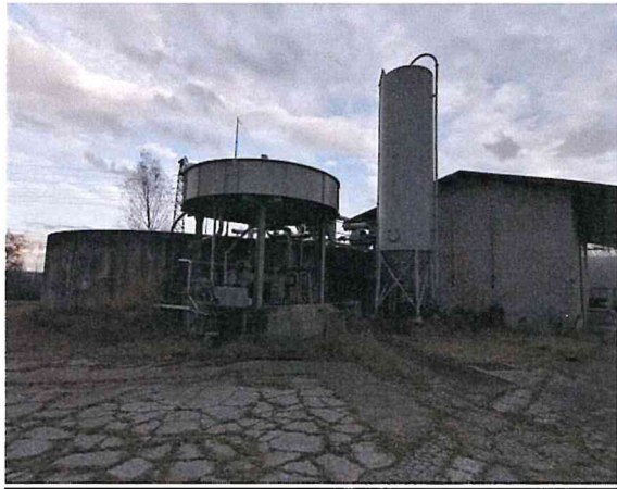
Impianto di depurazione
