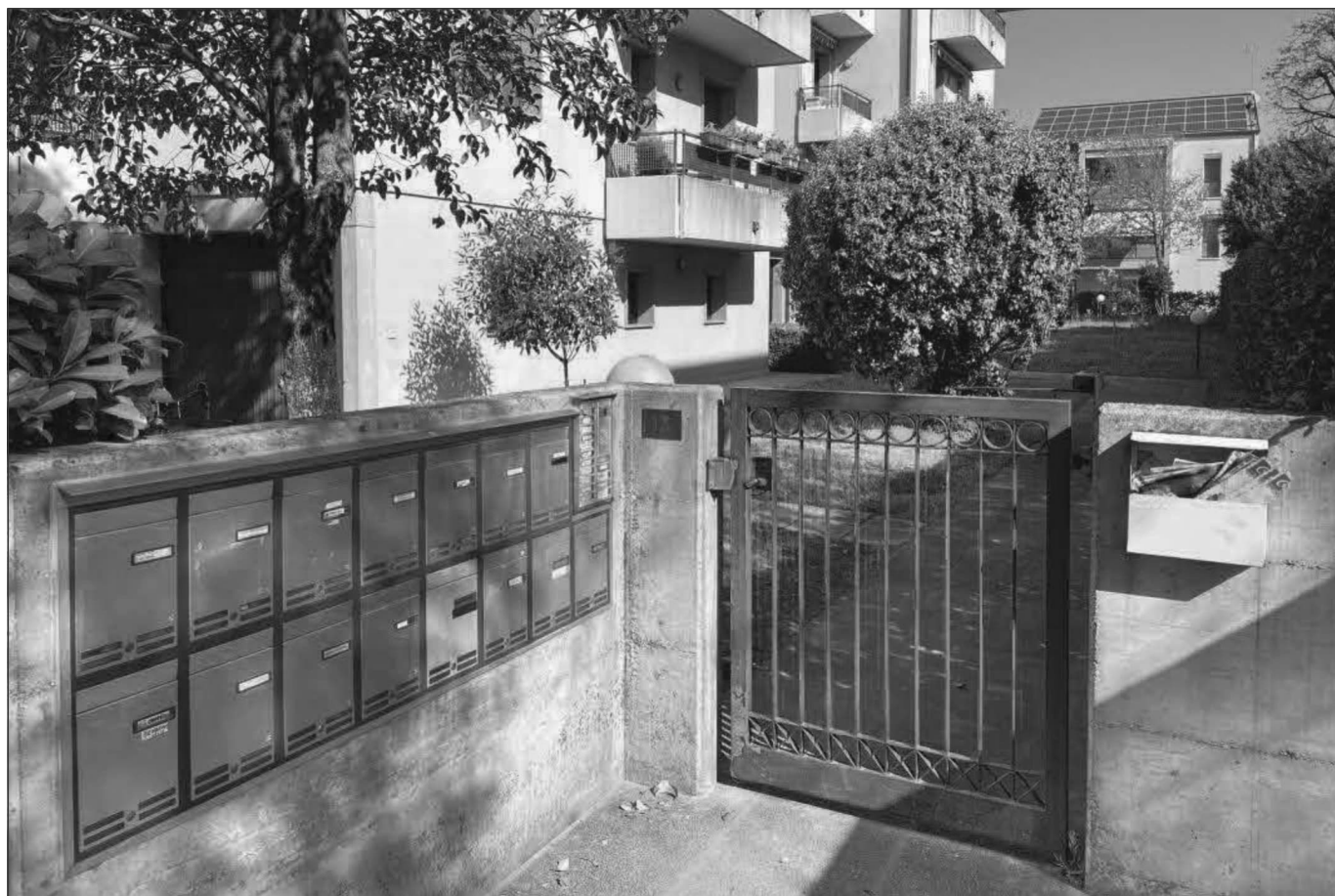
Foto n. 4) Vista dell'accesso pedonale posto ad est
