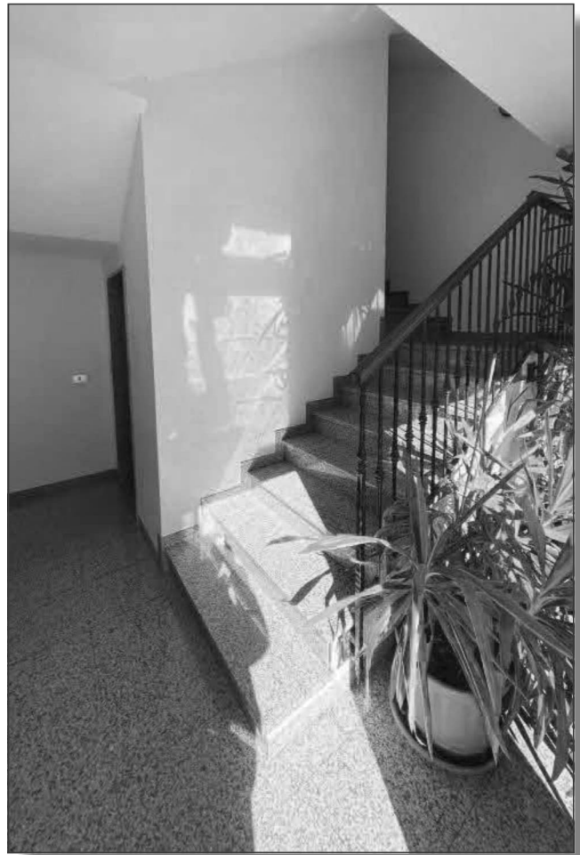
Foto n. 6) Vista del vano scale condominiale
