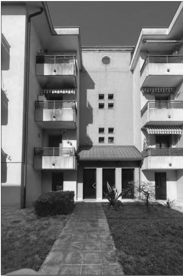
Foto n. 5) Vista dell'androne di ingresso ad est
