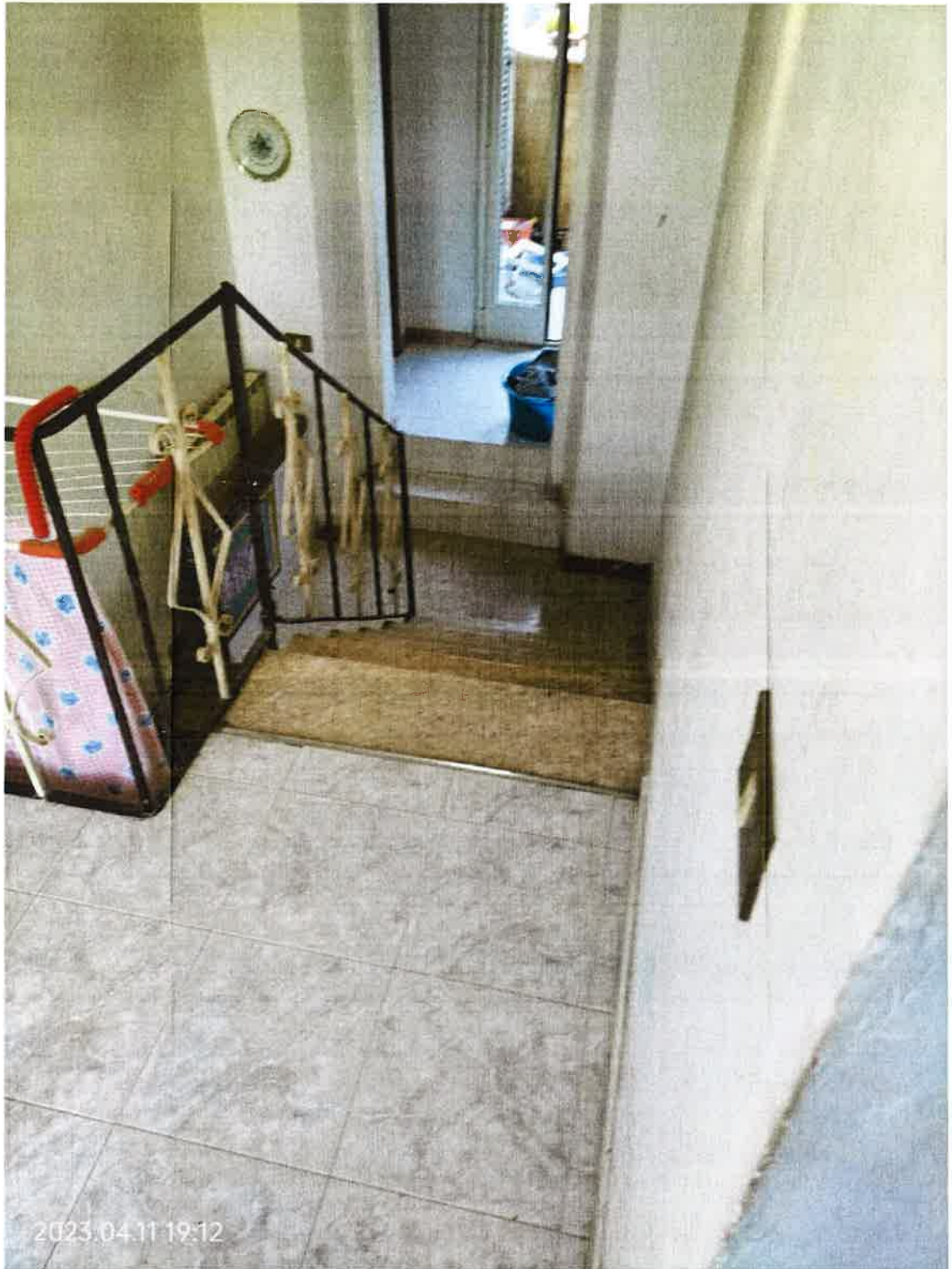
scala interna di accesso al piano primo
