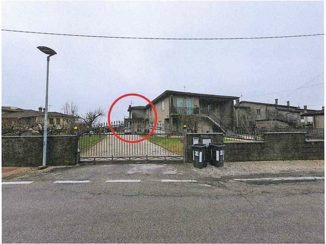
VISTA DA NORD
