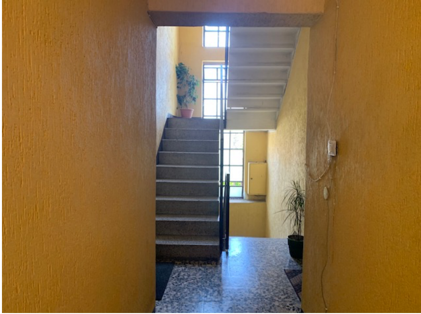
Foto interna – scala comune
