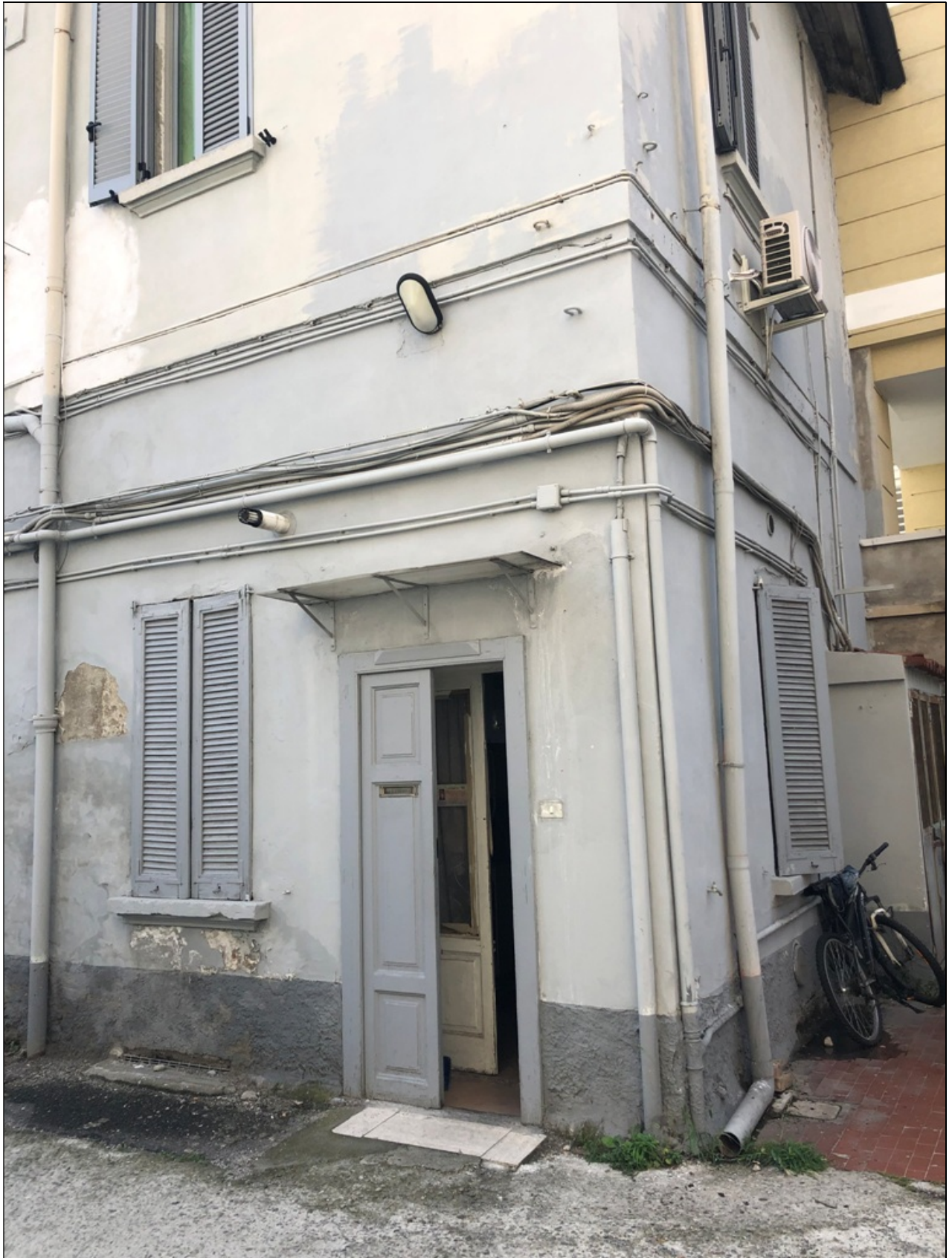
INGRESSO UNITA' IMMOBILIARE OGGETTO DI PERIZIA
