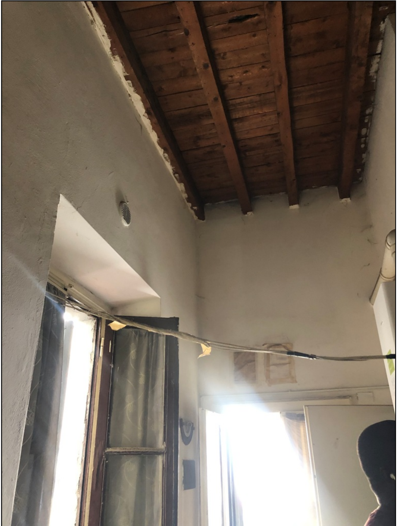
INGRESSO E DETTAGLIO SOFFITTO CON STRUTTURA AVISTA
