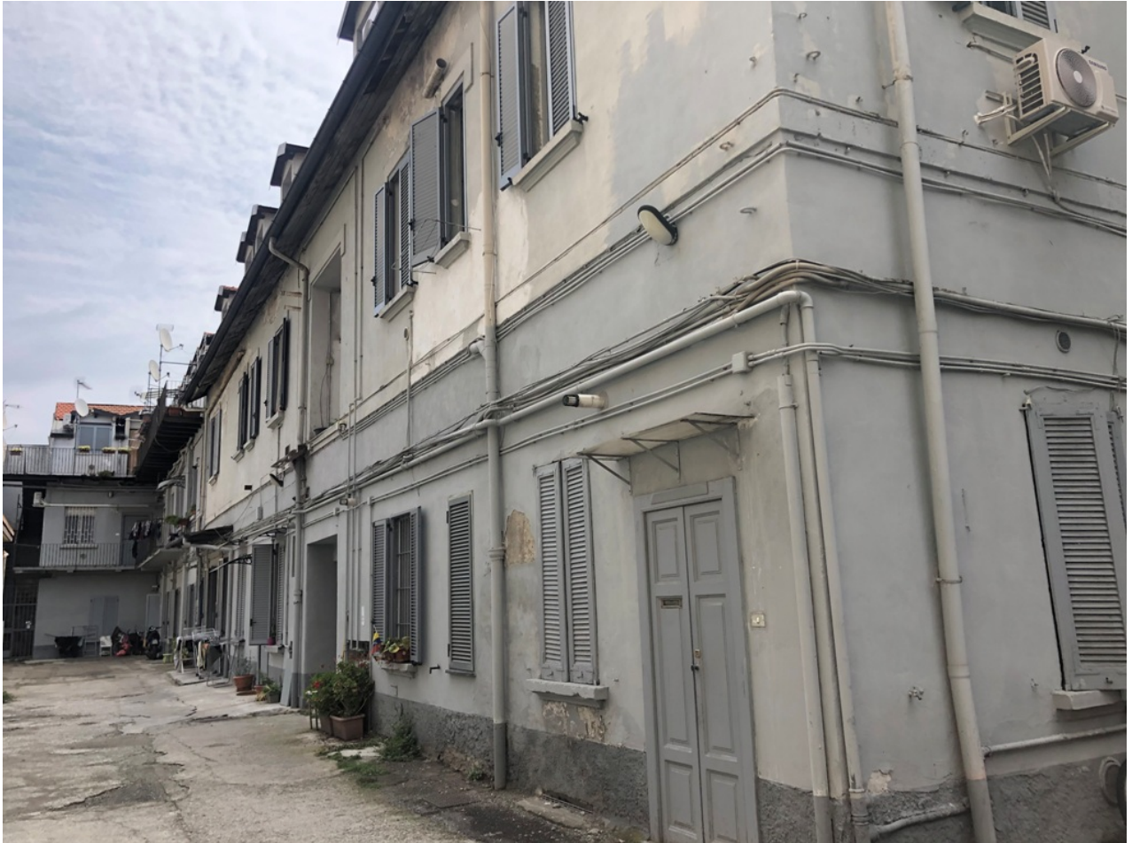
PORTA ACCESSO APPARTAMENTO OGGETTO DI PERIZIA
