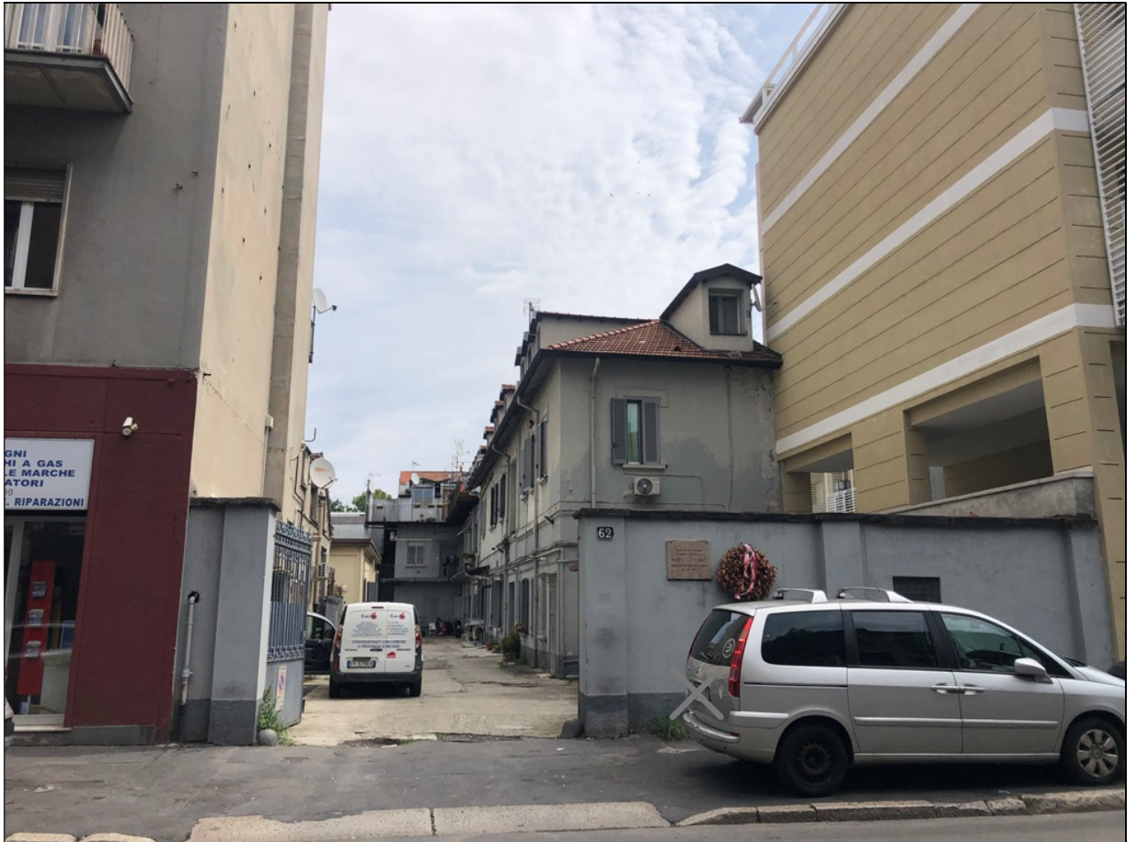
INGRESSO VIA VARESINA CIVICO N. 62
