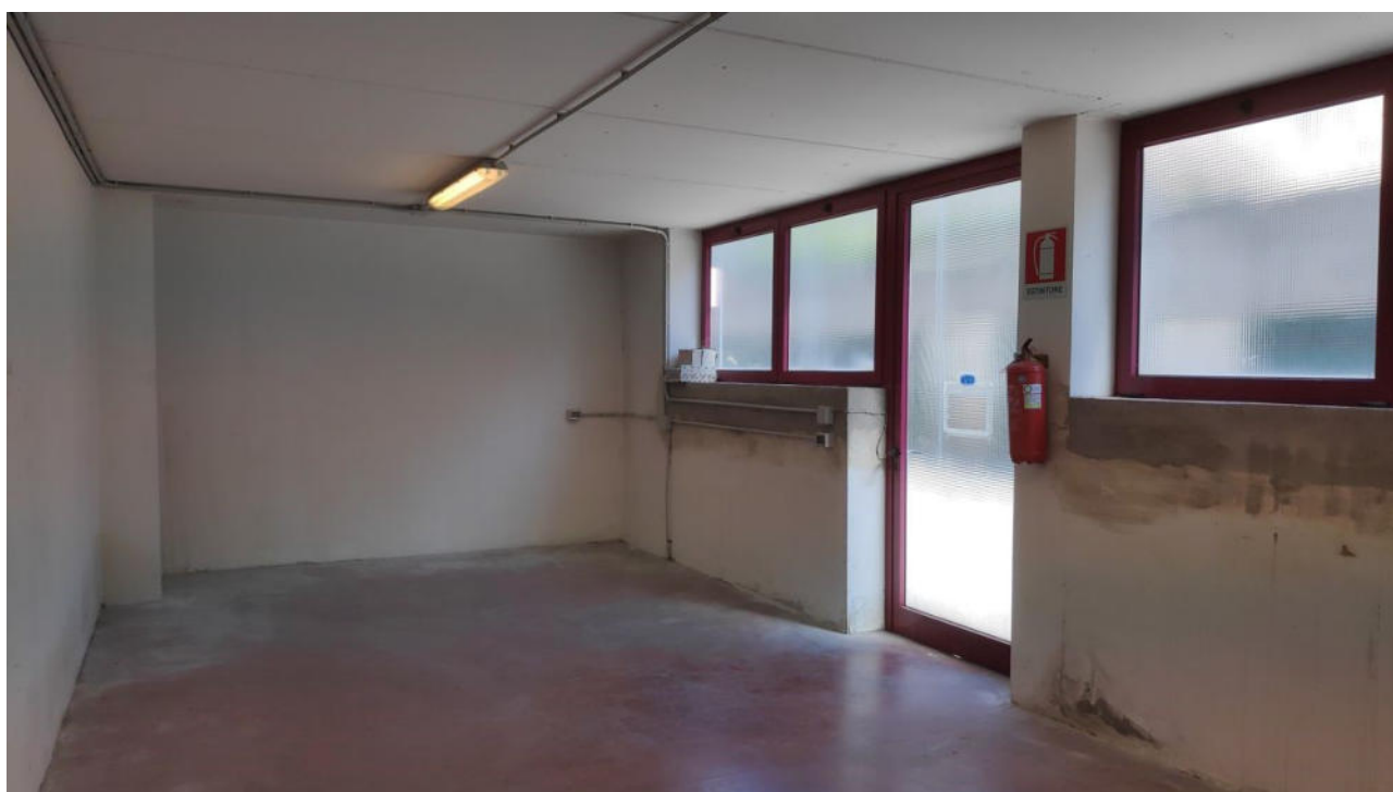
Vista sub. 25 magazzino, con accesso dalla rampa esterna
