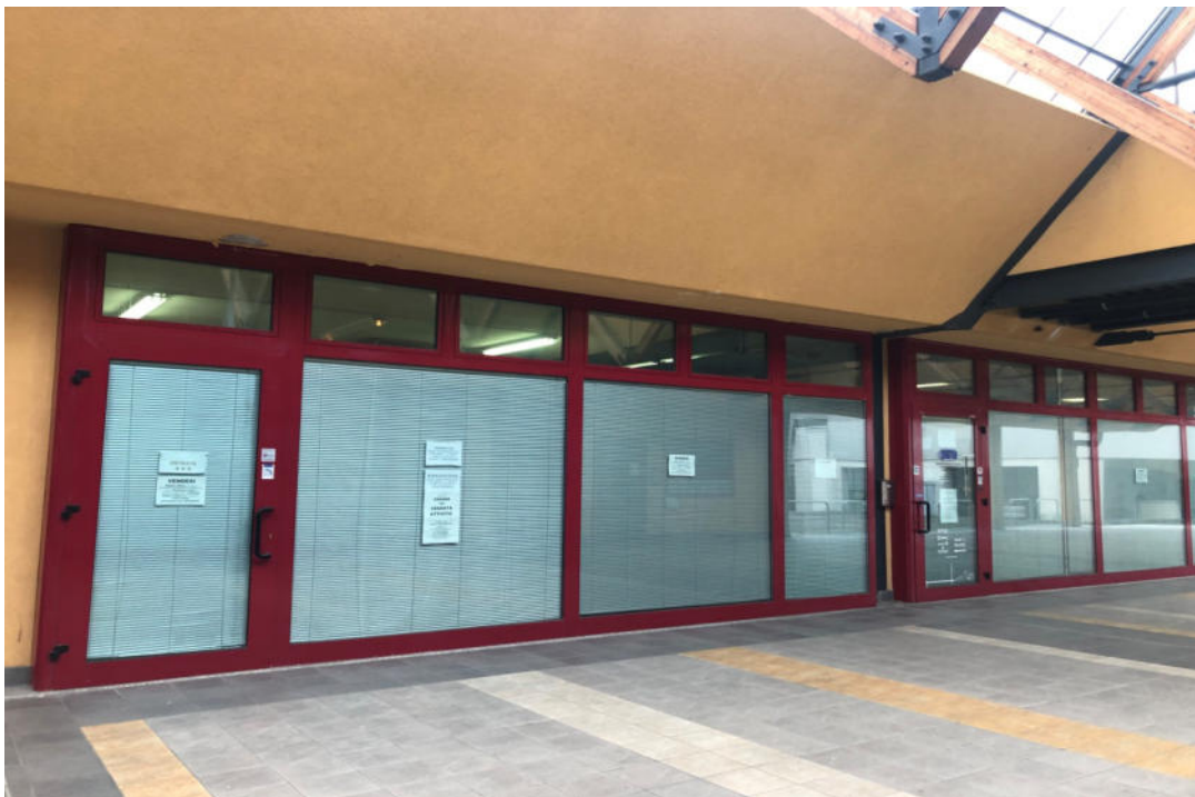
Vista negozi dalla galleria commerciale
