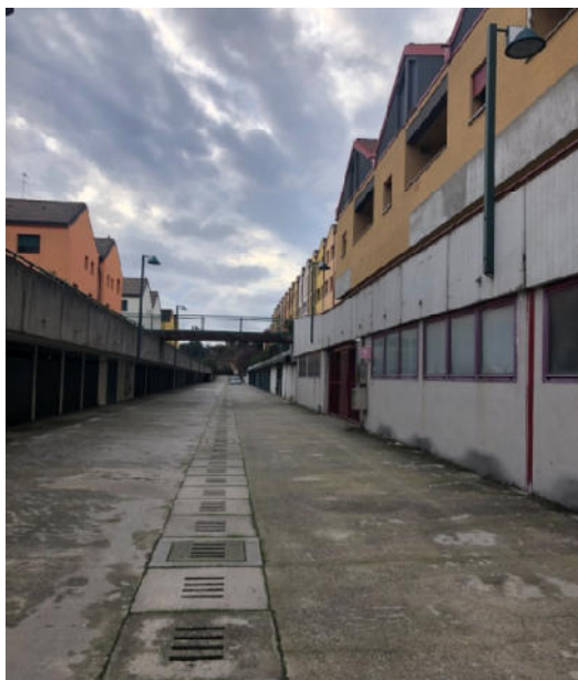
Corsia di accesso ai magazzini e garage
