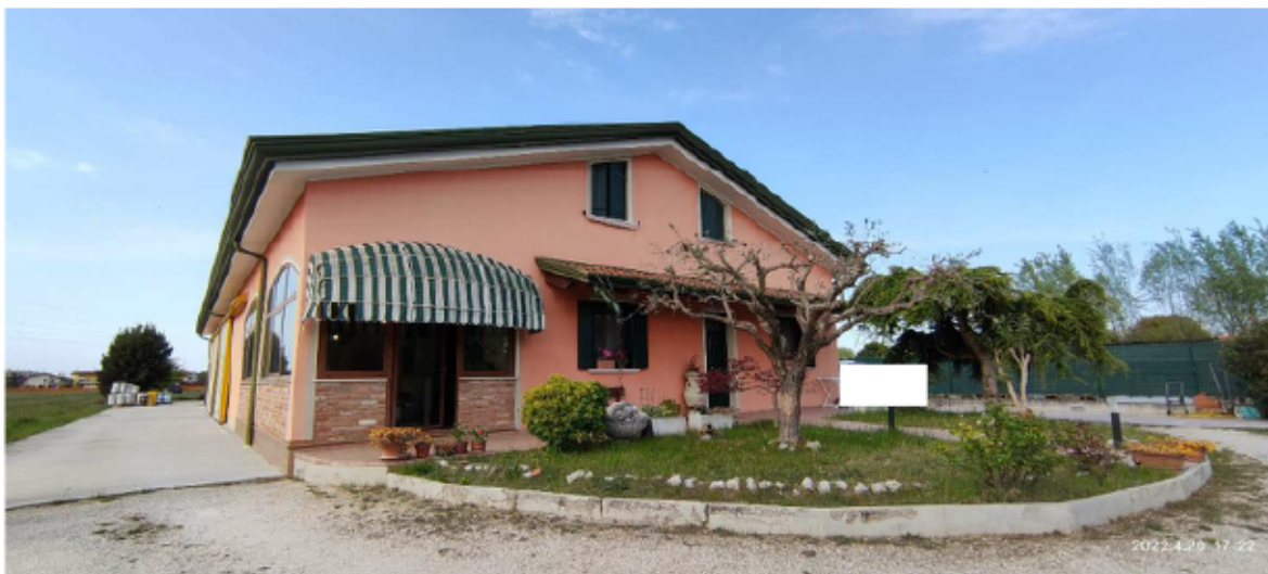
FOTO 1_ PROSPETTI OVEST E SUD
