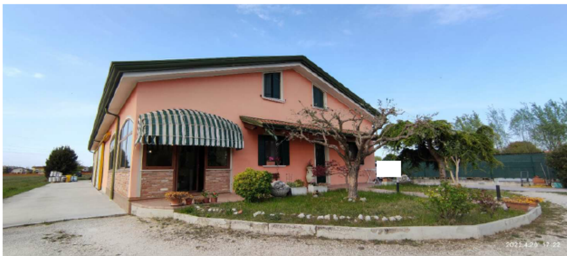
FOTO 1_ PROSPETTI OVEST E SUD
