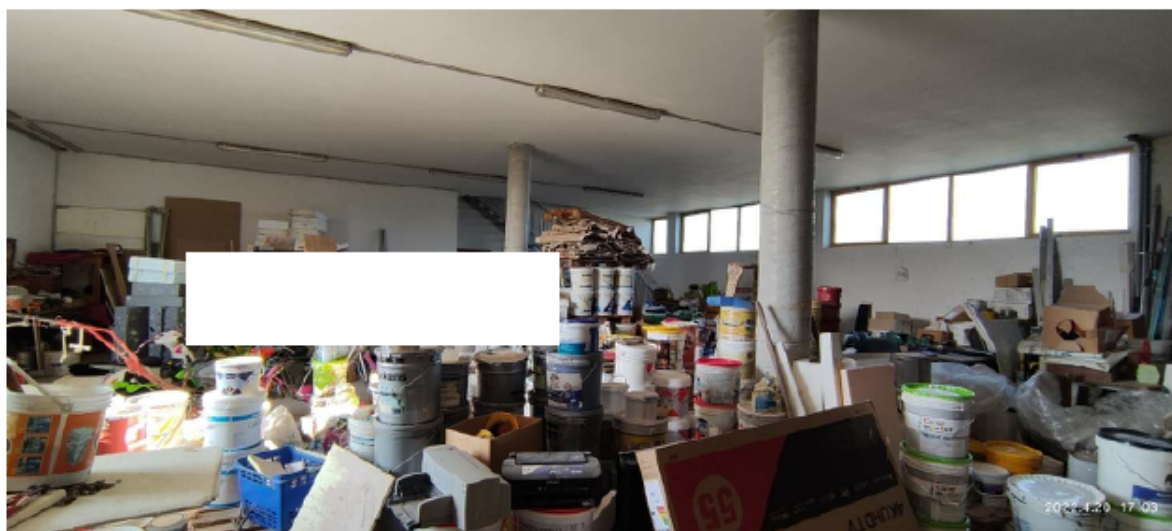
FOTO 7_ MAGAZZINO MATERIALI PER DIPINTURE E RICOVERO ATTREZZATURE
