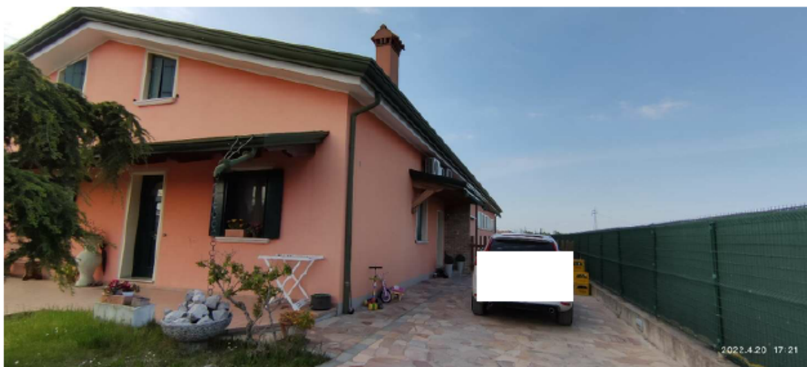
FOTO 2_ PROSPETTI SUD ED EST
