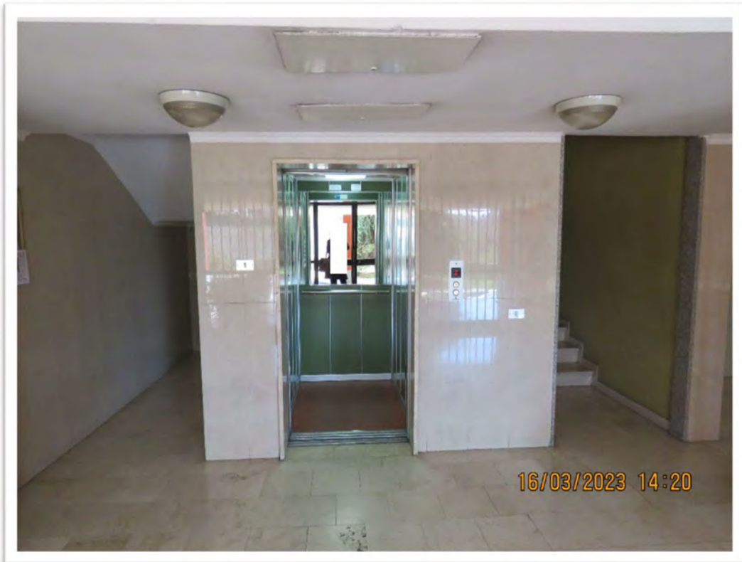
Particolare dell'ingresso condominiale posto al piano seminterrato e del vano scale.
