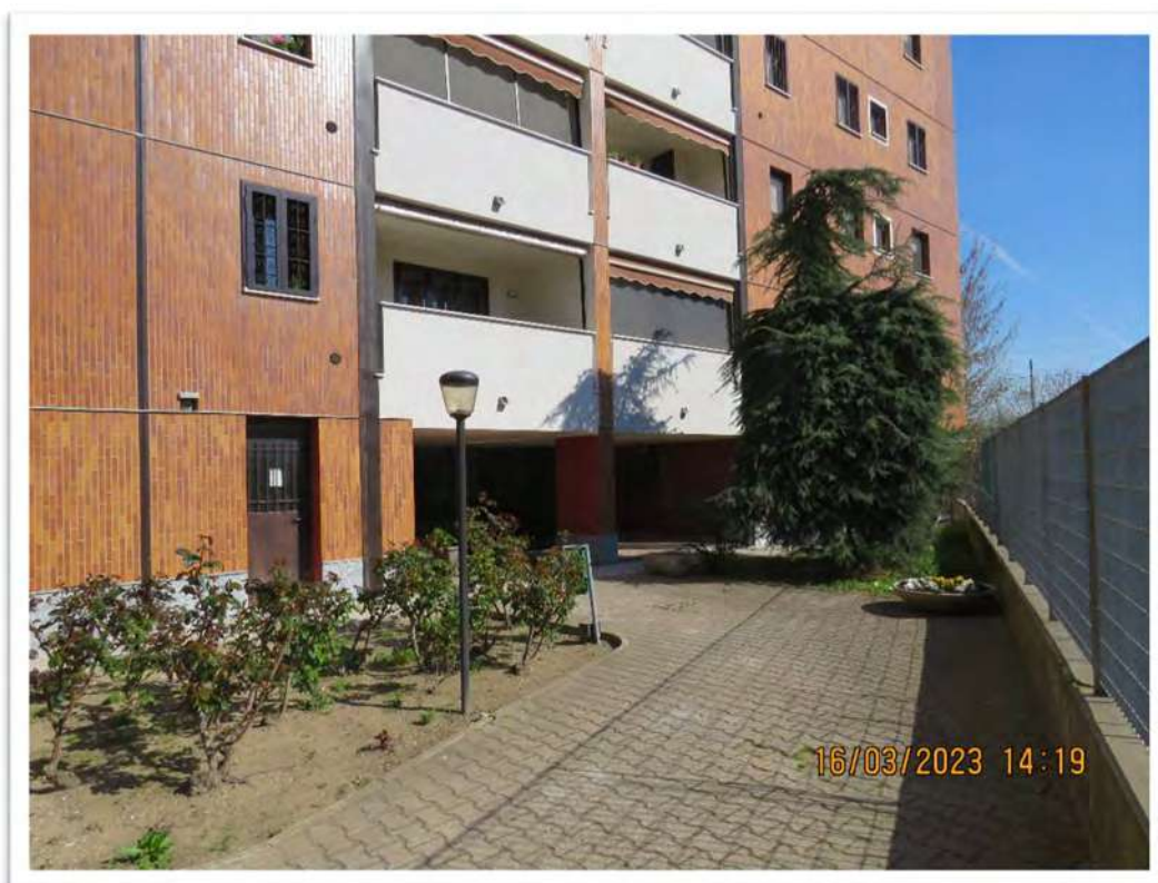
Il fabbricato e l'ingresso al vano scala F.
