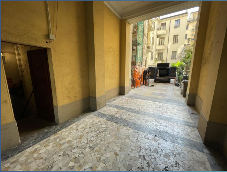
Vano cantina utilizzato (piano seminterrato)
