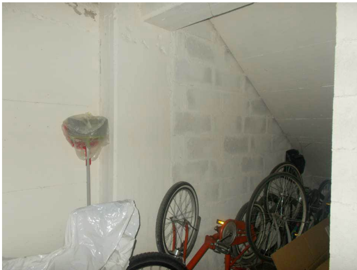
Foto n. 16: vista del ripostiglio sotto la scala.
