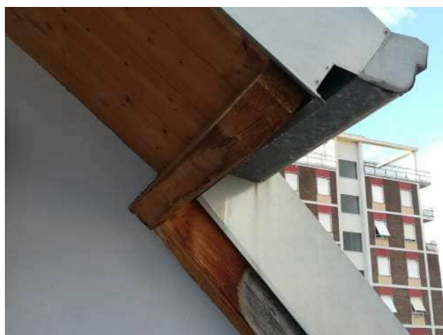
Foto n. 14-15: vista del manto di copertura e canale di gronda sporchi/occlusi.
