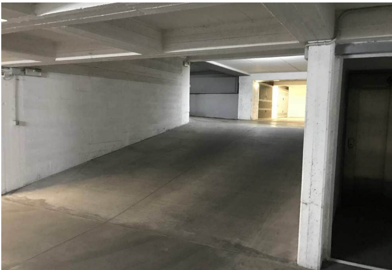
Foto n. 09-10: vista interna della corsia di manovra piano 1° interrato.
