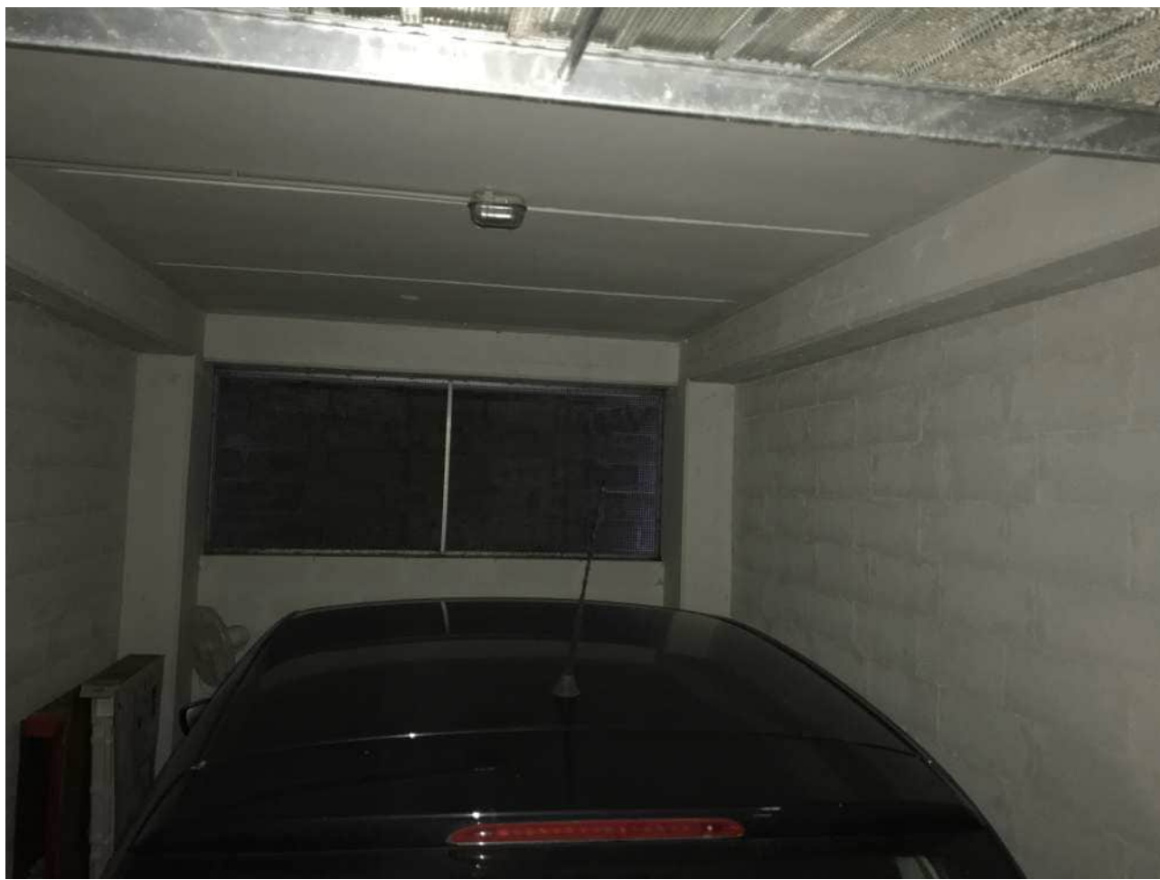
Foto n. 11-12: vista interna del garage.
