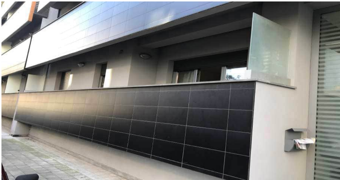
Foto n. 04: vista del balcone al piano primo dell'unità immobiliare in oggetto.
