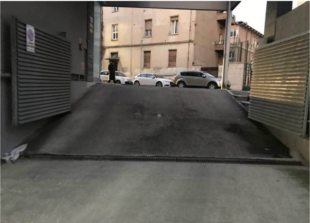
Foto n. 11: vista del cancello di accesso lungo Via Damiano Chiesa.
