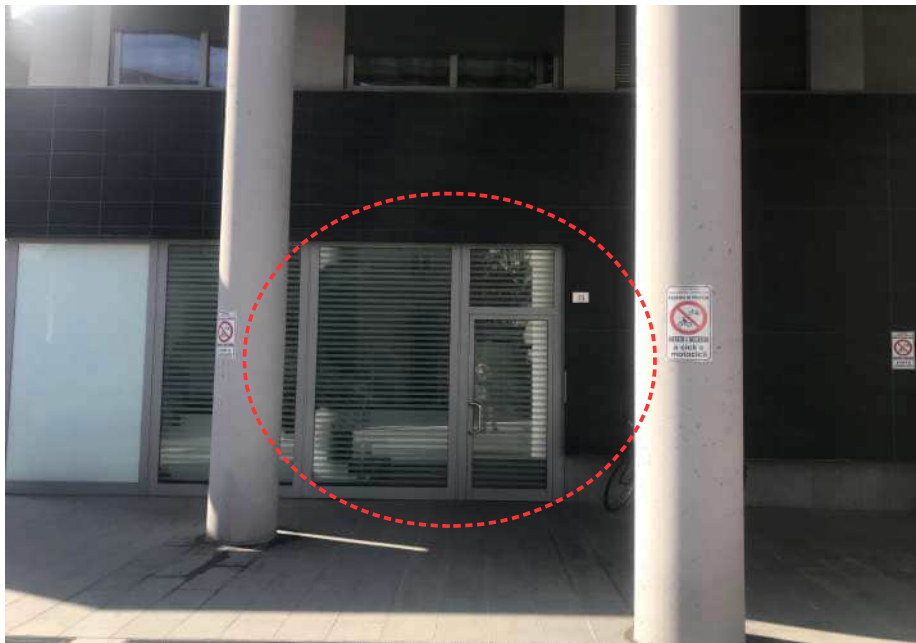
Foto n. 04: vista dell'ingresso - Via Damiano Chiesa n. 15
