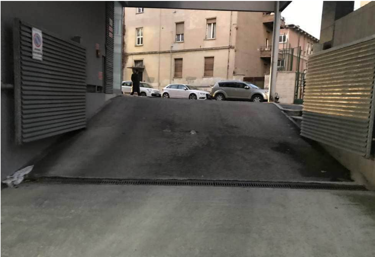
Foto n. 15: vista del cancello di accesso da Via Damiano Chiesa.
