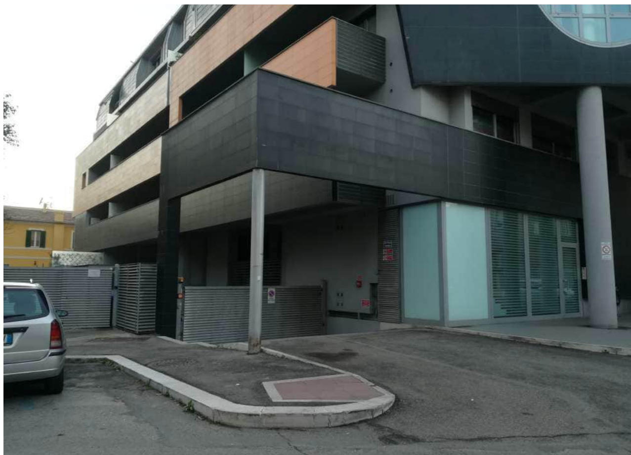
Foto n. 04: vista dell'ingresso ai locali autorimesse lungo Via Damiano Chiesa.
