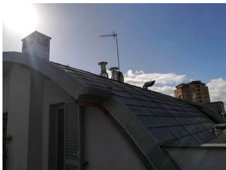
Foto n. 14-15: vista del manto di copertura e canale di gronda sporchi/occlusi.
