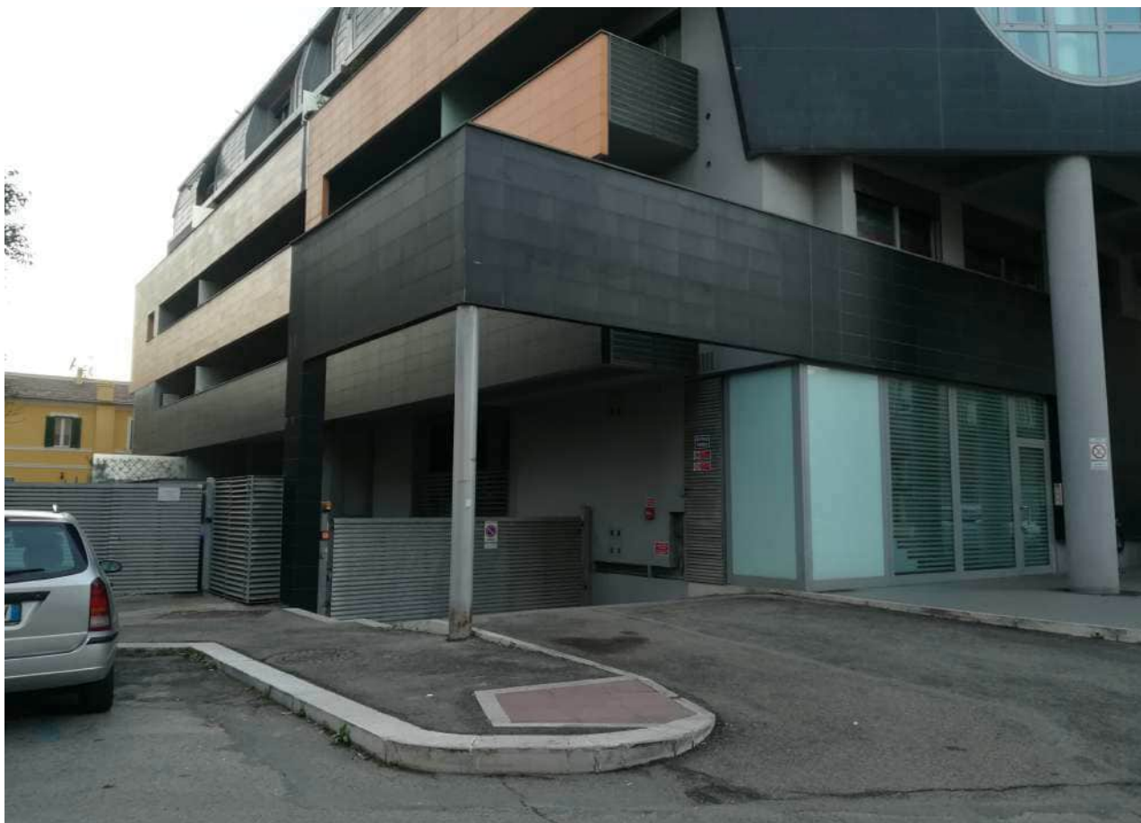
Foto n. 05-06: vista dell'ingresso ai locali autorimesse lungo Via Damiano Chiesa e dell'ingresso del locale Centrale Termica.
