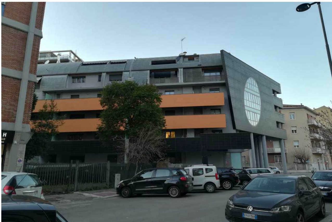
Foto n. 03: prospetto laterale del fabbricato lungo Via Damiano Chiesa.
