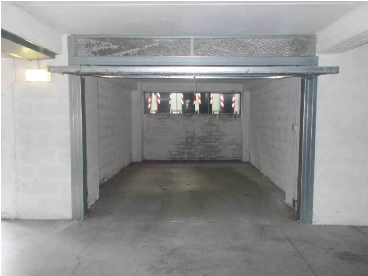
Foto n. 12-13: vista interna del garage dalla corsia di manovra.
