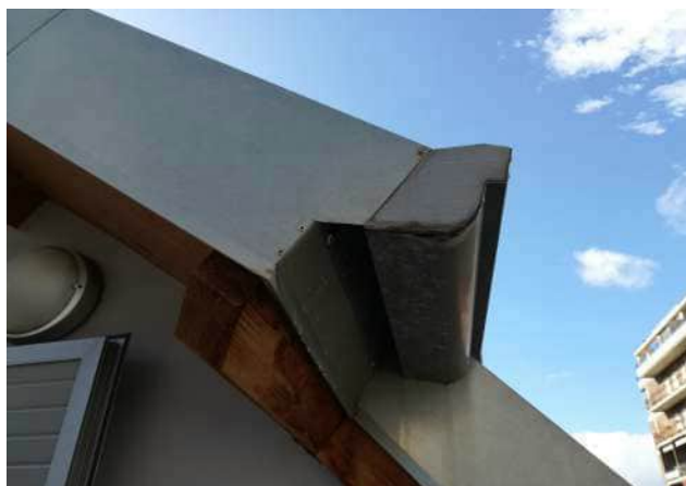
Foto n. 10-13: vista delle scossaline e canale di gronda deteriorate.
