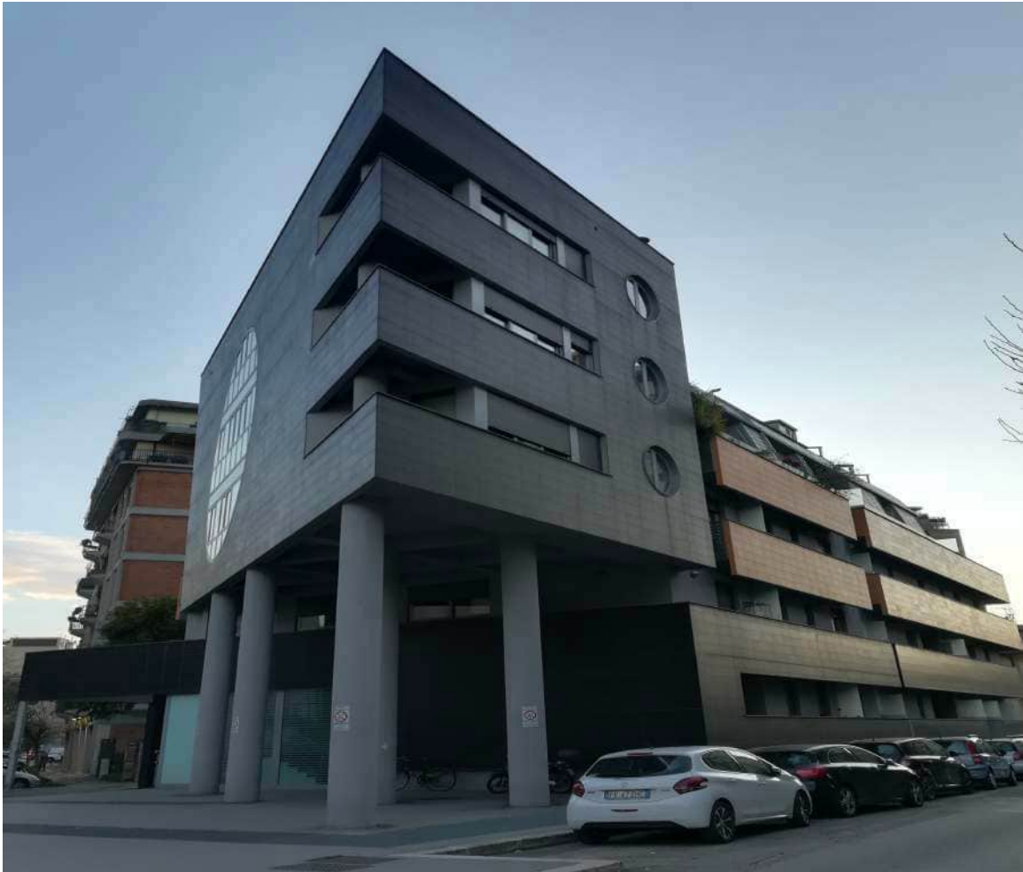
Foto n. 03: prospetto del fabbricato – Via Nazario Sauro, n. 32 (TR)
