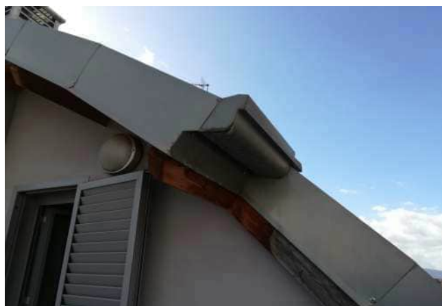
Foto n. 10-13: vista delle scossaline e canale di gronda deteriorate.
