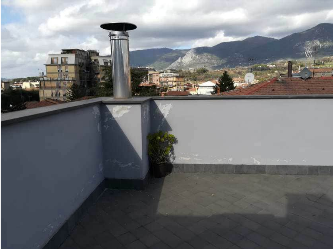
Foto n. 16-17: vista del lastrico solare - parapetto e pozzetti di raccolta.
