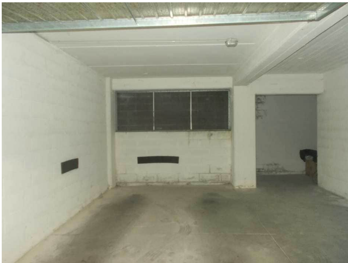
Foto n. 14-15: vista interna del garage.
