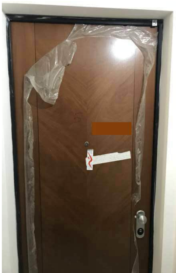
Foto n. 07: vista del portone di accesso all'u. imm.
