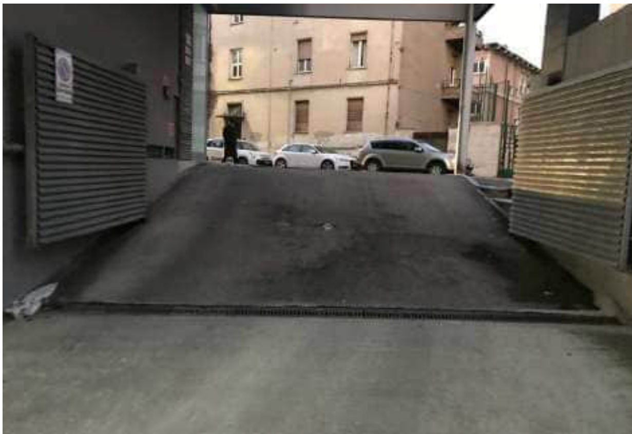
Foto n. 07-08: vista interna della rampa di accesso ai garages.
