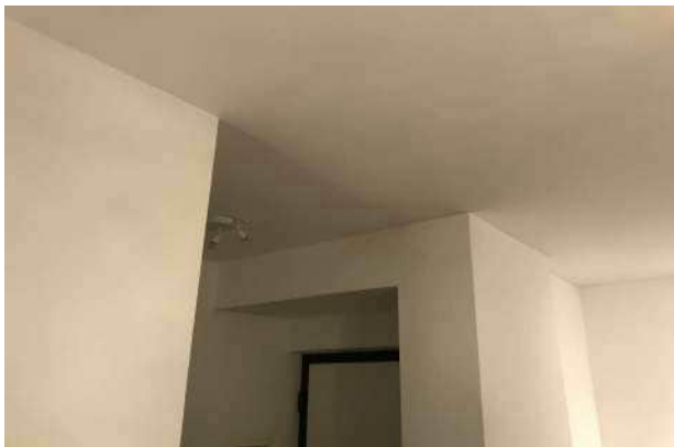
Foto n. 15-16: vista dei disimpegni: ingresso - zona notte.
