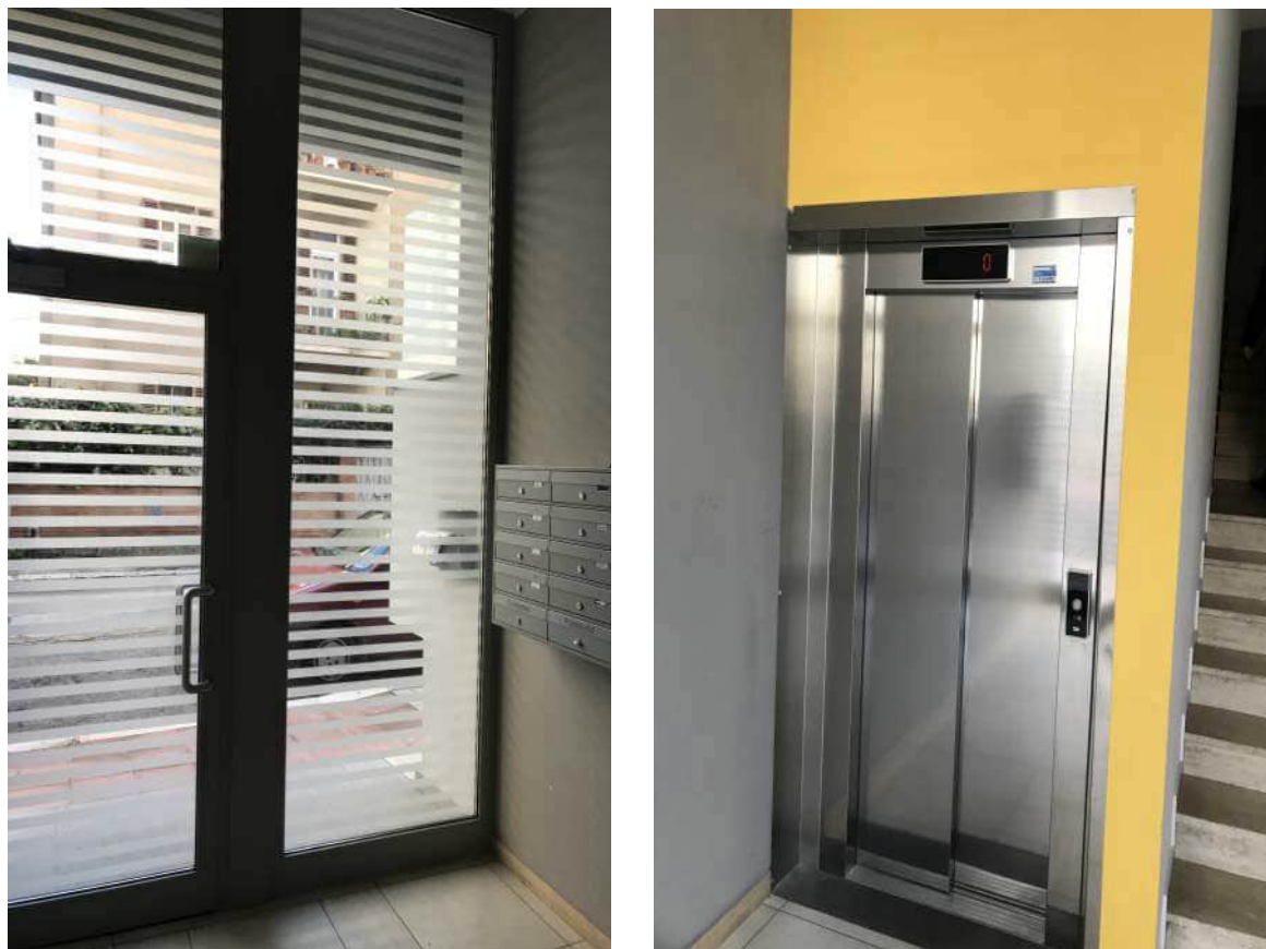
Foto n. 05-06: vista interna dell'ingresso del fabbricato – androne e dell'ascensore/scala di collegamento.
