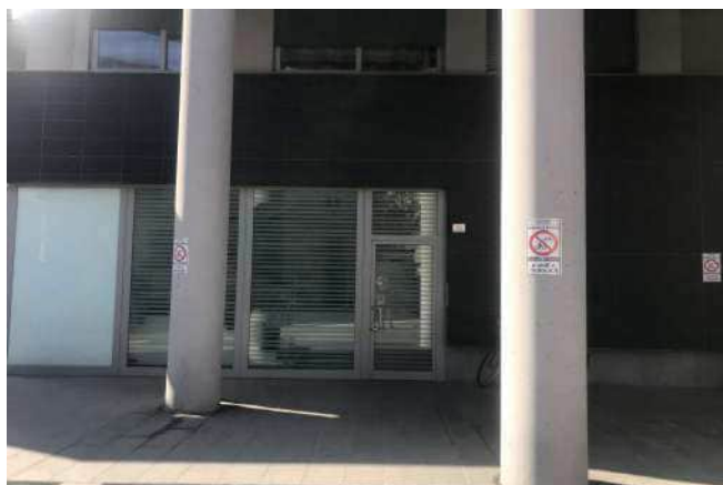
Foto n. 02-03: ingresso del fabbricato dalla sede stradale – Via Damiano Chiesa, n, 15 (TR)
