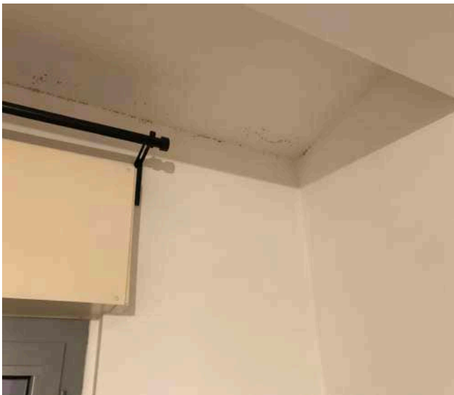
Foto n. 22-23: vista interna della camera matrimoniale - macchie causate da infiltrazioni meteoriche provenienti dalla loggia/parapetto dell'unità imm. soprastante (p.5°) .
