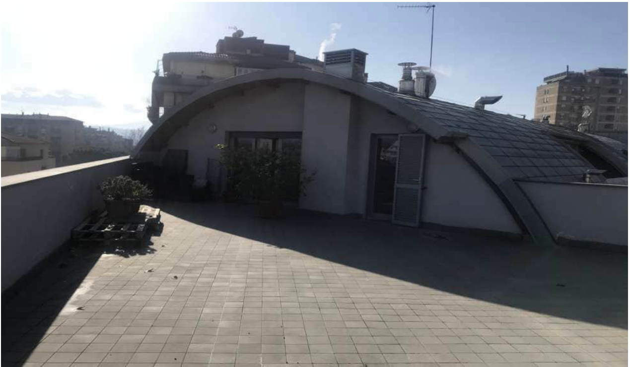
Foto n. 18-19: vista del lastrico solare di copertura
