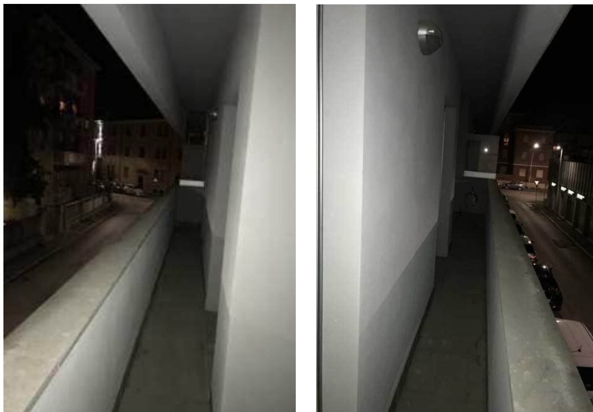
Foto n. 13-14: vista del balcone lungo la sede stradale.
