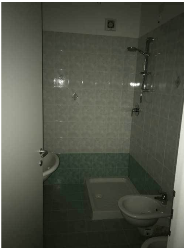
Foto n. 12: vista del servizio igienico.
