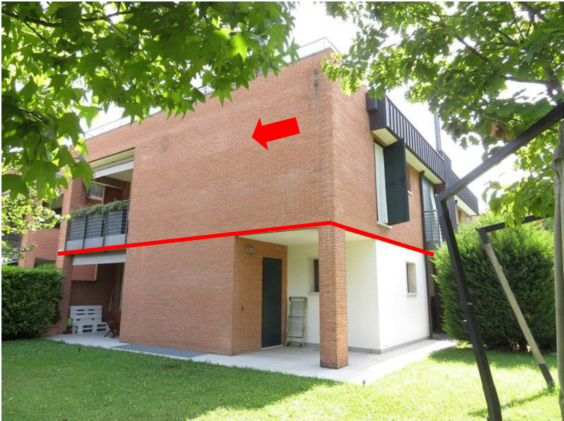
Vista del fabbricato
