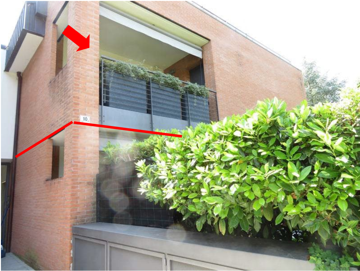
Vista del fabbricato
