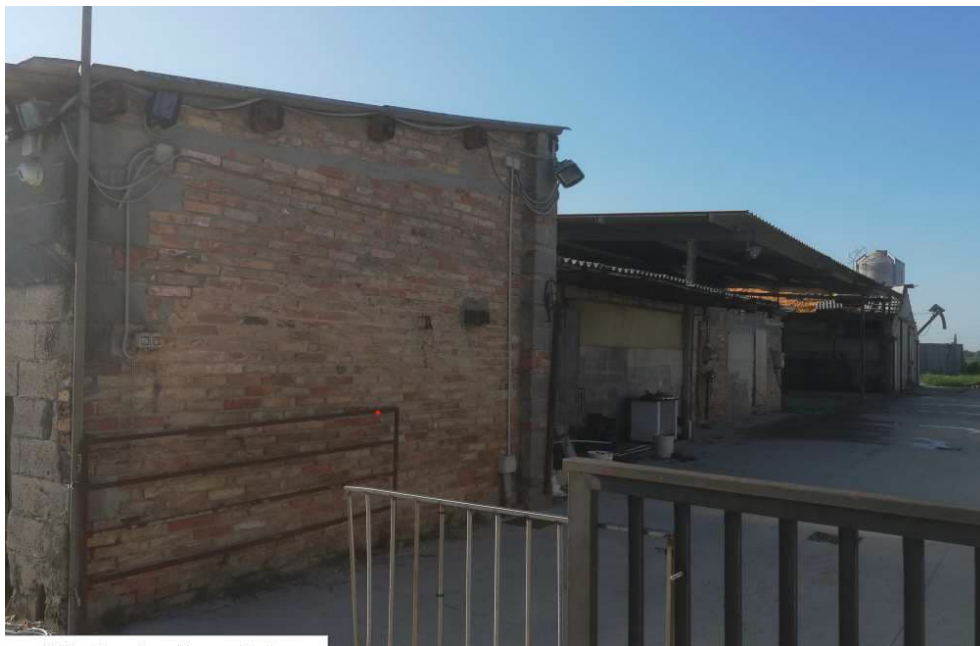
Vista Corpo B – stalle e annessi - fronte ovest
