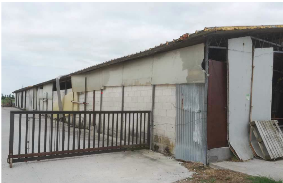
Vista Corpo C – stalla – fronte nord est
