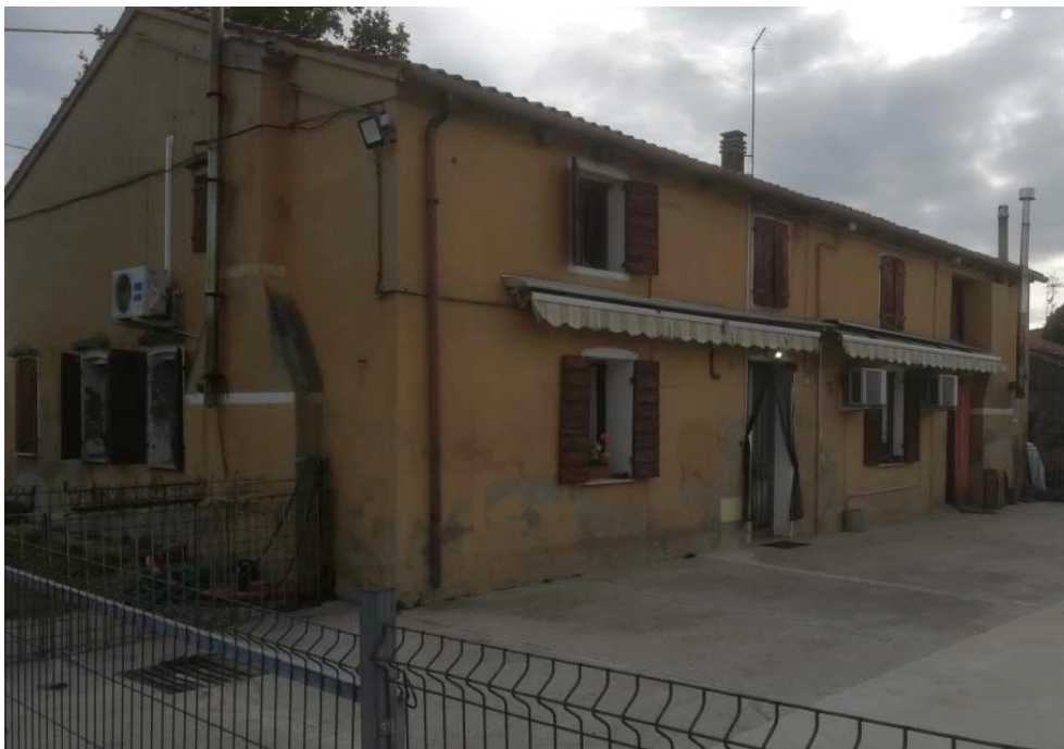
Vista Corpo A – residenza e annessi - fronte sud e ovest
