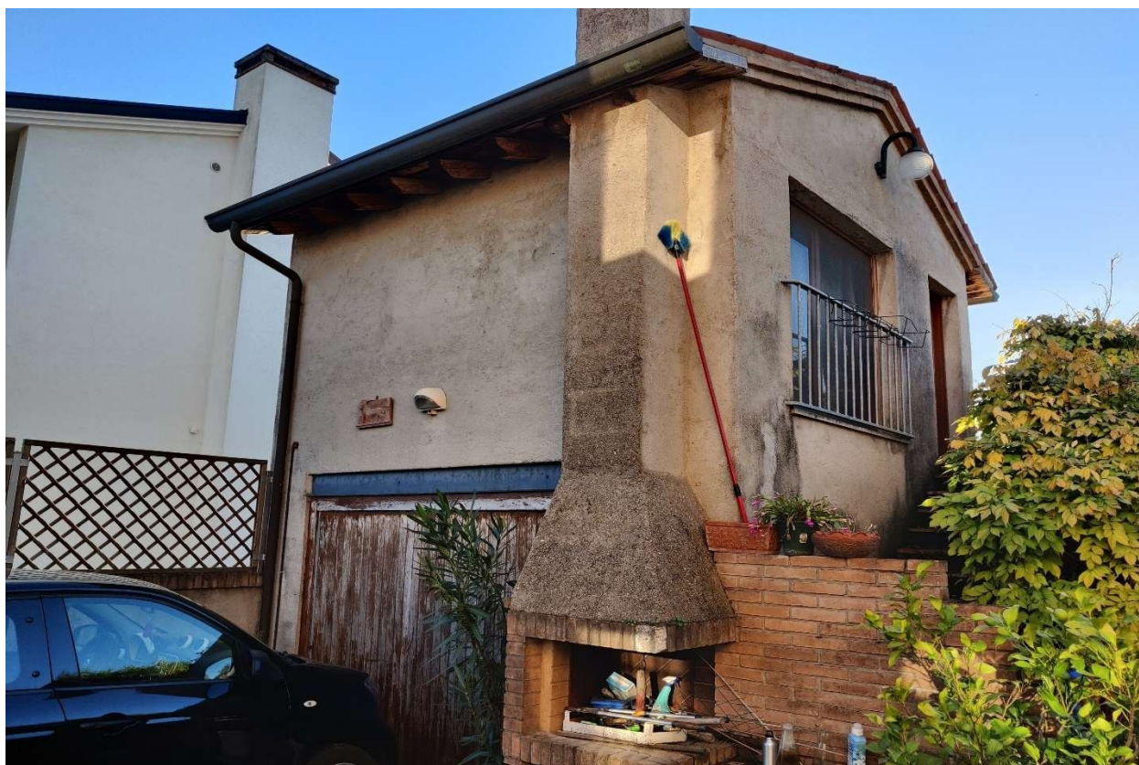
Foto n. 5 - Corpo d fabbrica secondario, con autorimessa e vano accessori al civile.
