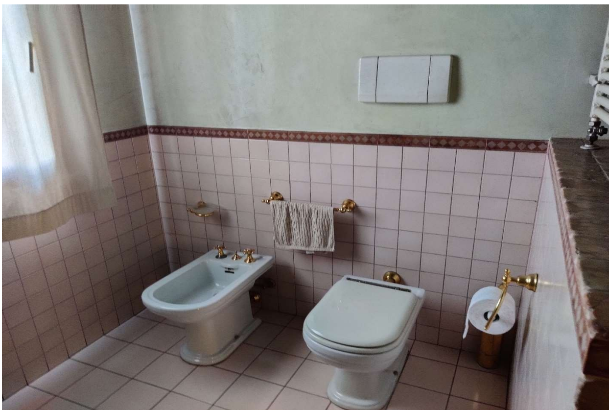
Foto n. 26 - Bagno al piano primo. In evidenza sanitari in ceramica bianca con rubinetteria in metallo color oro.
