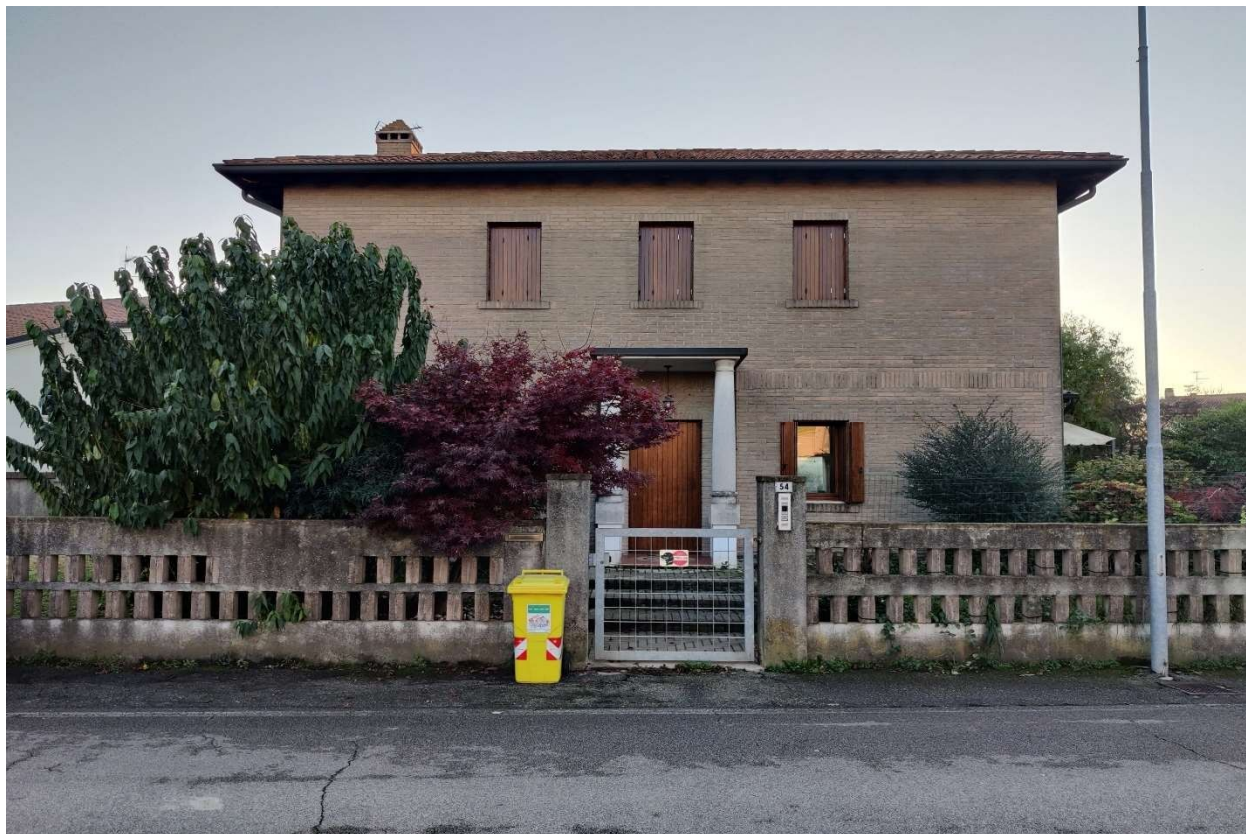
Foto n. 1 - Abitazione con autorimessa, vista da via Giacomo Leopardi (facciata rivolta ad Nord),
