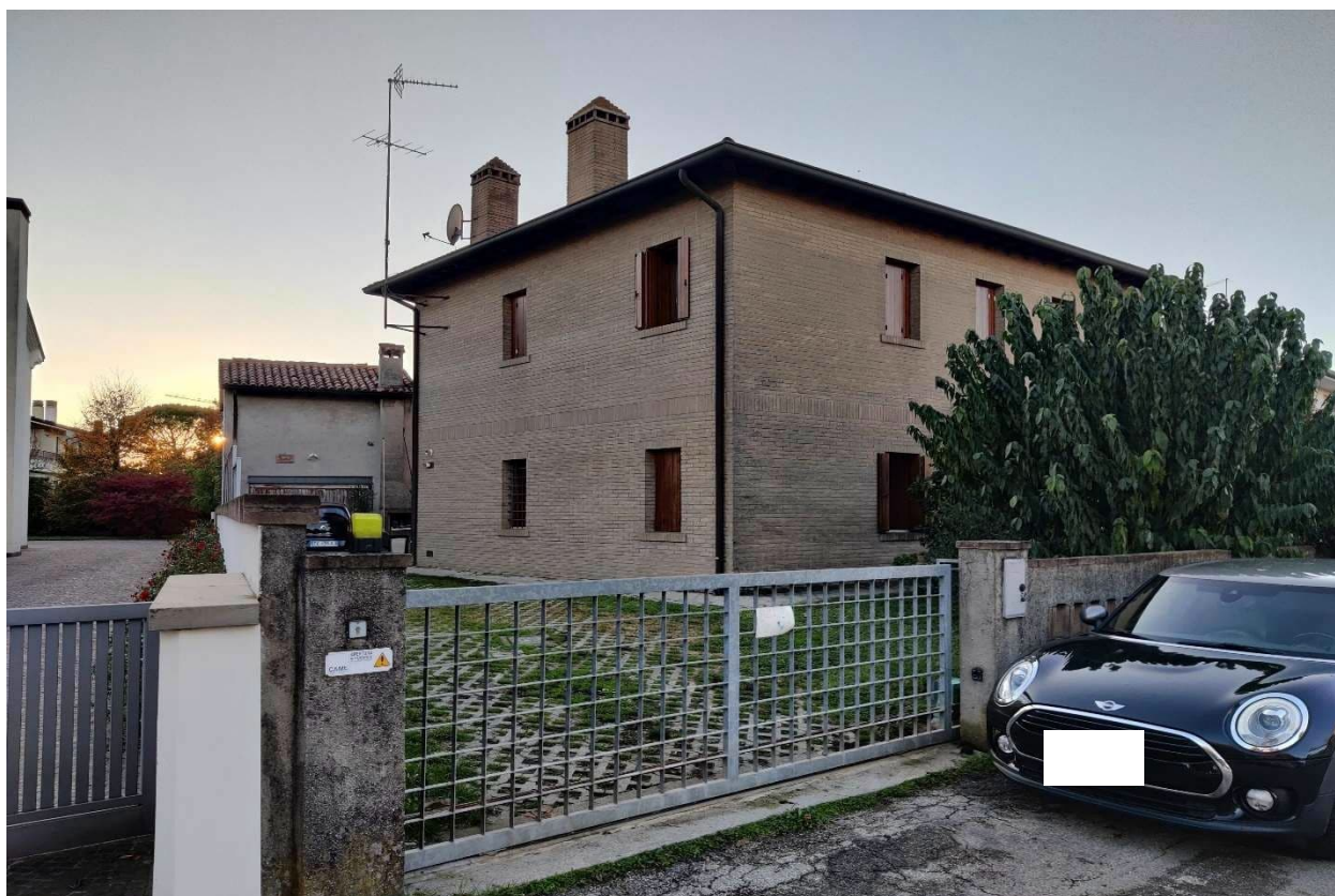
Foto n. 2 - Abitazione con autorimessa vista da via Giacomo Leopardi (facciata rivolta ad Nord - Est).
