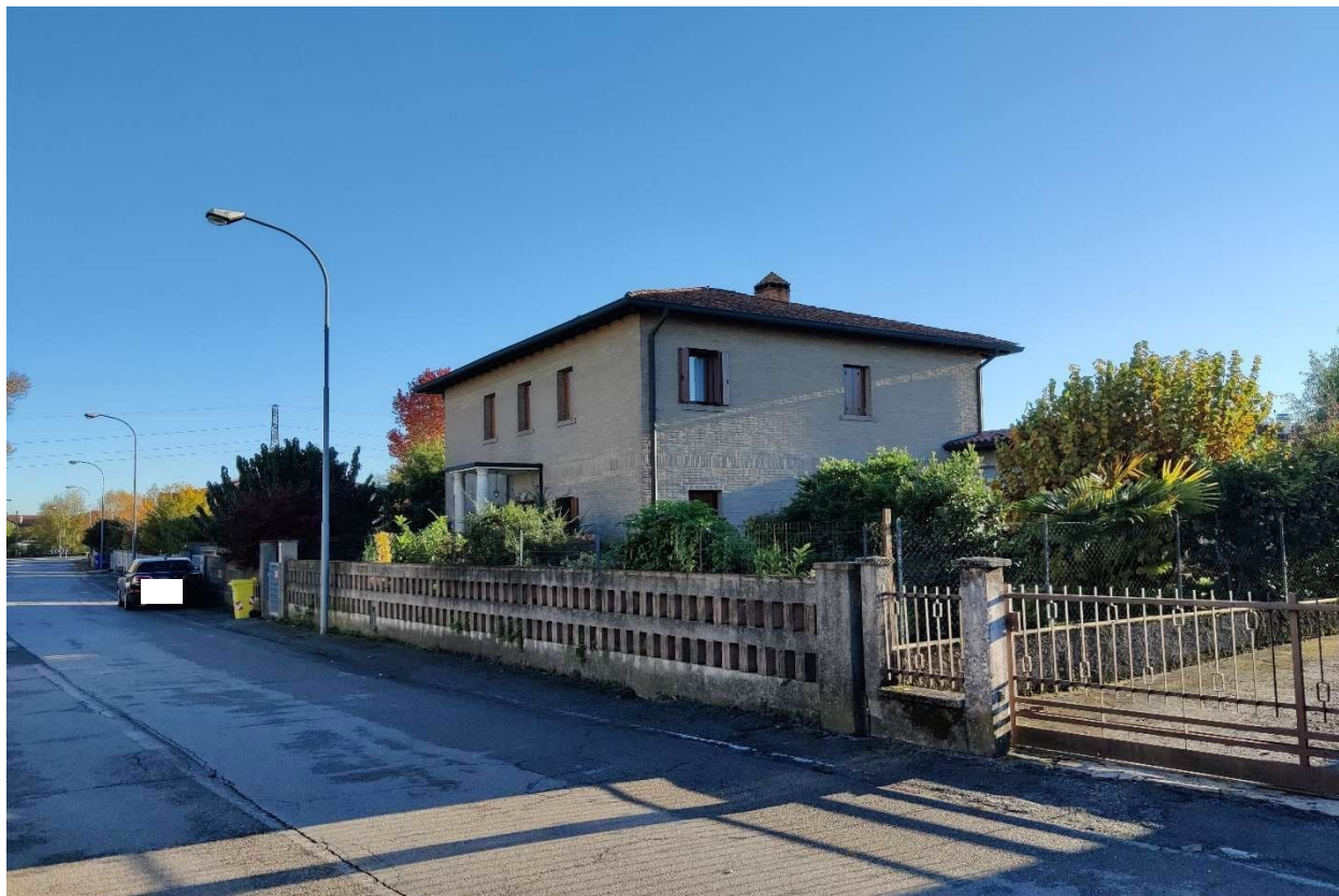
Foto n. 3 - Abitazione con autorimessa vista da via Giacomo Leopardi (facciata rivolta ad Nord - Ovest).
