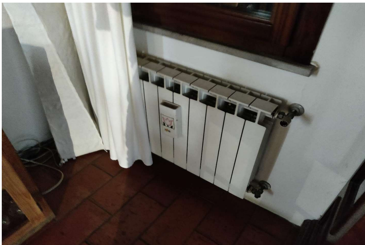
Foto n. 34 - Tipologia di termosifoni presenti.
