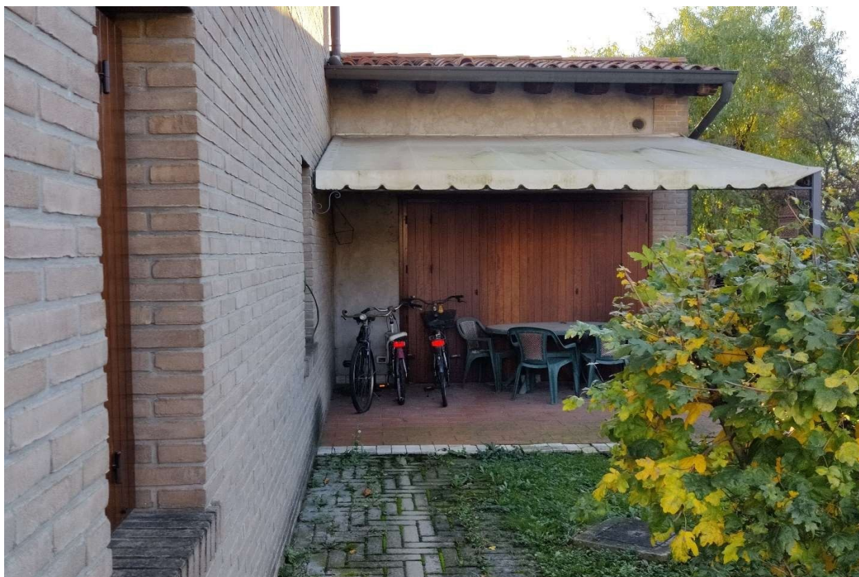
Foto n. 8 - Tettoia antistante la cucina, con struttura metallica leggera e copertura in tessuto.
