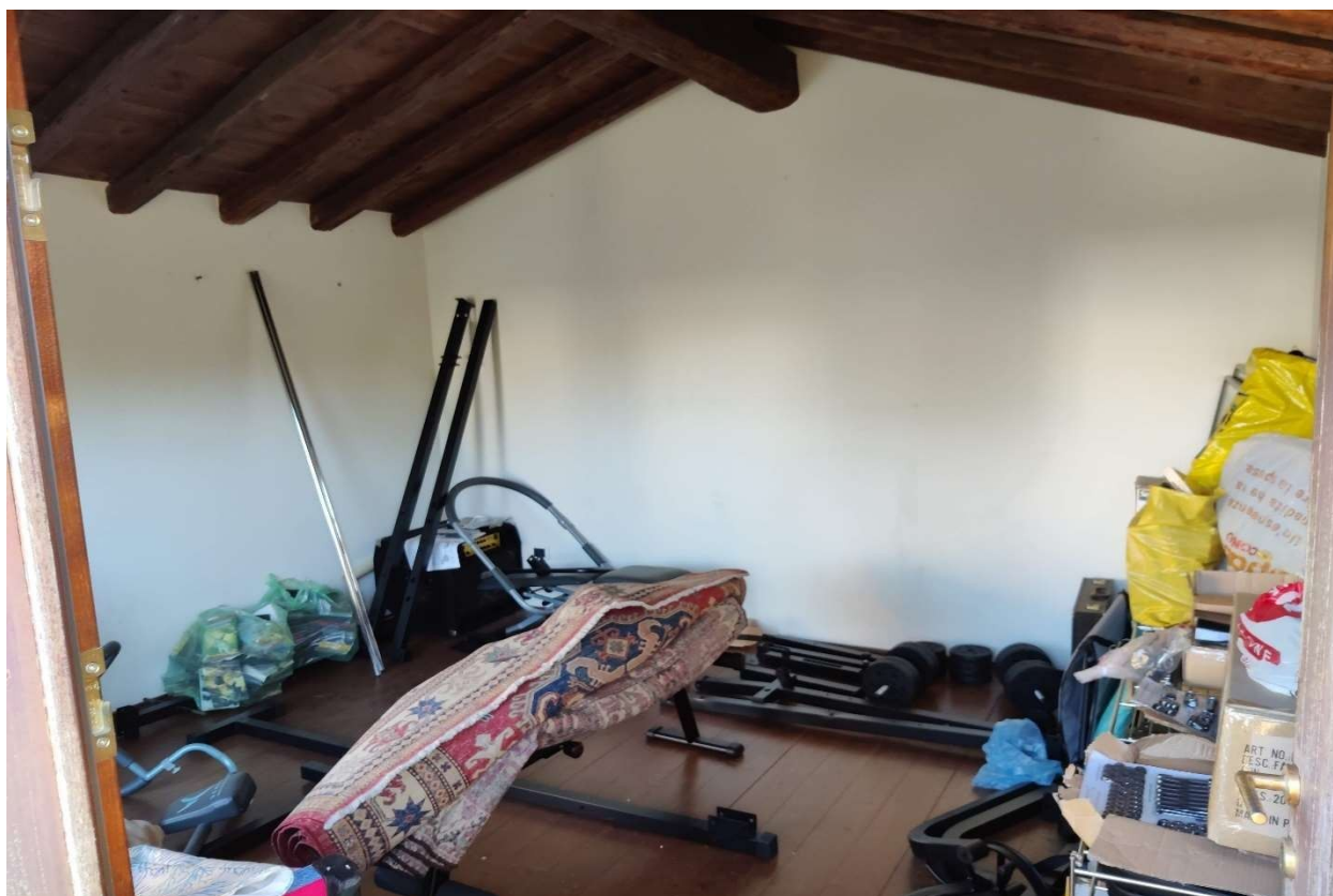
Foto n. 28 - Locale accessorio al piano primo del fabbricato secondario, che ospita il garage al piano terra.
