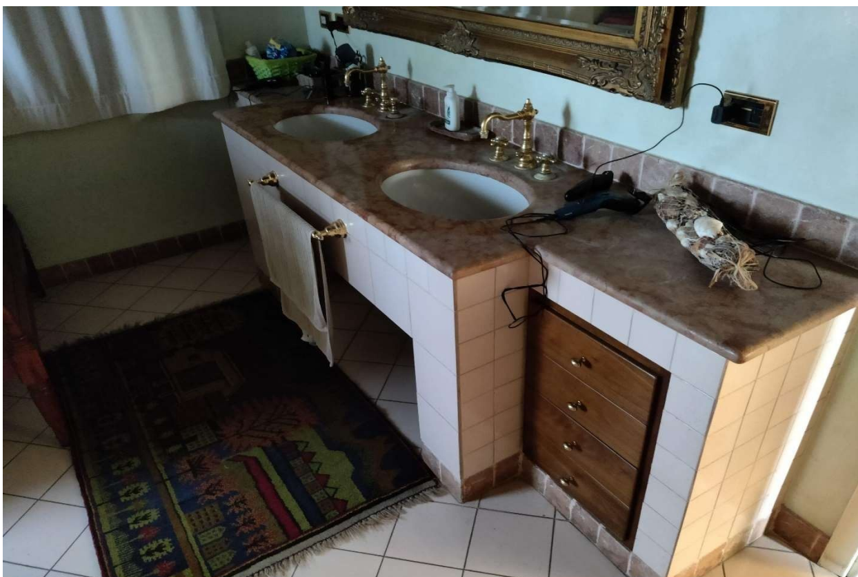
Foto n. 24 - Bagno al piano primo. In evidenza mobile del lavello in muratura.
