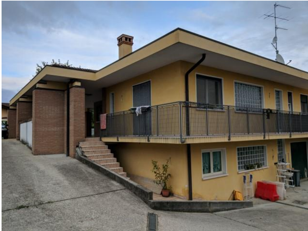
FOTO 9: ALTRA PANORAMICA DELL'IMMOBILE
