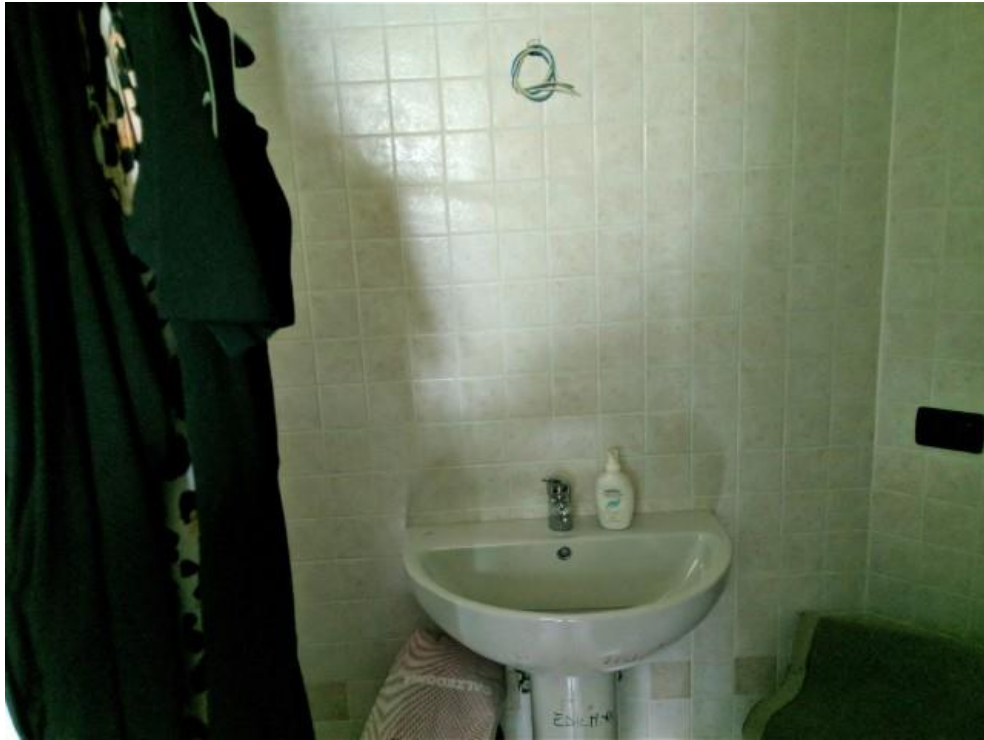
FOTO 21: WC DELLA CAMERA (Subalterno n. 1 – P.T.)
