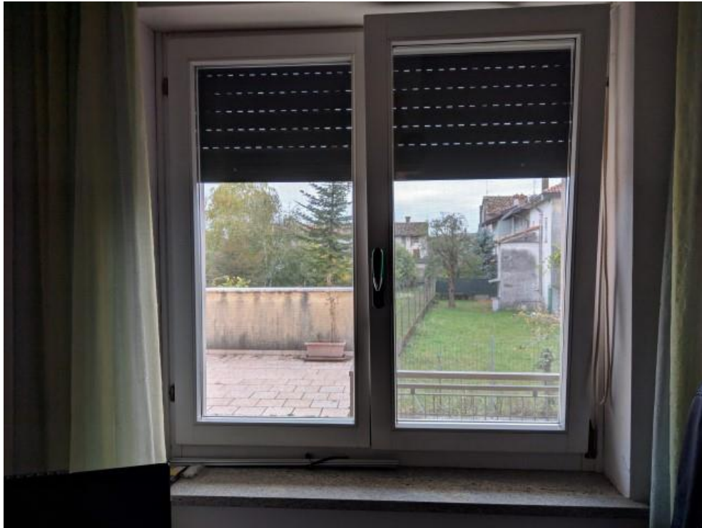
FOTO 27: PARTICOLARE SERRAMENTO LOCALI P.T.
