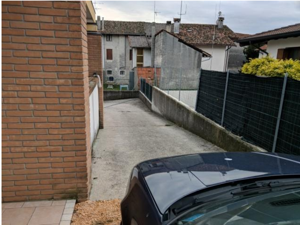
FOTO 49: RAMPA PER ACCESSO AL PIAZZALE DEL PIANO INTERRATO
