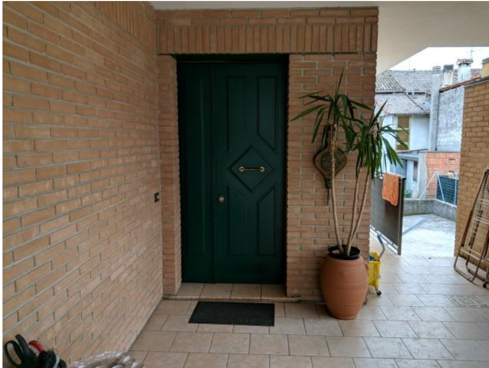
FOTO 13: PORTA D'INGRESSO DEI LOCALI AL PIANO TERRA
