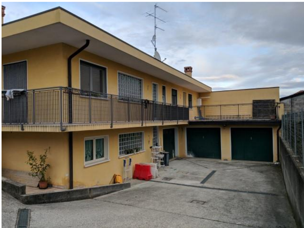
FOTO 10: ALTRA PANORAMICA DELL'IMMOBILE
