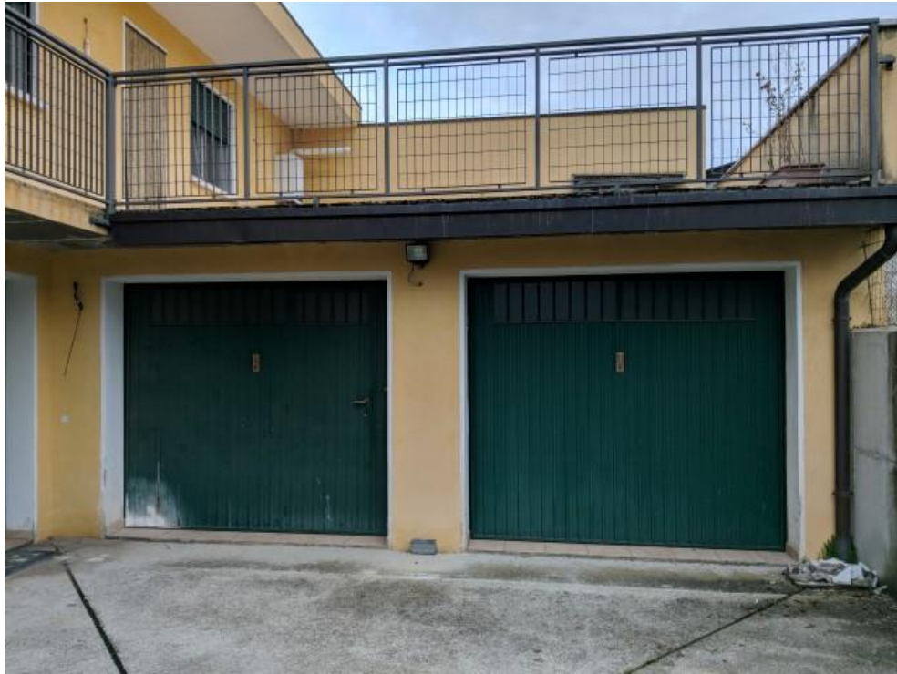
FOTO 45: ACCESSI DELLA TETTOIA DAL PIAZZALE AL P.INT.
