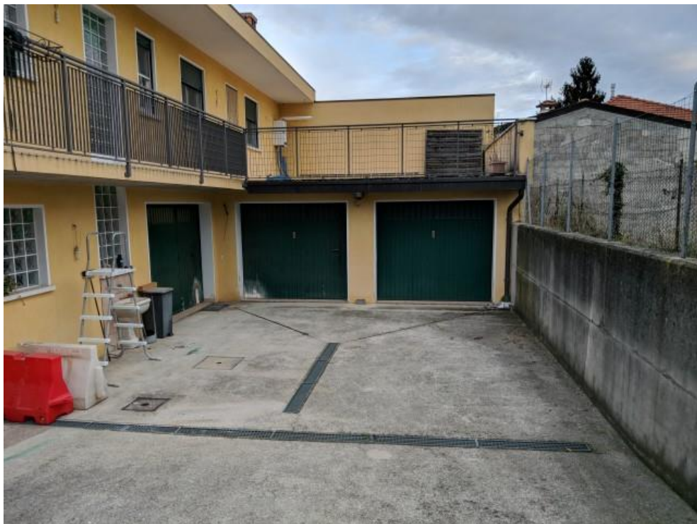
FOTO 50: PIAZZALE AREA MANOVRA AL PIANO INTERRATO
