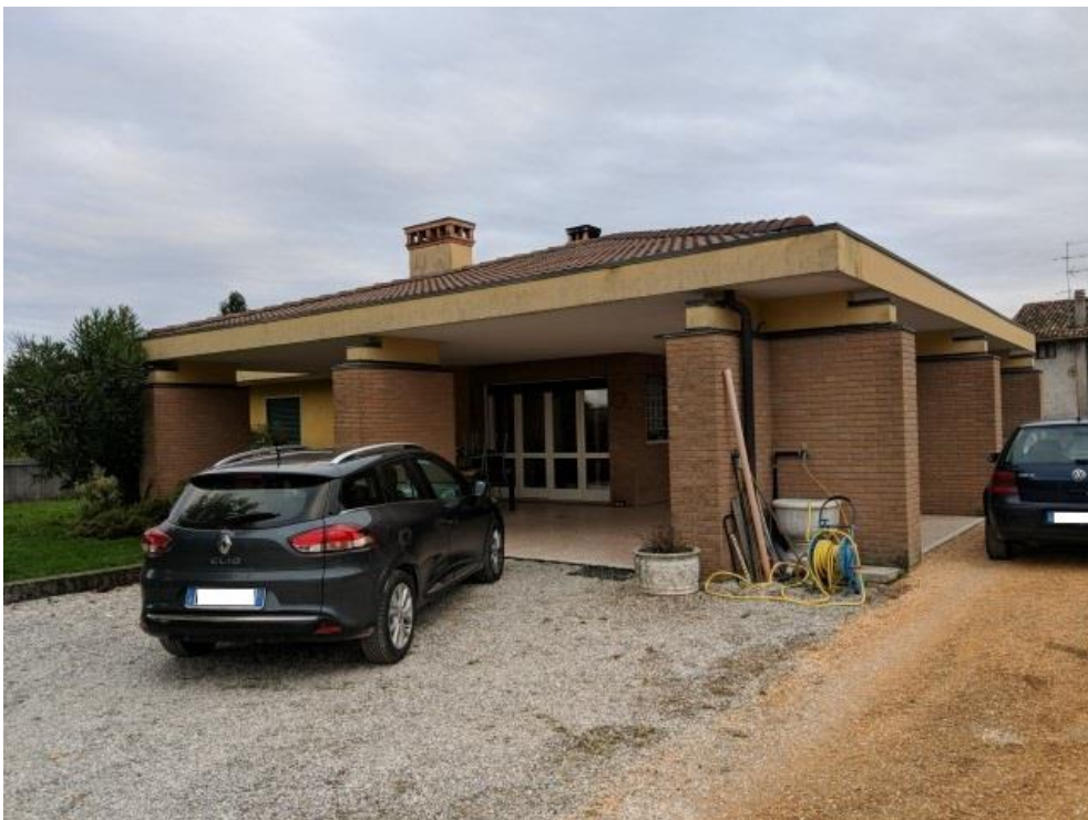
FOTO 12: PORTICATO D'INGRESSO AL PIANO TERRA
