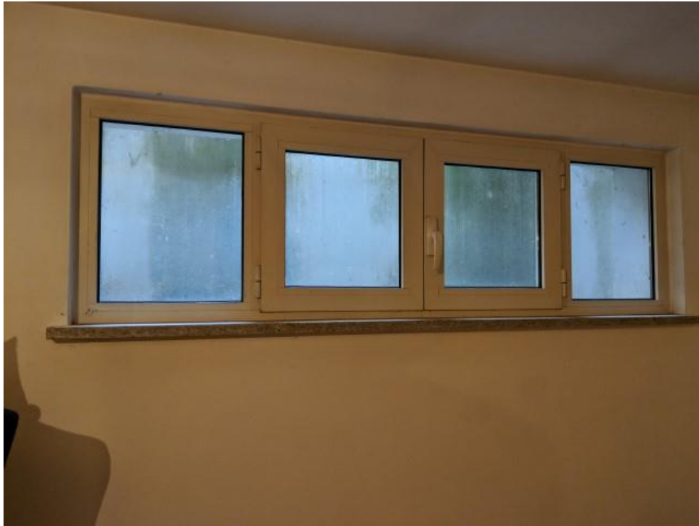
FOTO 43: PARTICOLARE SERRAMENTO AL P. INT.
