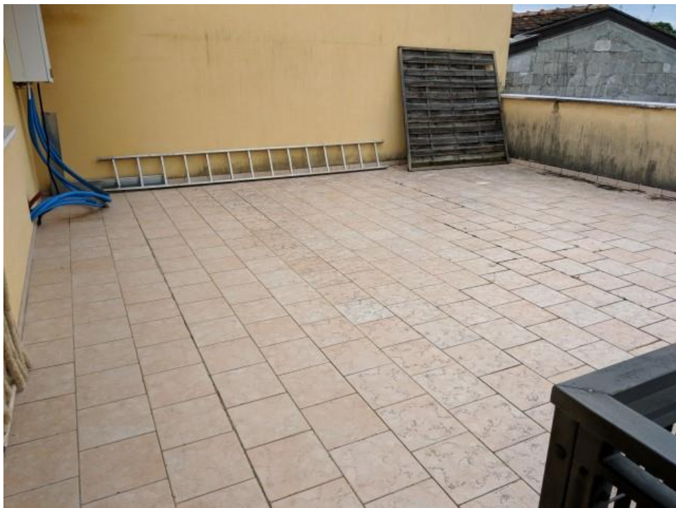
FOTO 48: TERRAZZO AL P.T. A COPERTURA DELLA TETTOIA AL P.INT.
