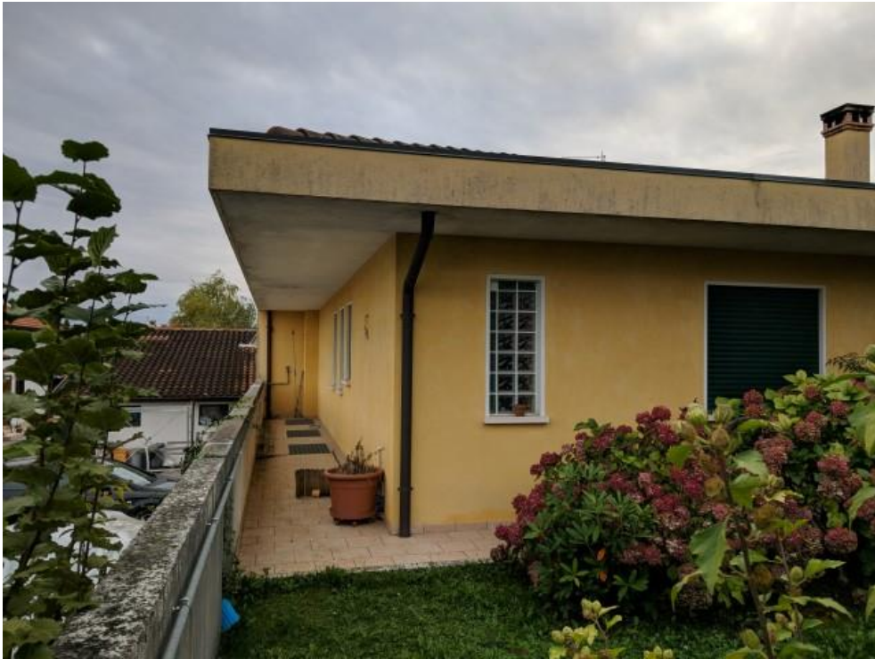
FOTO 11: ALTRA PANORAMICA DELL'IMMOBILE
