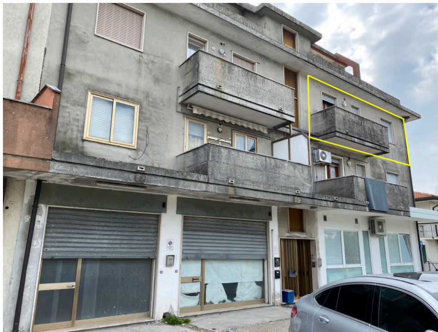
Vista esterna - Nord
