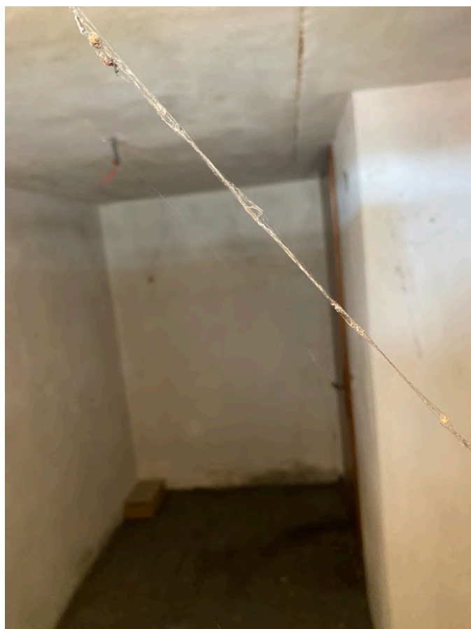
Magazzino piano terzo
