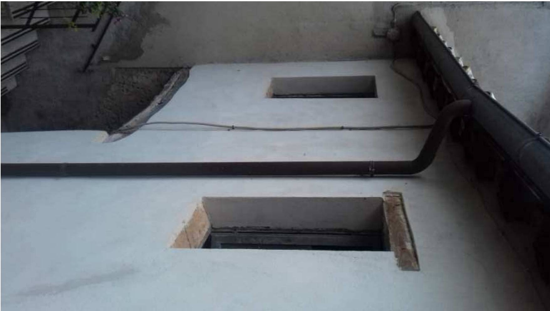
Vista prospetto principale
