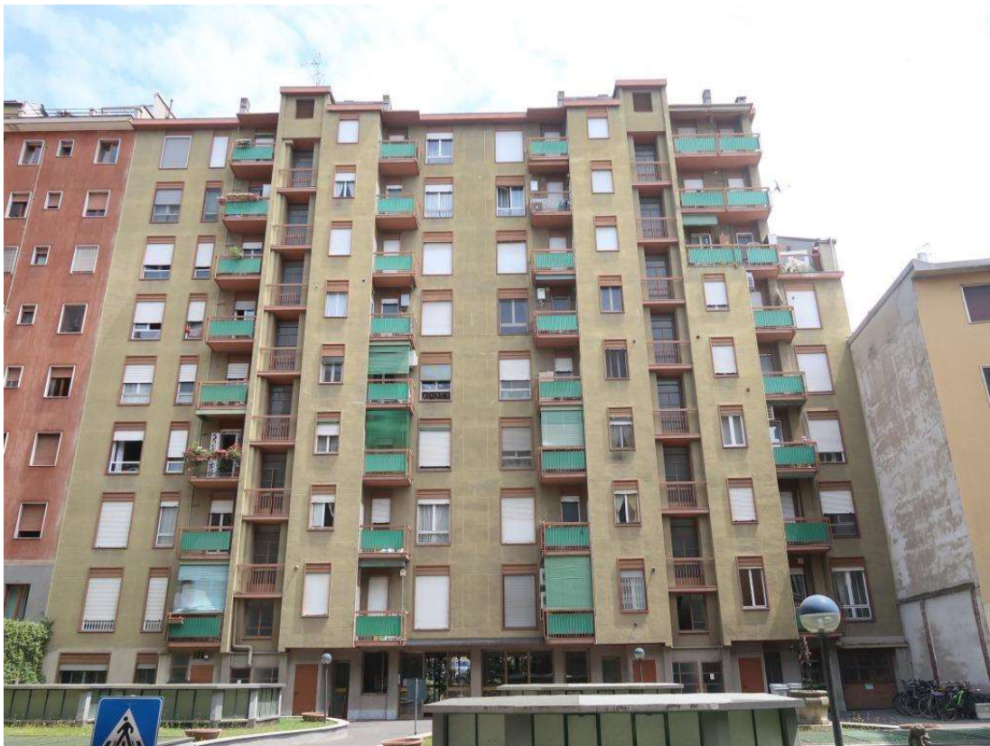
FACCIATA SU CORTILE INTERNO
