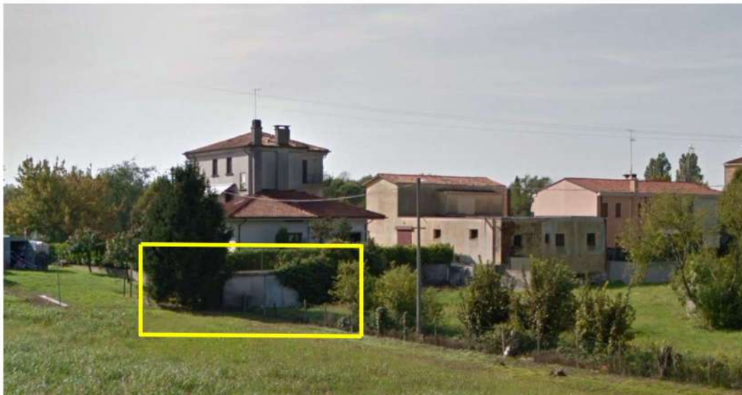
Vista del manufatto edilizio abusivo
