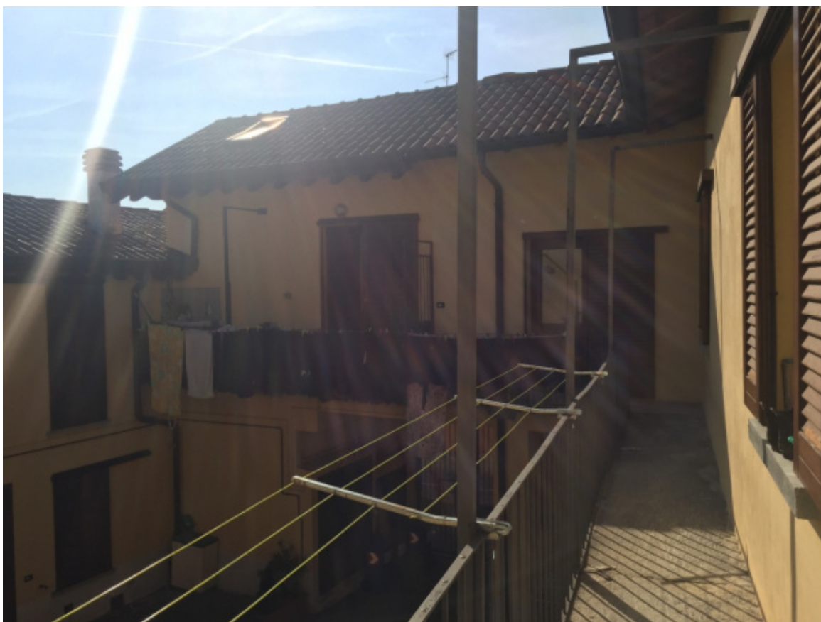
Foto 06 - Accesso all'unità dal ballatoio comune
