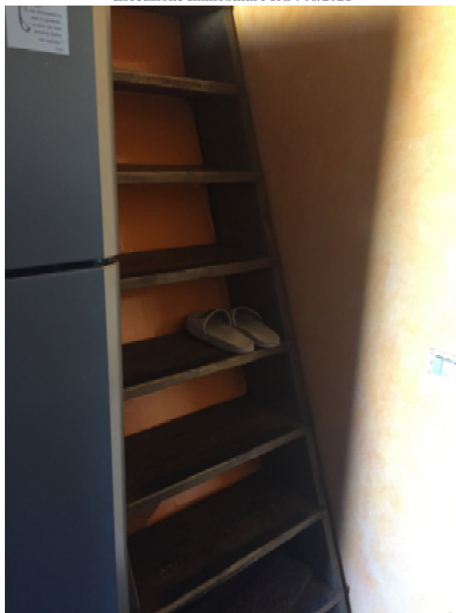
Foto 25 - Scala alla marinara di accesso al soppalco
