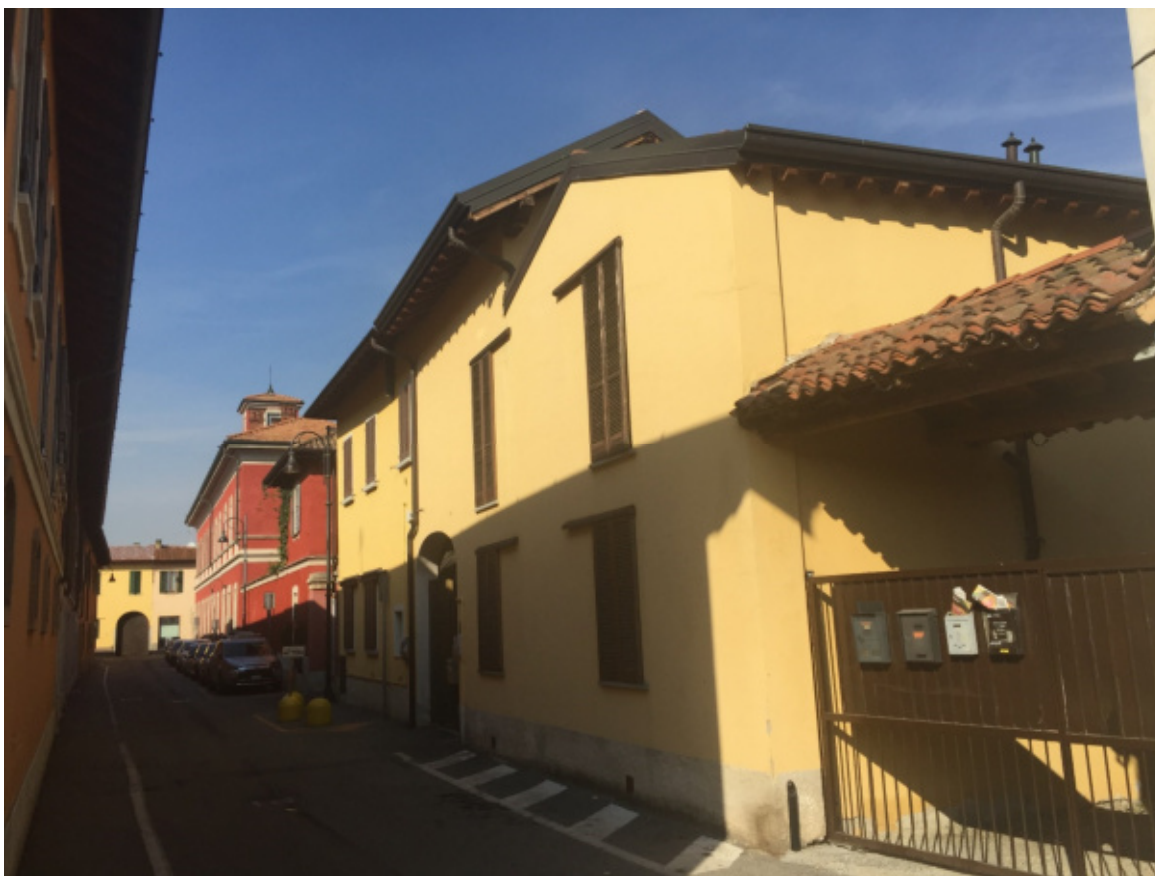
Foto 02 - Il fabbricato su via Garibaldi
