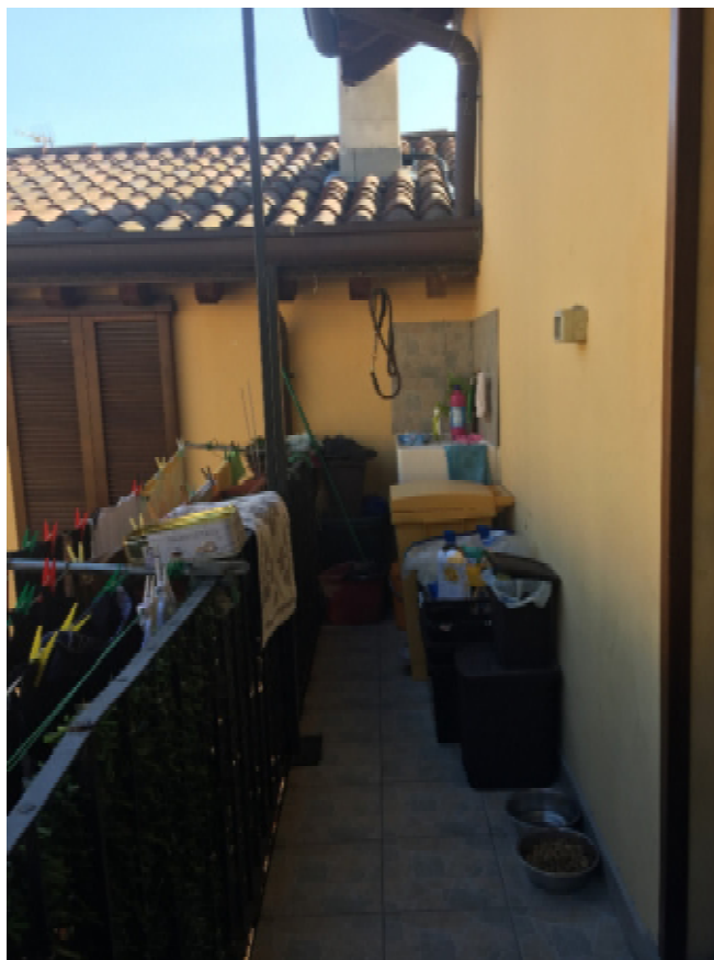
Foto 08 - Ballatoio di accesso all'unità
