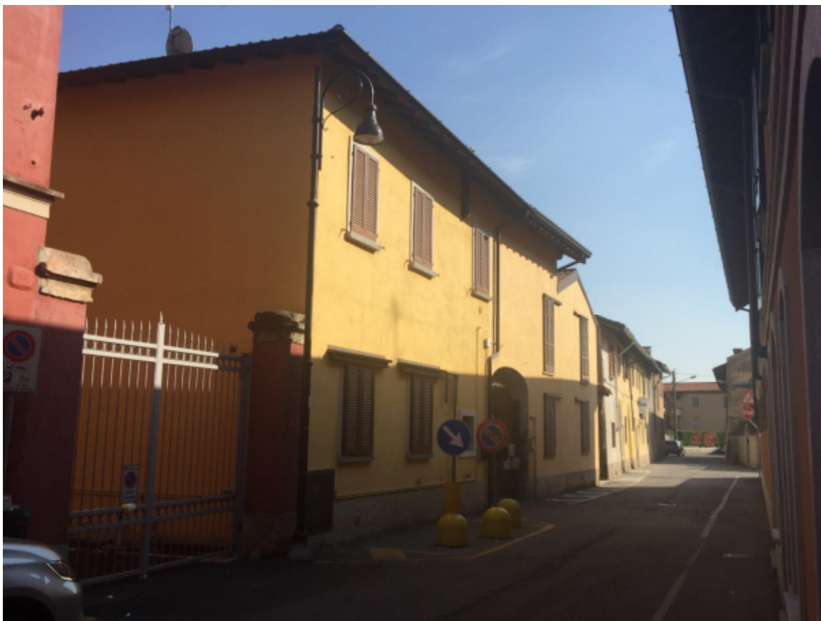
Foto 01 - Il fabbricato su via Garibaldi
