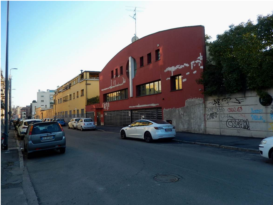
Foto 1 – Vista della facciata sulla via Guintellino.
