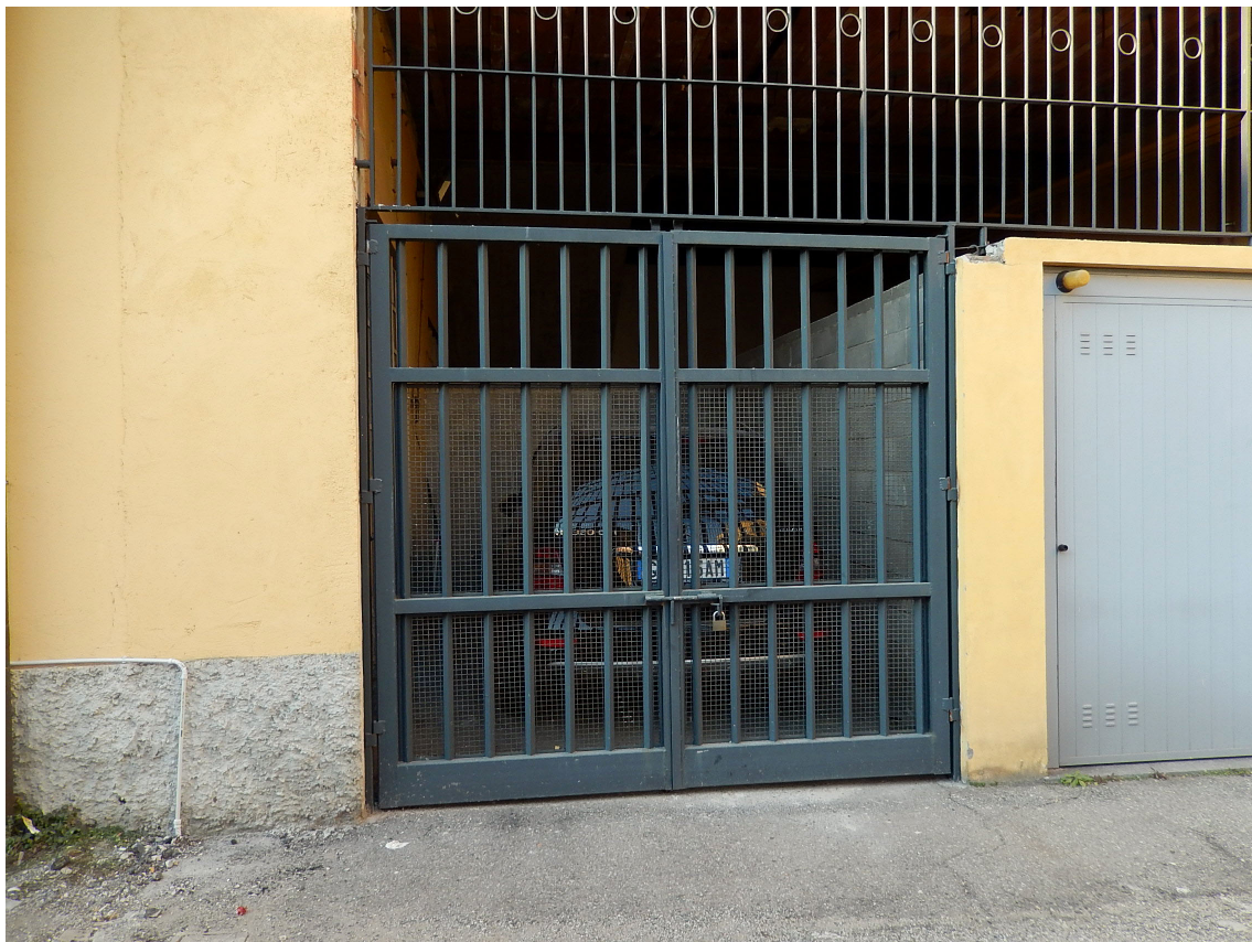
Foto 6 – Particolare del cancello.
