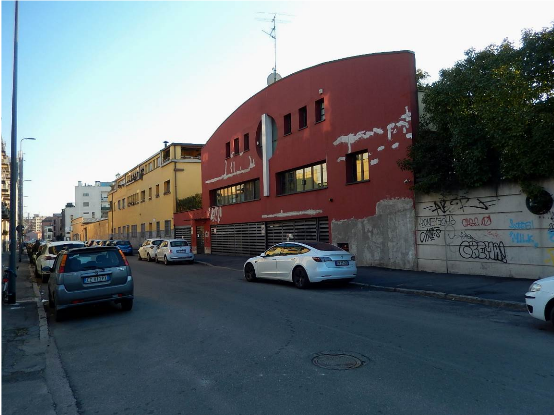
Foto 1 – Vista della facciata sulla via Guintellino.
