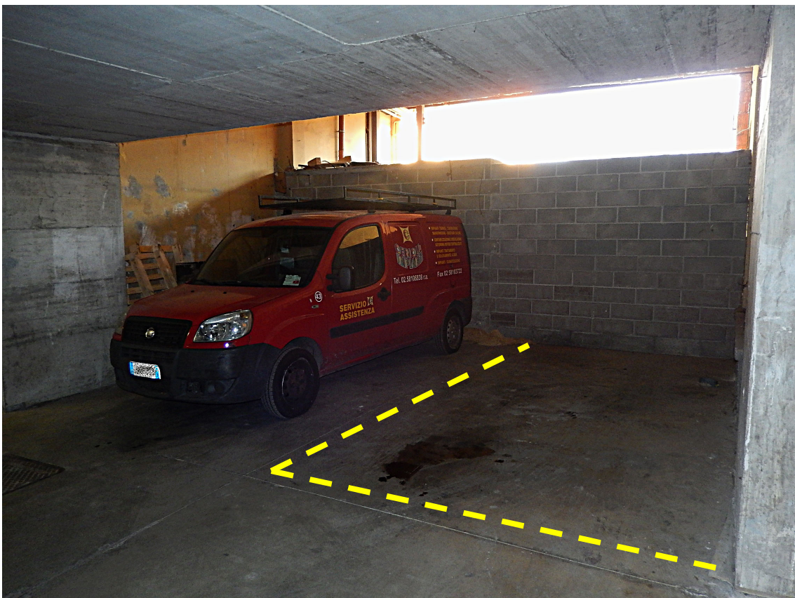
Foto 4 – Il posto auto in esame evidenziato dalla linea tratteggiata.
