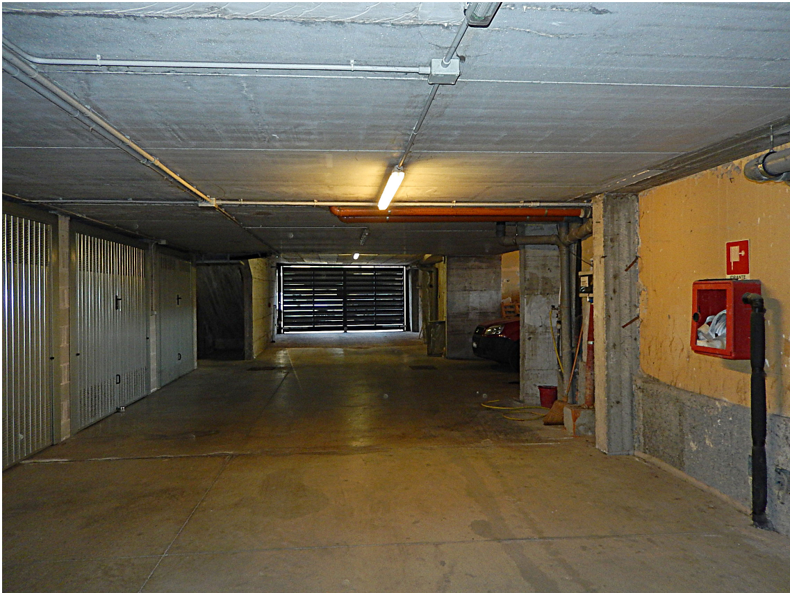
Foto 3 – Vista del corsello di manovra verso l'uscita.
