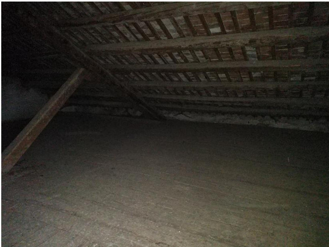
Foto 28 Particolare della struttura di copertura.
