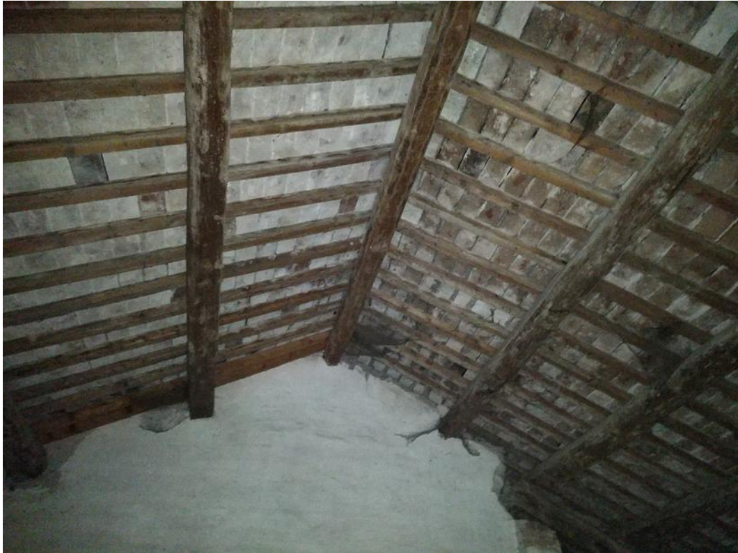
Foto 27 Particolare della struttura di copertura.
