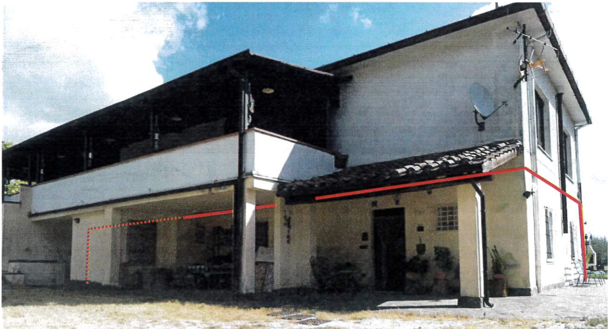
2) Ingresso dal civico 2 - prospetto sud-ovest (il portico a destra ricade su u.i. sub 11)
