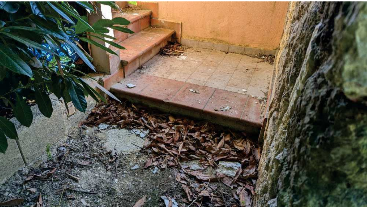
Fotografia n. 8 (Inizio rampa scala)
