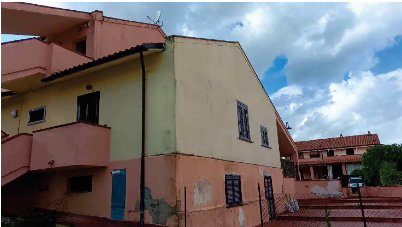
Fotografia n. 3 (vista facciata Ovest)
