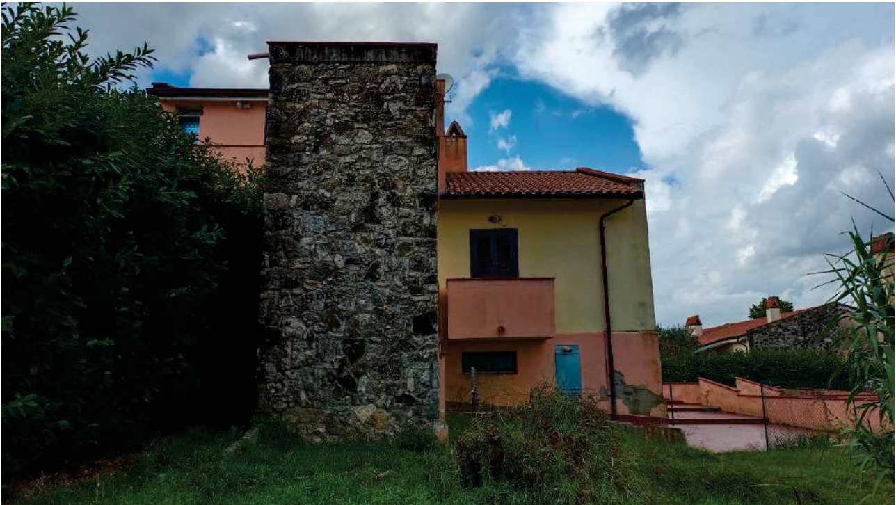
Fotografia n. 1 (vista facciata Sud)
