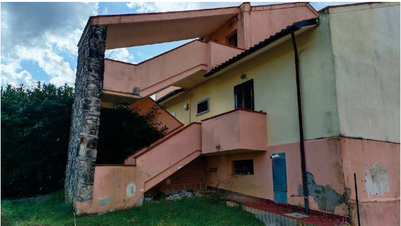
Fotografia n. 2 (vista scala lato Ovest)
