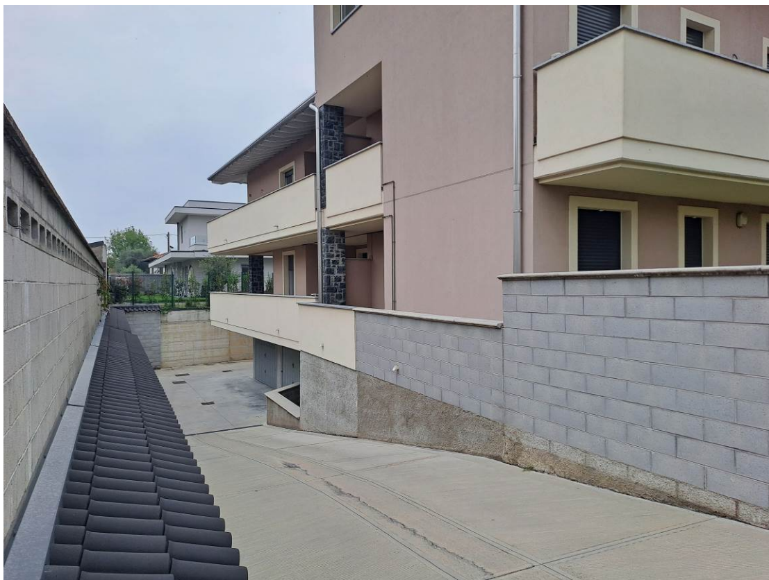
Foto 15 – Vista d'insieme della rampa dei box.
