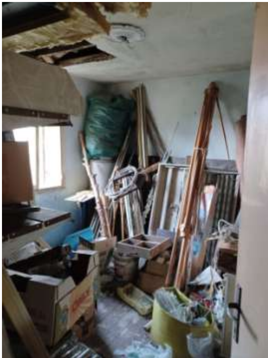
Lotto 01 – corpo A – interni primo livello
