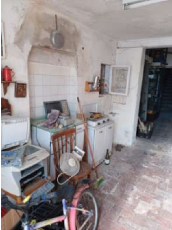
Lotto 01 – corpo B – interno abitazione unifamiliare
