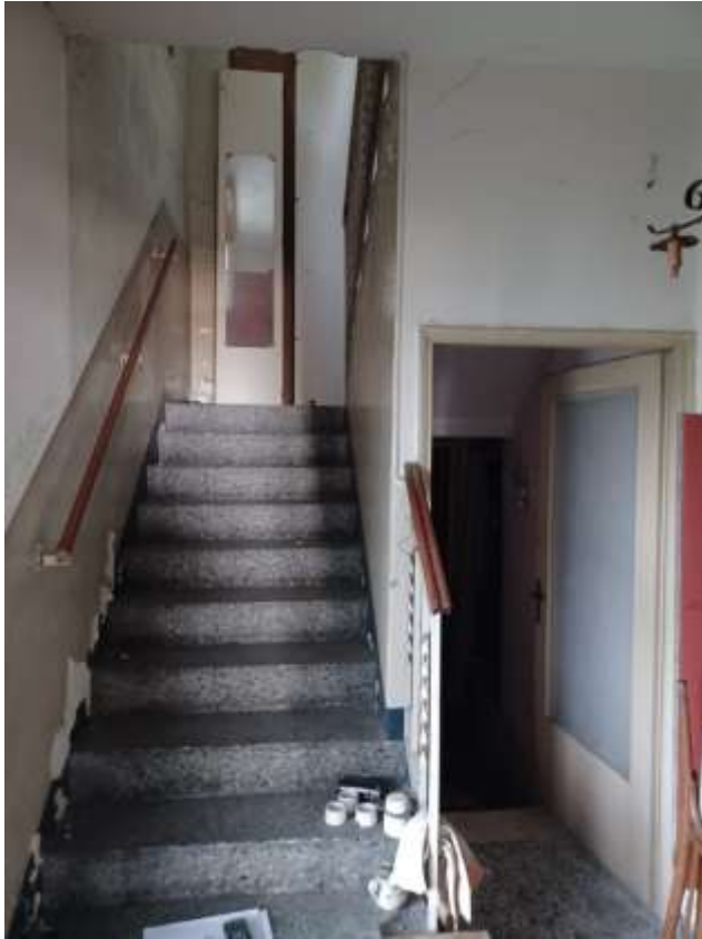
Lotto 01 – corpo A – interno abitazione unifamiliare
