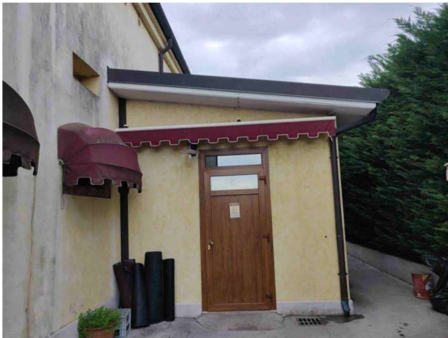
foto 18: veduta esterna del volume di ampliamento della cucina
