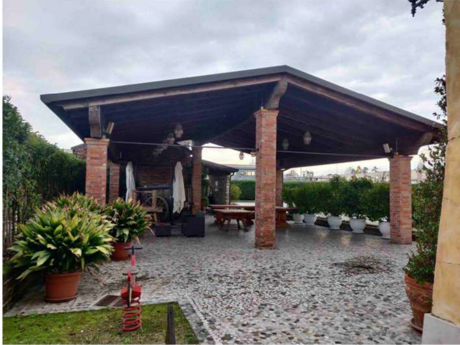
foto 19: veduta della tettoia presente nell'area esterna
