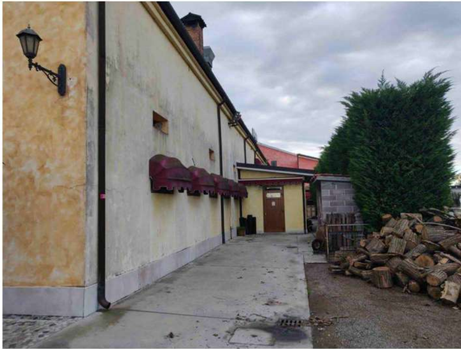
foto 17: veduta esterna dell'edificio ove visibili il volume esterno di ampliamento della cucina
