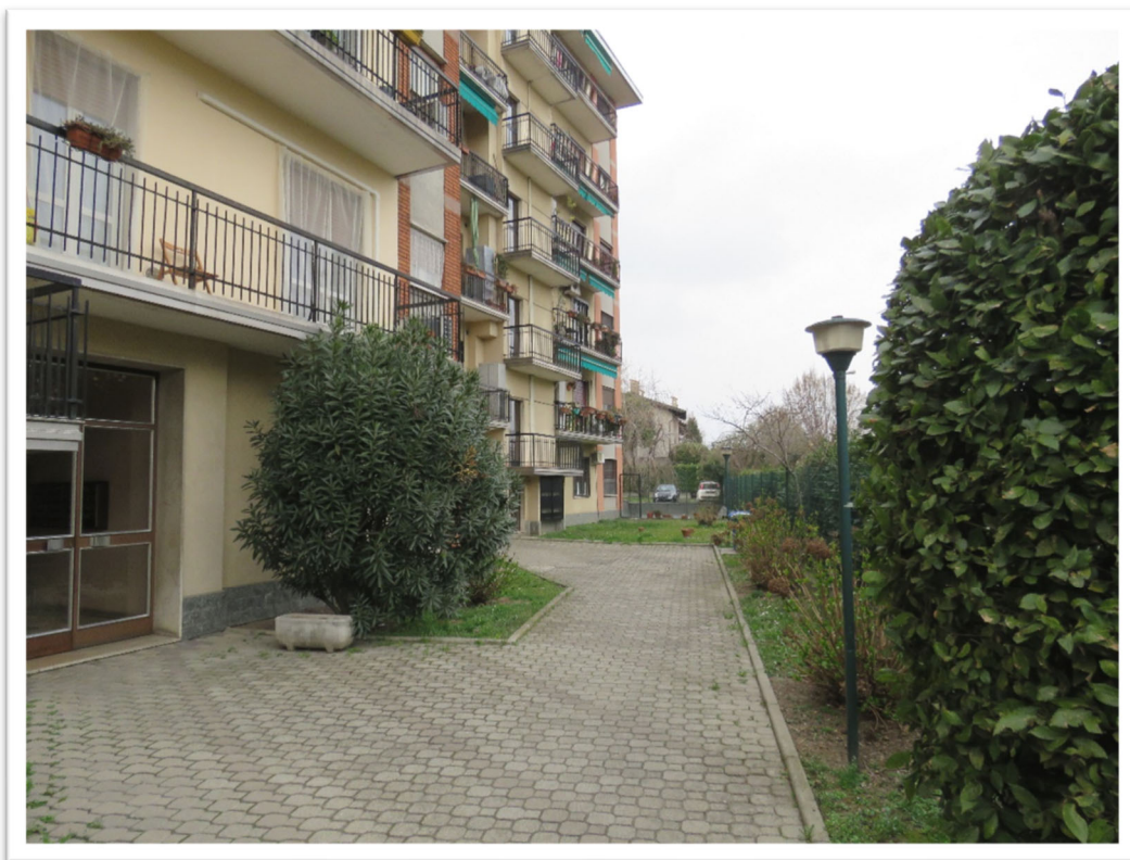
Particolare del percorso condominiale esterno e (sotto) vista della palazzina n. 4 .
