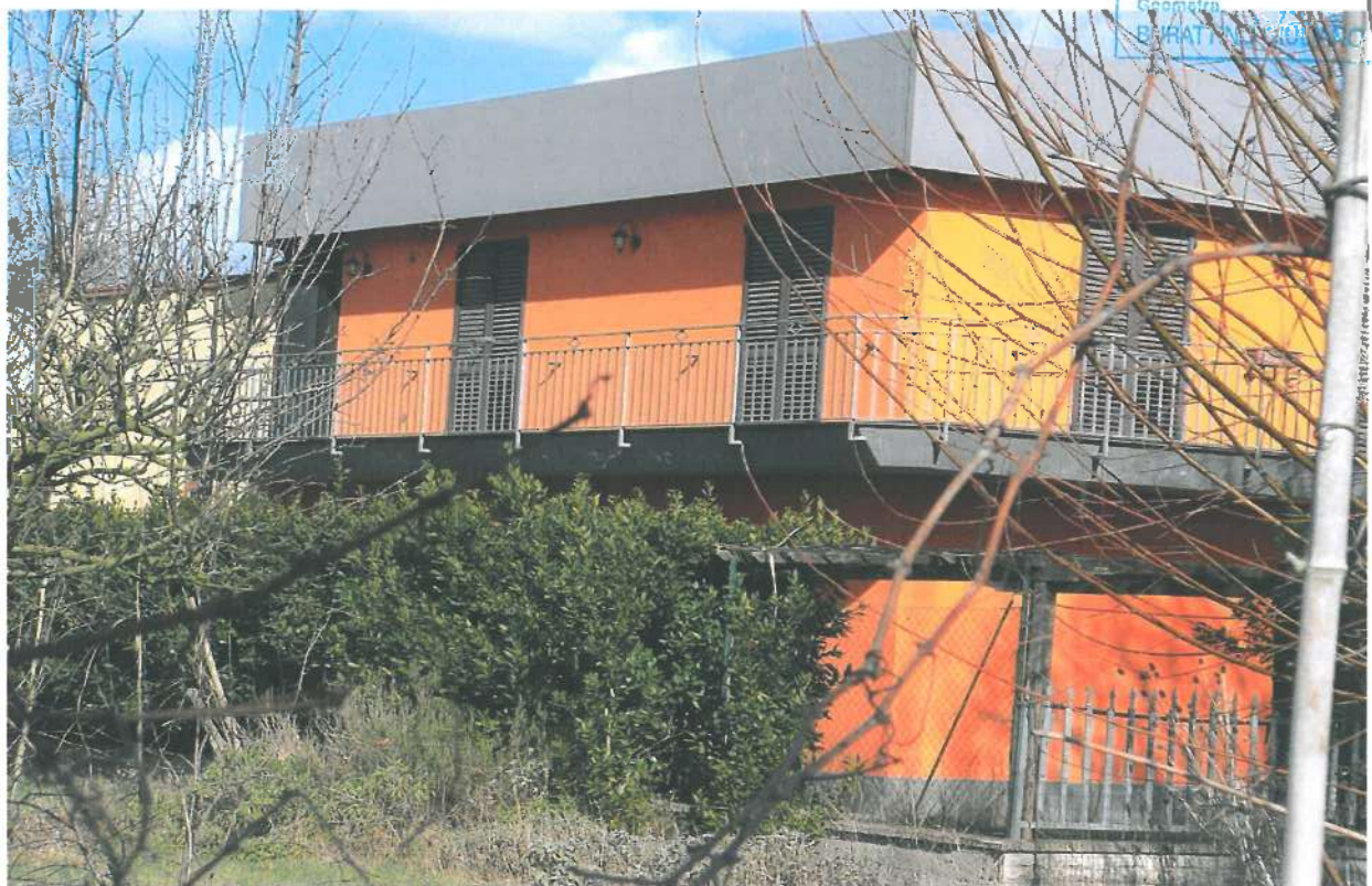
Prospetto lato SUD-OVEST (Abitazione)
