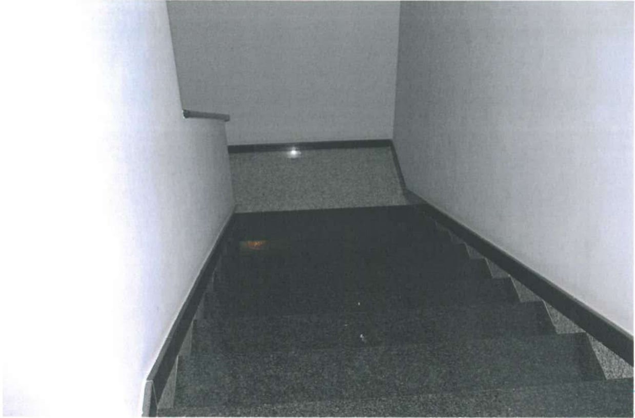
Scala di accesso Abitazione piano primo
