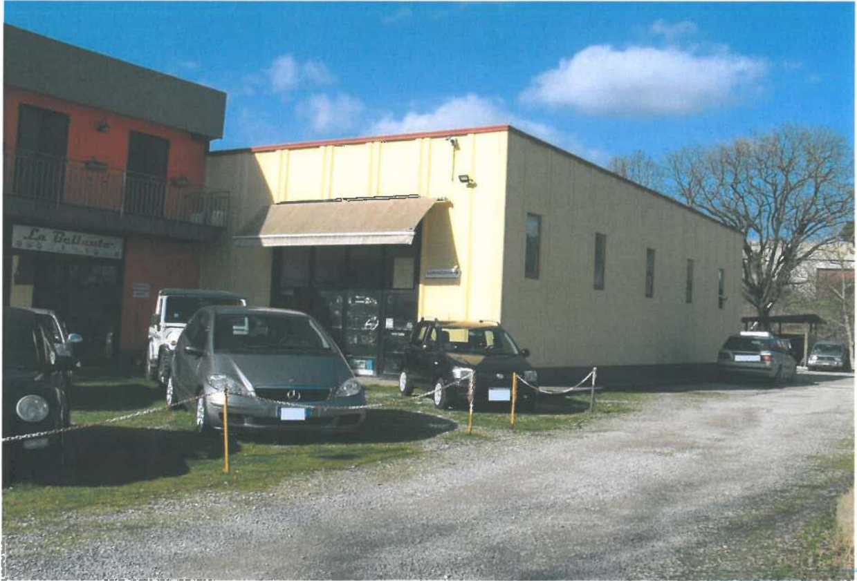
Prospetto lato SUD-EST (Autocarrozzeria)
