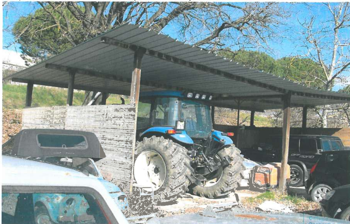
Tettoia per ricovero attrezzi e automezzi (non autorizzata) Lato Nord-Ovest
