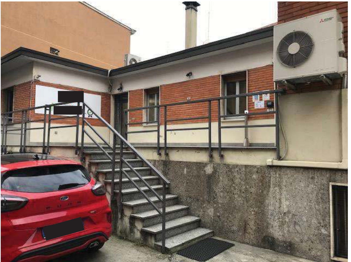
Scala di accesso al terrazzo
