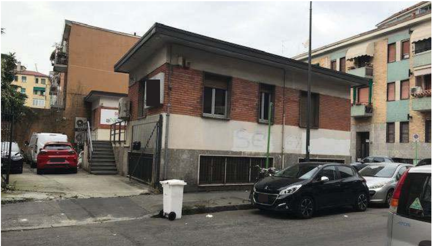
Vista cortile e ingresso al civico 1
