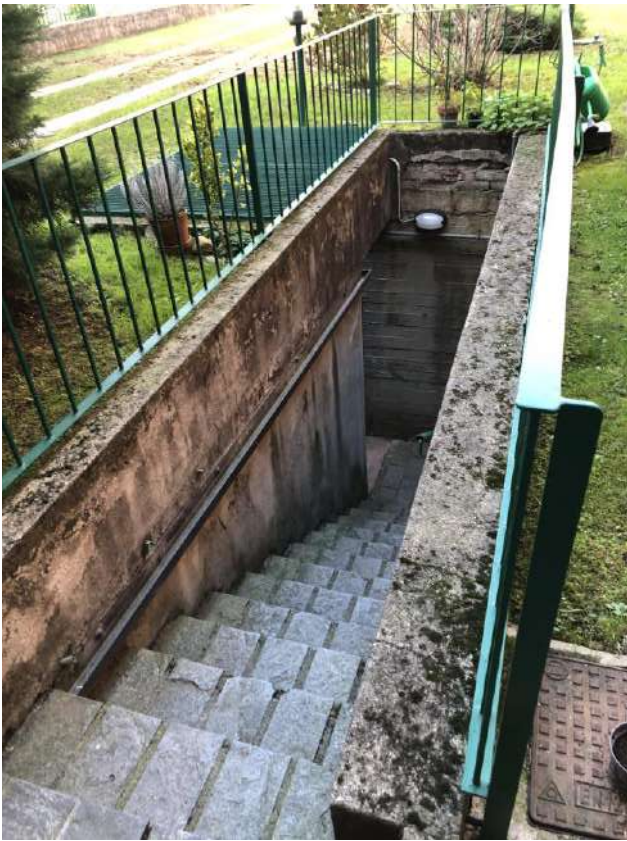
Vista scala esterna accesso ai box
