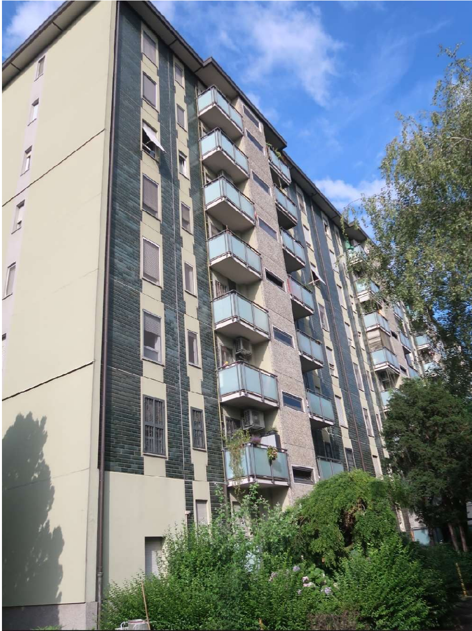
FACCIATA SU INGRESSO
