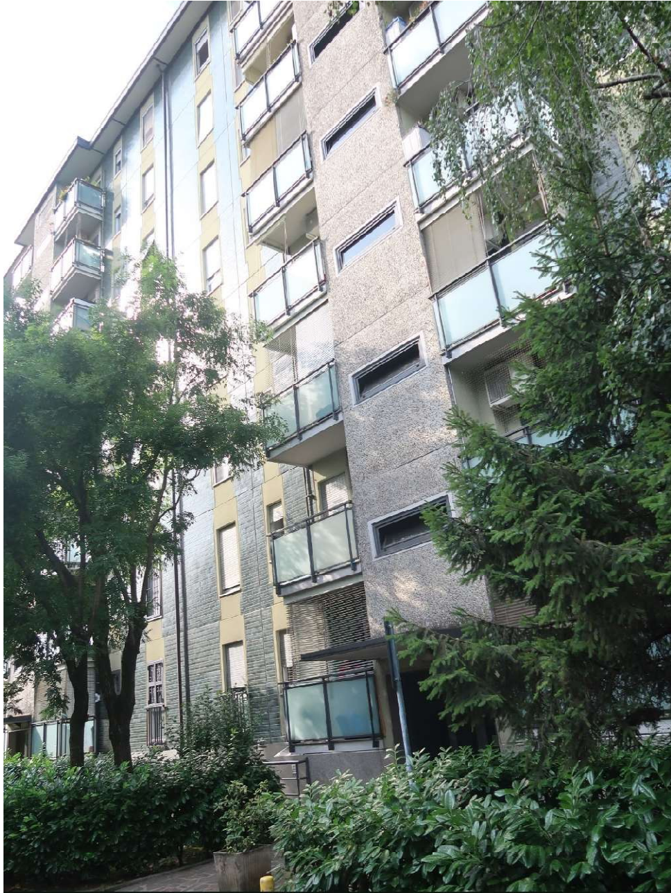
FACCIATA SU INGRESSO
